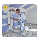
Es erfolgt die waagerechte Ausrichtung der Abziehschienen - die integrierten Wasserwaagen erleichtern die Ebenheit 5.
