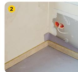
Bei Brandschutzkonstruktionen ist gemäß Zulassung der Rigips Mineralwolle-Randdämmstreifen zu verwenden. Bei der Anbringung der Randdämmstreifen ist zu beachten, dass diese eng an der Wandfläche anliegen und bis in die Raumecken reichen. Sie dürfen keinesfalls im Bogen verlegt angebracht werden. Die Schüttung muss die Raumecken vollflächig ausfüllen **2**.
