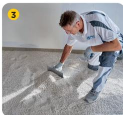
Bei höheren Schüttungen parallele Dämme in entsprechender Höhe aufschütten und darauf Abziehschienen ausrichten **4**.
