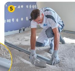
Durch das gleichmäßige Abziehen der Abziehlehre über die Schienen wird eine planebene Oberfläche erreicht.
