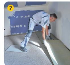
Bei der Verlegung von Trittschall-dämmplatten ISOVER Akustic EP 3 ist eine lastabtragende Plattenlage auf der Schüttung nicht zwingend notwendig und die Trittschalldämmplatte ausreichend **8**.
