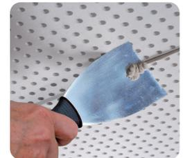
Nach ca. 3 Stunden die Fugenbereiche und überspachtelten Schraubenköpfe abschließend schleifen und für die weitere Oberflächenbehandlung vorbereiten.
