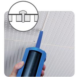
Die Schraubenköpfe leicht erhöht mit Hilfe einer Rigips Schraubenkopfschablone überspachteln.
