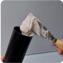
Den fertig (etwas dünner - ca. 2,8 l Wasser auf 5 kg VARIO Spachtelmaterial) angerührten VARIO Fugenspachtel zügig in die leicht schräg gestellte Kartusche einfüllen.
