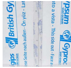
Rigips Glasroc X-Platten, Stoß mit Fugenband abgeklebt
