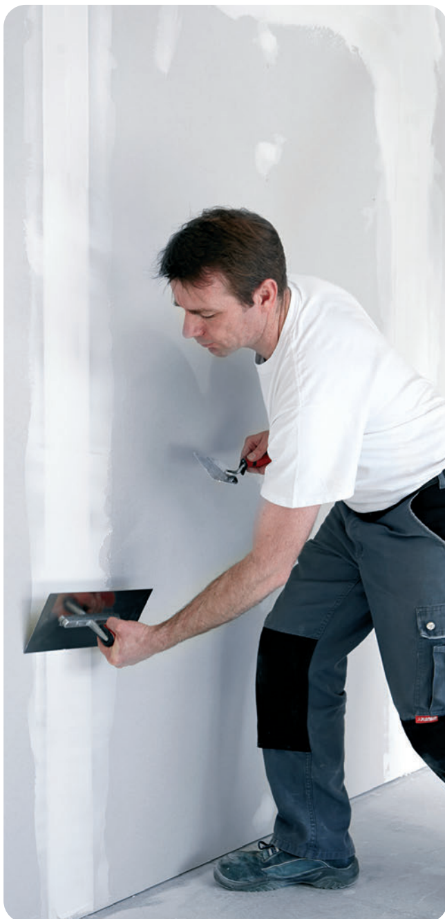
Der ProMix Finish wird auf den Untergrund mithilfe eines Glättspachtels aufgetragen.
