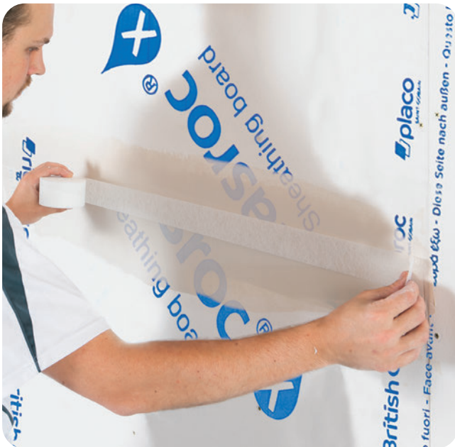
... und unmittelbares Einlegen des Rigips Glasfaserbewehrungsstreifens.
