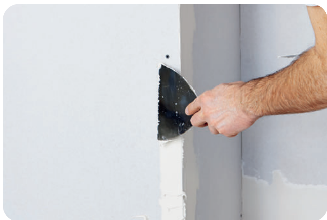
Vorlegen eines dünnen Spachtelbettes.
