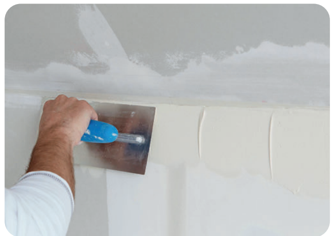
... und Vorlegen des Fugenspachtels.
