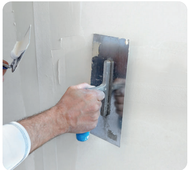
Nach dem Abbinden des Fugenspachtels kann die Nachspachtelung erfolgen.
