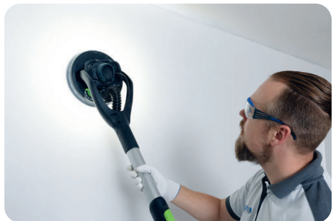
Falls erforderlich, maschinell mit einem 240er- bis 280er Schleifpapier oder manuell mit einem 240er-Schleifpapier abschleifen.
