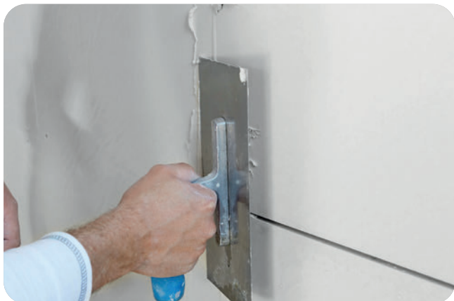
Ausdrücken der Querfugen mit VARIO Fugenspachtel, ...
