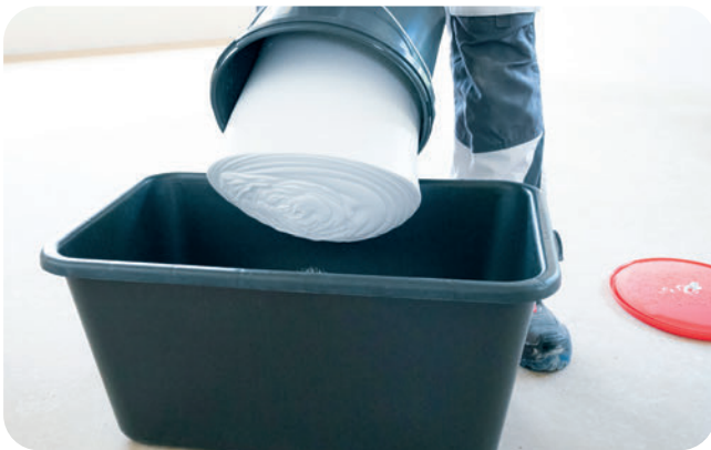
Den ProMix Airless einfach wie eine Teigkugel in eine Mörtelwanne kippen.
