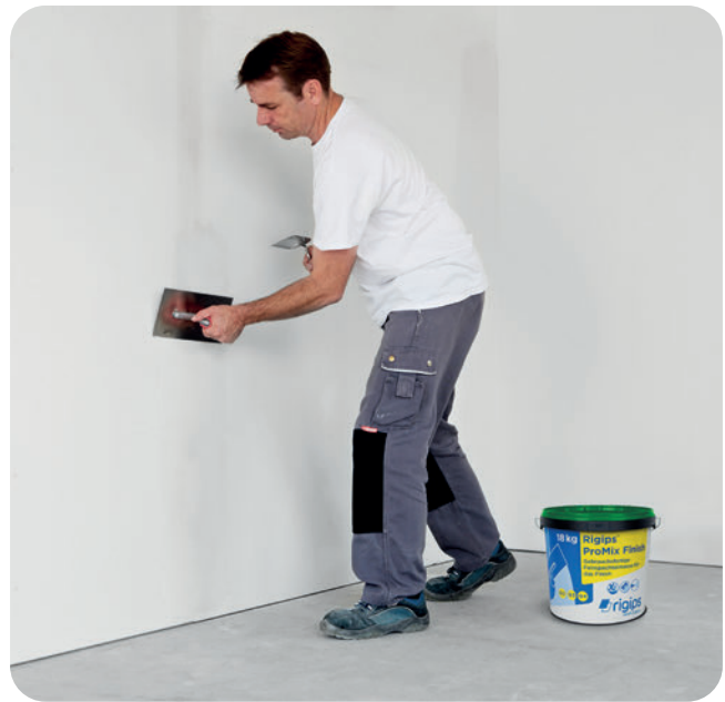
Danach das Fugenfinish mit ProMix Finish durchführen.
