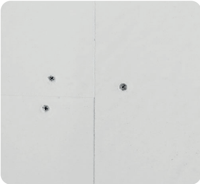
Die Platten werden stumpf gegeneinander gestoßen und befestigt.
