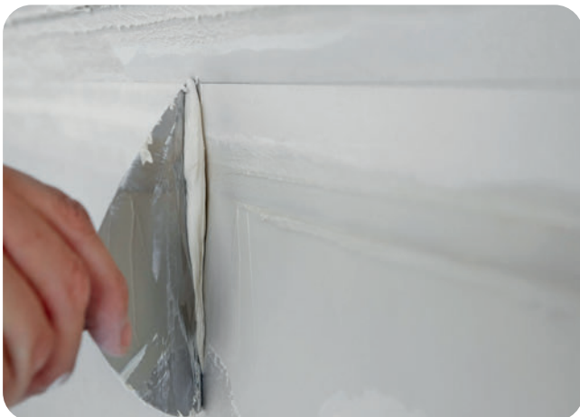
Abziehen des überschüssigen Fugenspachtels.
