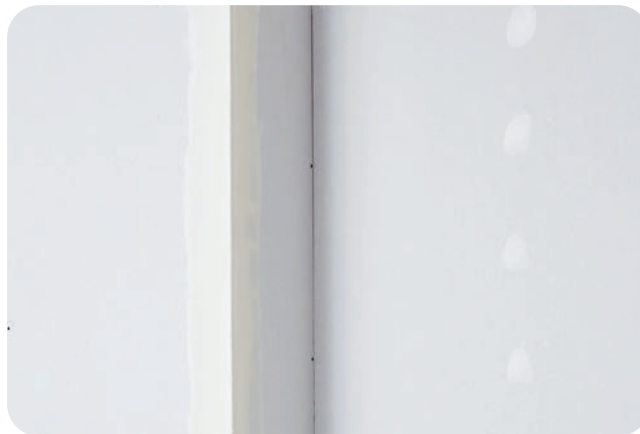
Fertige Außenkante mit Rigips Levelline.
