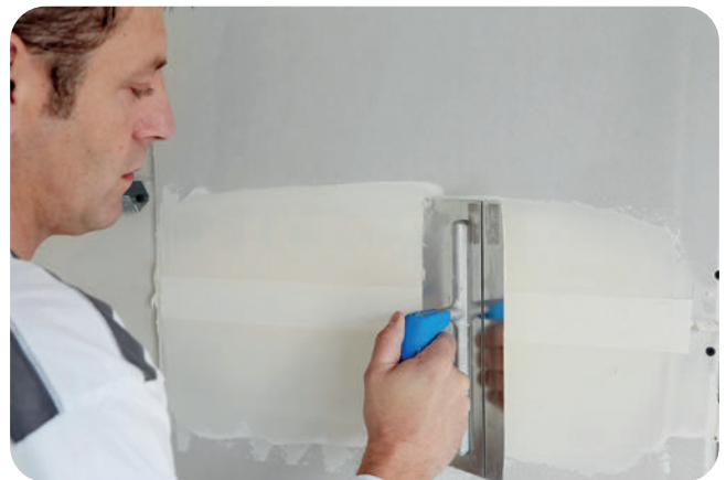
Einbetten des Rigips Papierbewehrungsstreifens ohne zusätzlichen Materialauftrag.
