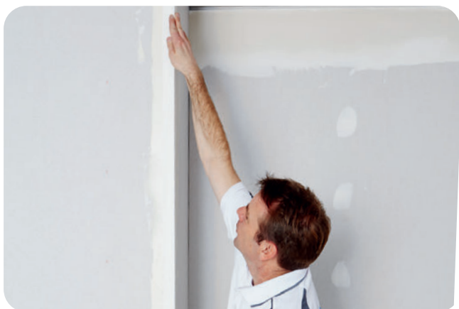
Ausrichten des Rigips Levelline.
