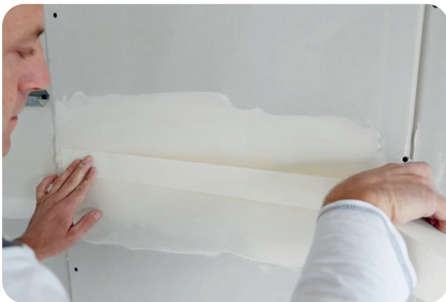
Vorsichtiges Einlegen des Rigips Papierbewehrungsstreifens.
