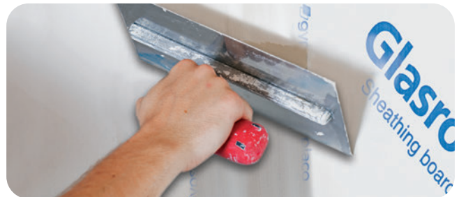
Rigips Glasfaserbewehrungsstreifen einlegen und entsprechend ablängen.
