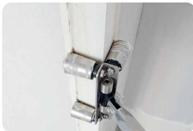
Anpressen mit dem Rigips Außenkantenroller.
