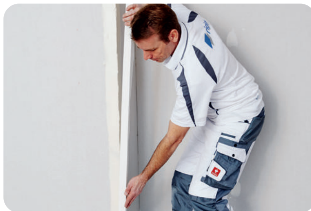
Ansetzen des Rigips Levelline.
