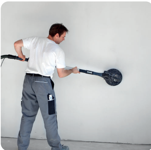
Eventuell Spachtelgrate manuell oder maschinell nachschleifen.
