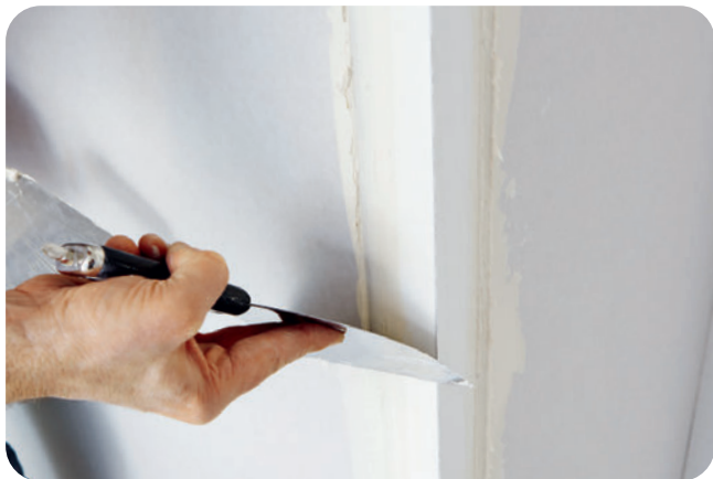
Überflüssige Spachtelmasse wegnehmen und den Rest ausziehen.
