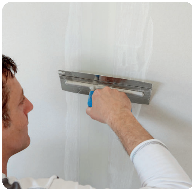
Überziehen des Glasfaserbewehrungsstreifens ohne zusätzlichen Materialauftrag.
