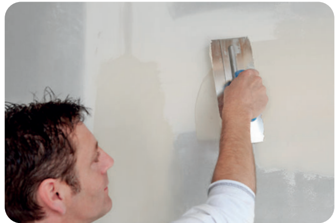
... erfolgt die Nachspachtelung bei den Quer- und Längsfugen.
