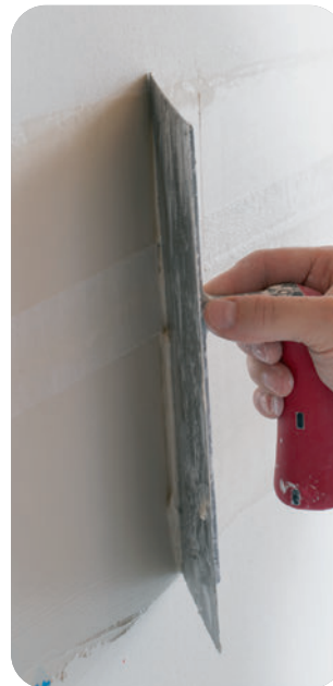
Überziehen des Rigips Glasfaserbewehrungsstreifens ohne zusätzlichen Materialauftrag.
