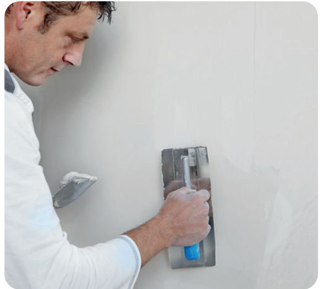
Der VARIO Fugenspachtel wird aufgebracht und flächenbündig abgezogen.
