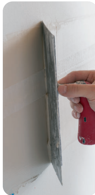
Überziehen des Rigips Glasfaserbewehrungsstreifens ohne zusätzlichen Materialauftrag.
