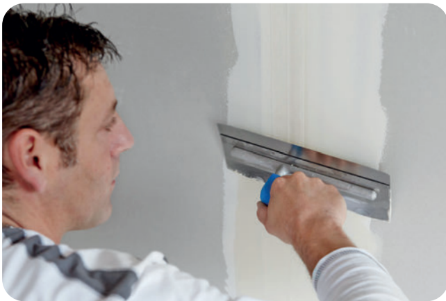
Nach ausreichender Trocknung des ProMix Plus ...
