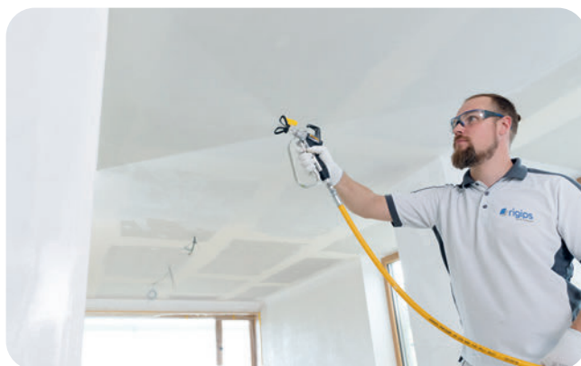
Rigips ProMix Airless in gleichmäßigen Bewegungen vollflächig auf die Wandoberfläche aufbringen.
