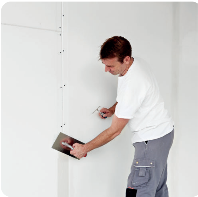
Zunächst die technischeerspachtelung im VARIO-System durchführen. (Siehe S. 32)
