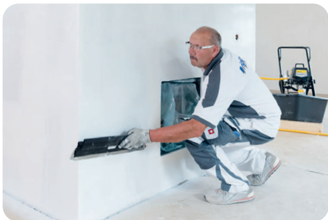
Die frisch aufgetragene Spachtelmasse mit einem Flächenspachtel glatt abziehen und vollständig trocknen lassen.
