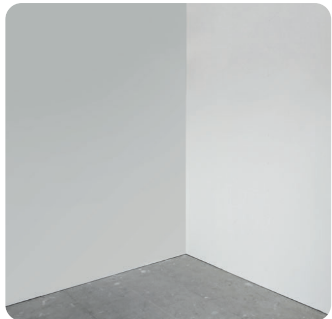
Überzeugendes Resultat: eine makellose weiße Oberfläche. Die technische Fugenerspachtelung wurde komplett mit VARIO Fugenerspachtel vorgenommen und die Q3-Qualität dann mit dem ProMix Finish vollendet.
