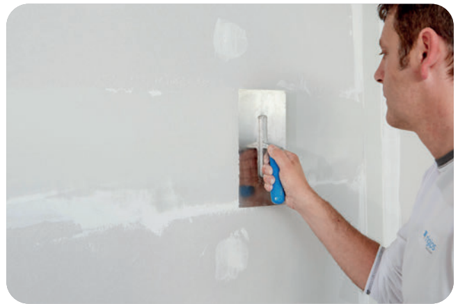
Überziehen des Rigips Glasfaserbewehrungsstreifens ohne zusätzlichen Materialauftrag.
