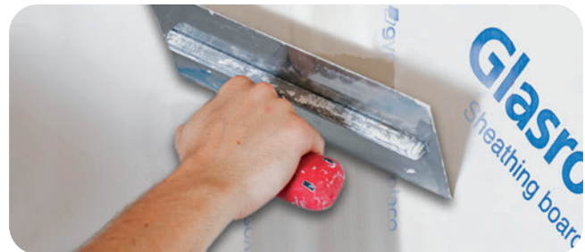
Rigips Glasfaserbewehrungsstreifen einlegen und entsprechend ablängen.
