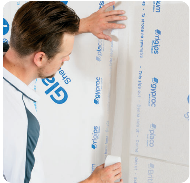
Rigips Glasfaserbewehrungsstreifen einlegen und entsprechend ablängen.
