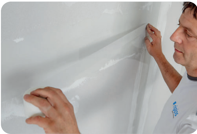
... und unmittelbares Einlegen des Rigips Glasfaserbewehrungsstreifens.
