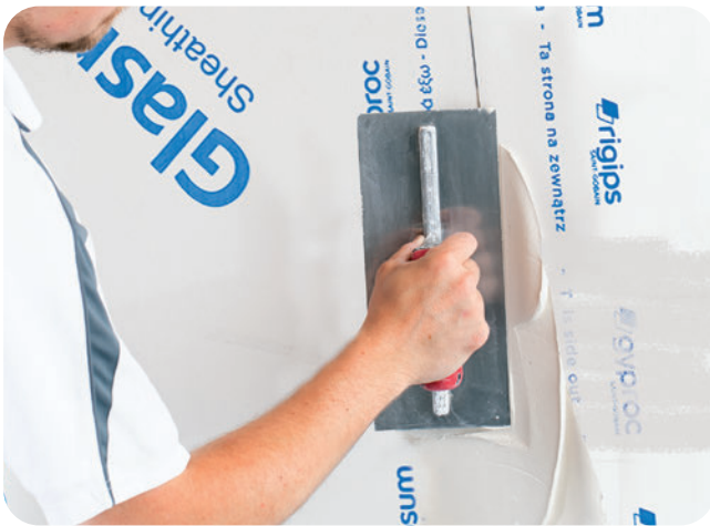
Die Längsfugen mit VARIO H Fugen- und Flächenspachtel quer zur Fuge verfüllen.
