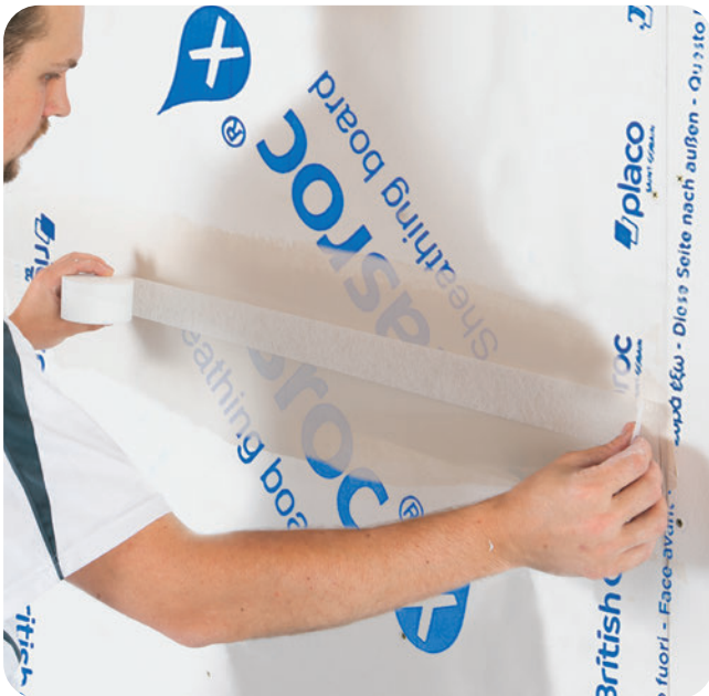
... und unmittelbares Einlegen des Rigips Glasfaserbewehrungsstreifens.
