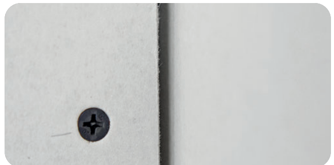
Linke Platte: gefaste Kante an Rechte Platte: VARIO-Kante
