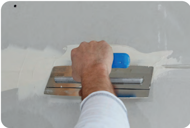
Ausdrücken der Querfugen.
