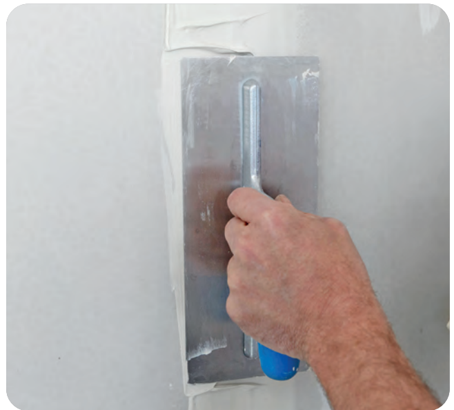
Es erfolgt danach das Abziehen der verfüllten Fugen.
