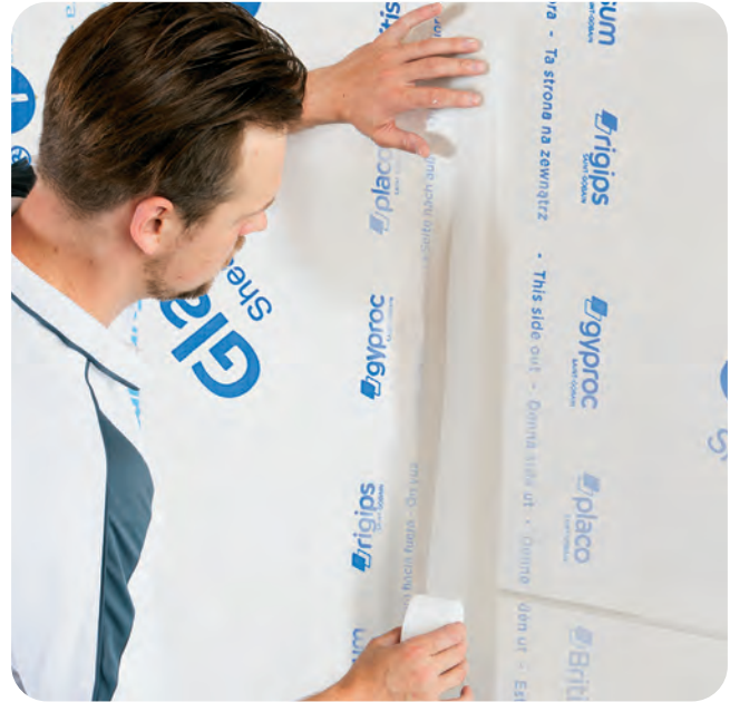
Rigips Glasfaserbewehrungsstreifen einlegen und entsprechend ablängen.
