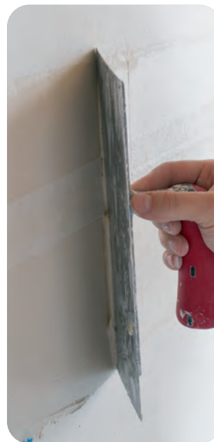
Überziehen des Rigips Glasfaserbewehrungsstreifens ohne zusätzlichen Materialauftrag.
