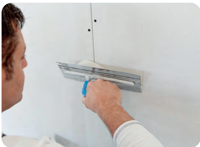
Die Längskante mit SUPER Fugenfüller ausspachteln.
