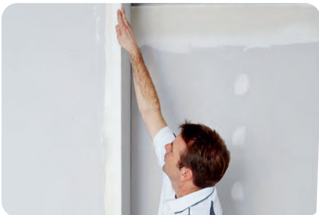
Ausrichten des Rigips Levelline.
