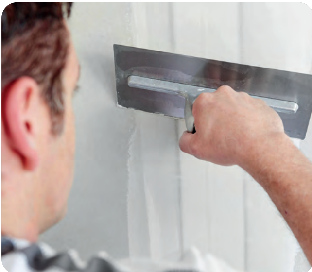
Es ist auf ein blasenfreies Verfllen der Fugen zu achten.
