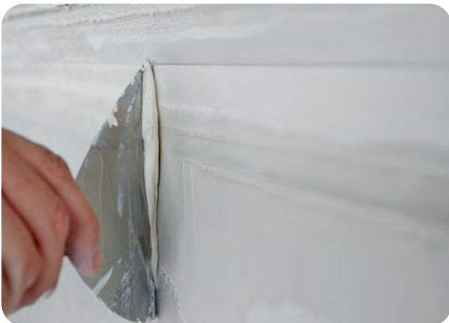
Abziehen des überschüssigen Fugenspachtels.
