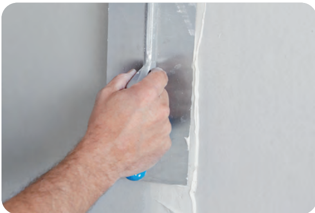
Die Längsfugen werden mit Spachtelmaterial ausgedrückt.
