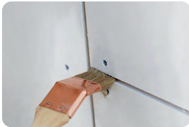
Die Plattenkanten müssen entstaubt und vorgesenst werden.
