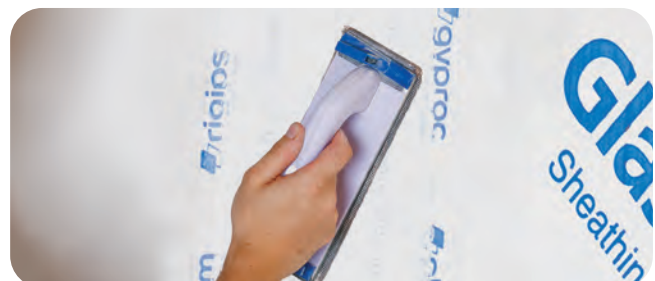
Nach ausreichender Trocknung erfolgt die Nachspachtelung mit dem VARIO H Fugen- und Flächenspachtel. Abhängig von der Anforderung der Oberflächenqualität kann noch ein Schleifen bzw. ein weiterer Überzug mit Spachtelmaterial bis zur Erreichung der geforderten Qualitätsstufe notwendig sein.
