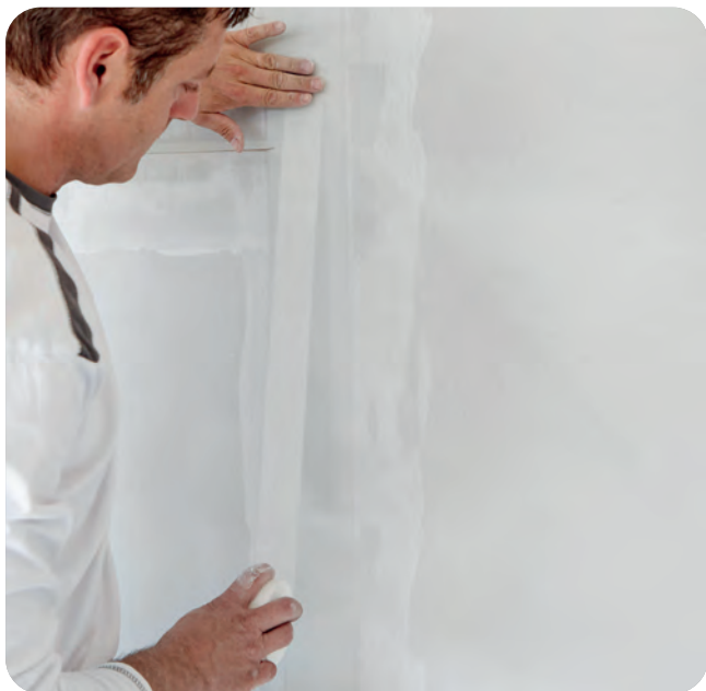
... der Längsfuge folgen. Unten mit der Traufel ablängen.
