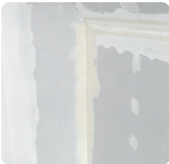
Ausdrücken der Ecken und Vorlegen des Spachtelmaterials.
