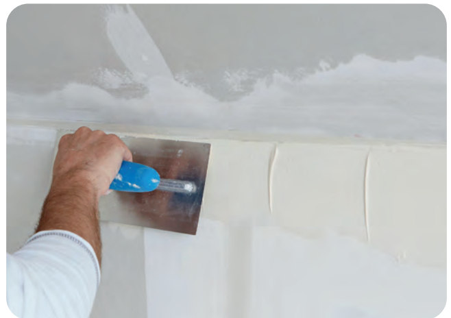
... und Vorlegen des Fugenspachtels.
