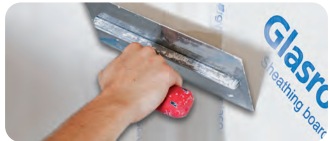
Rigips Glasfaserbewehrungsstreifen einlegen und entsprechend ablängen.
