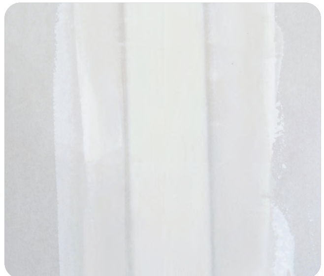
Die fertige Längsfuge nach dem Abziehen.
