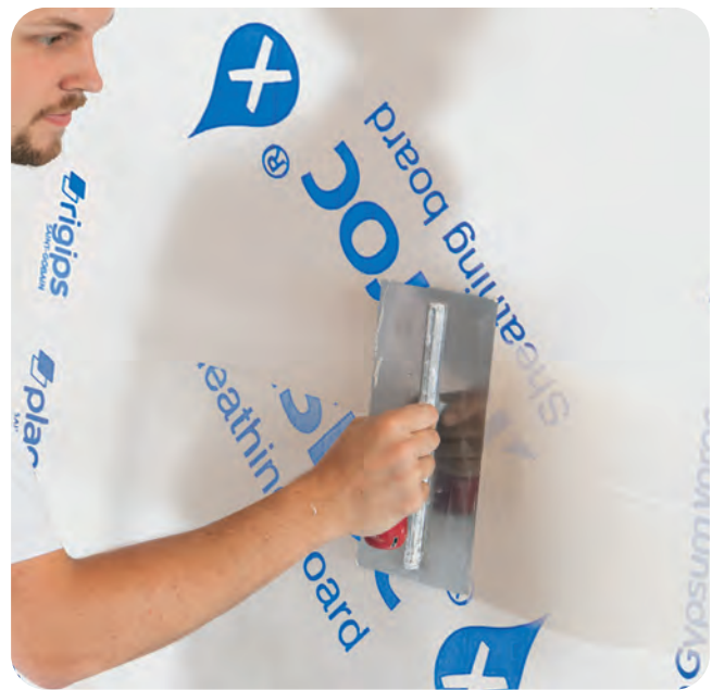
Vorlegen eines ca. 1 mm dicken Spachtelbettes...
