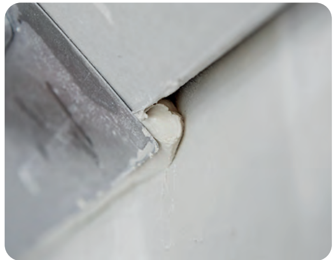
Ausdrücken der Anschlussbereiche mit Fugenspachtel.
