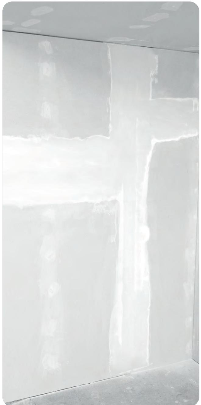
Ergebnis der Fugen nach der planebenen Nachspachtelung. Die Oberfläche ist für die nachfolgende Oberflächenbearbeitung vorbereitet.
