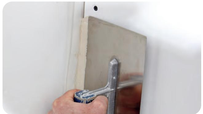
Ausdrücken der Fuge mit Spachtelmaterial und planeben abspachteln. Nach dem Aushärten des Fugenspachtels evtl. Spachtelgrate entfernen und Anschlussbereiche evtl. schleifen.
