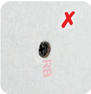
Schraube zu tief eingedreht – Karton wird zerstört.
