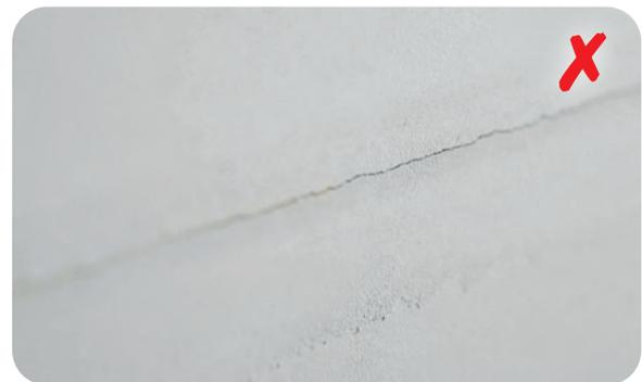
Fehler! Werden die Kanten nicht angefeuchtet, kommt es zum Aufbrennen der Spachtelmasse und zum Abriss in der Fuge.
