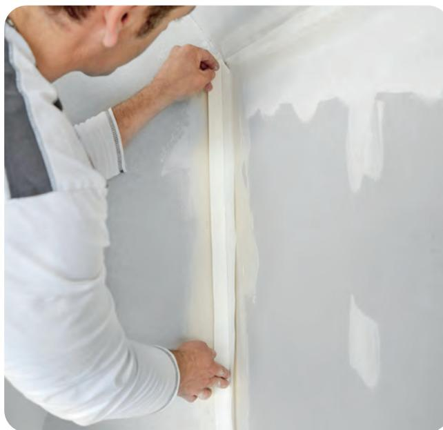
Einlegen des Rigips Levelline im Eckbereich.
