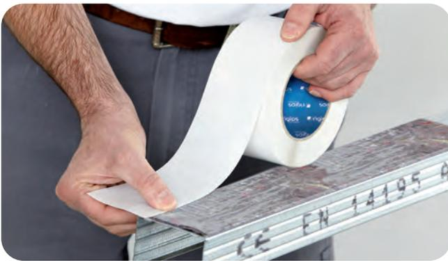
Aufbringung der Rigips Anschlussdichtung auf das zu verwendende Profil. Anschließend wird der Rigips TrennFix aufgeklebt. Der Überstand ragt über die Profilbreite hinaus. Der Rigips TrennFix kann auf beiden Seitenbereichen des Profils angebracht werden.
