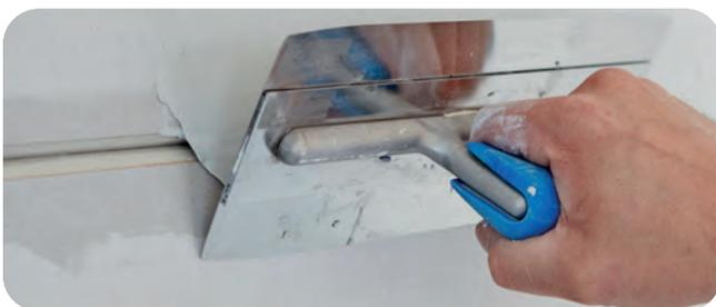
Ausdrücken der Querfugen mit SUPER Fugenfüller.
