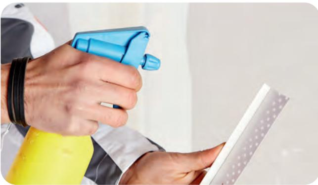
Aktivieren Sie den Kleber durch Besprühen des Rigips AquaBead L-Trims mit Leitungswasser.
