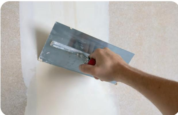
Überziehen des Rigidur Gewebebandes ohne zusätzlichen Materialauftrag.
