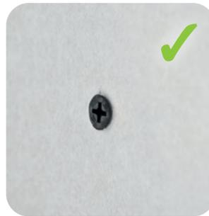
Korrekt eingedrehte Schraube.
