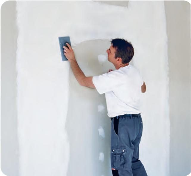
Ob ein Nachschleifen (manuell oder maschinell) der durchgetrockneten Feinspachtelmasse erforderlich ist, hängt von der vereinbarten Oberflächenqualität bzw. vorgegebenen Oberflächengüte ab.
