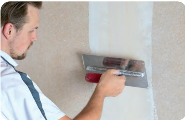
Auf die fertiggestellte Fuge wird ein dünnes Spachtelbett mit VARIO Fugenspachtel vorgelegt. Alternativ kann Rigidur Nature Line Kleber oder Holzleim auf die fertige und zuvor grundierte Spachtelfuge aufgebracht werden.
