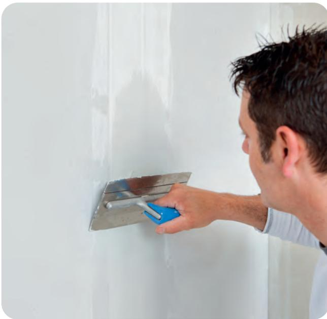
Die Nachspachtelung erfolgt dann ebenfalls mit SUPER Fugenfüller. Sie darf erst nach dem Abbinden der Vorspachtelung erfolgen.
