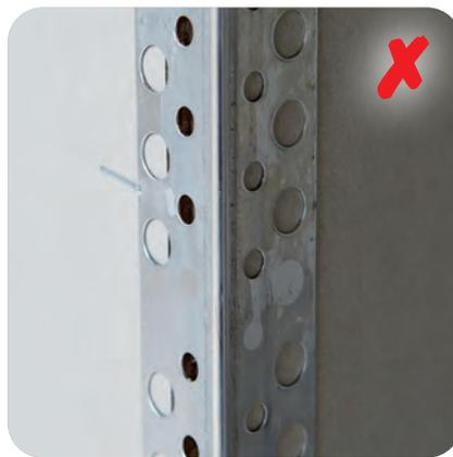
Baustellentypisch, aber falsch ist das Befestigen des Alu-Eckschutzes mit Klammern – das sogenannte Tackern. Durch das fehlende Spachtelbett fehlt die Bindung zum Untergrund und somit die Haftung. Die Gefahr von Rissbildung ist groß.
