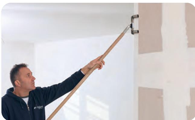
Anpressen mit dem Kantenroller, bei der Außenecke – wie hier gezeigt – mit dem Rigips Außenkantenroller für 90°- Winkel...
