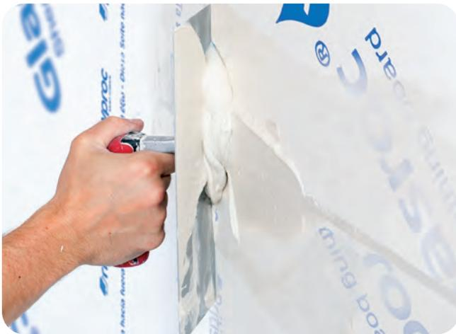
Ausdrücken der Fuge mit VARIO H Fugen- und Flächenspachtel und Spachtelmasse abbinden lassen.
