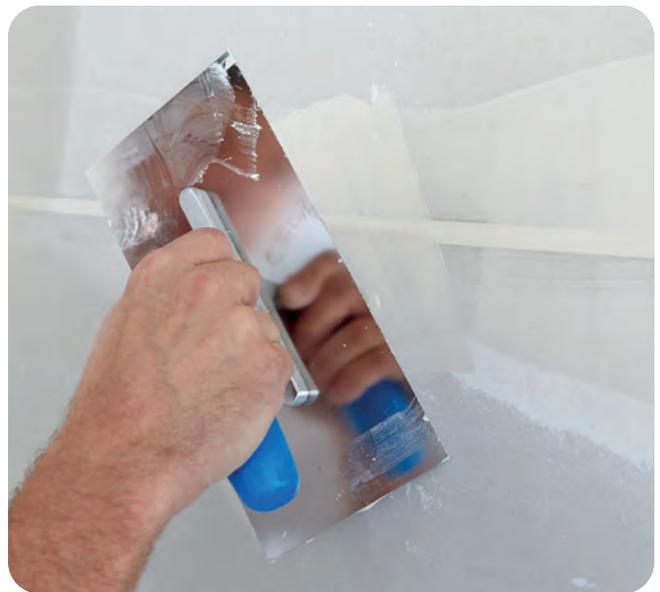
Beim Verfüllen der Queranten ist darauf zu achten, dass der Fugenspachtel vom Bewegungsablauf zunächst von unten nach oben in die Querfuge gedrückt und danach von oben nach unten abgezogen wird. Das gewährleistet ein gleichmäßiges Ausfüllen und sicheres Anhaften des Fugenspachtels an den Plattenqueranten.
