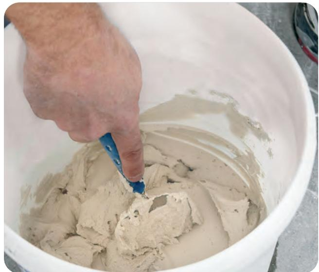
Das Anrühren des Fugen- und Flächenspachtels VARIO H erfolgt analog dem Anrühren des VARIO Fugenspachtels. Die fertig angerührte Spachtelmasse entspricht auch farblich der Rigips Glasroc X Plattenoberfläche. Die Produkte sind auf das Rigips Glasroc X System entsprechend abgestimmt.
