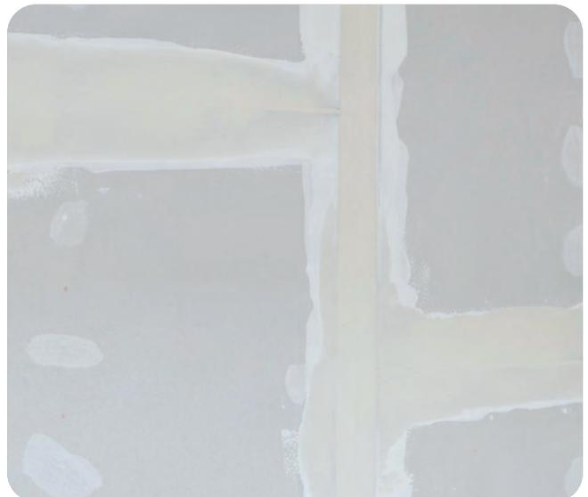
Ergebnis der Vorspachtelung (bei Quer- und Längsfugen).
