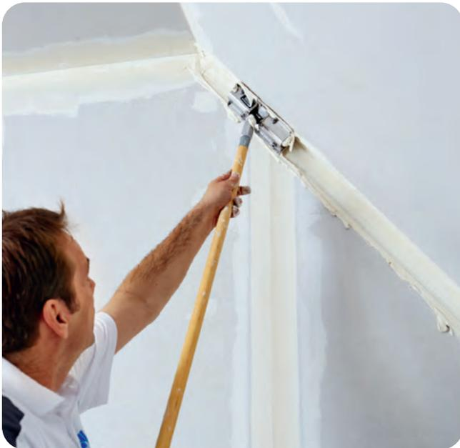
... anschließend mit dem entsprechenden Kantenroller anpressen.
