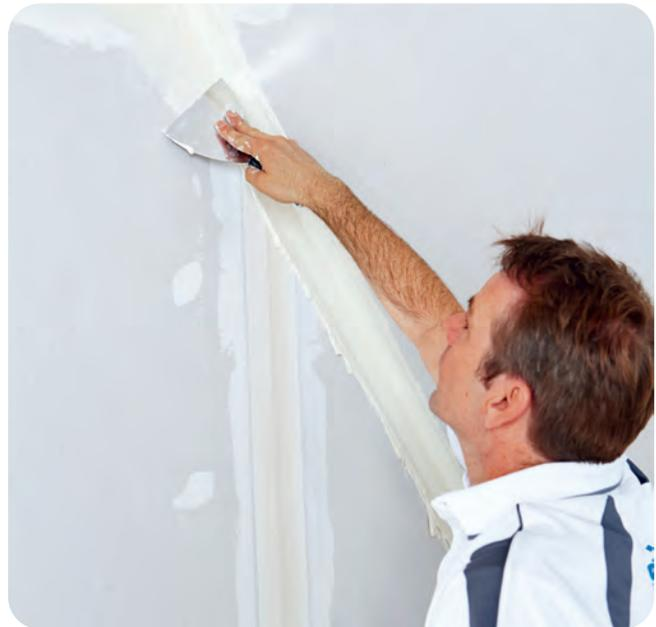
Mit dem Abziehen der überstehenden Spachtelmasse ist die Ecksituation mit dem Rigips Levelline fertiggestellt.
