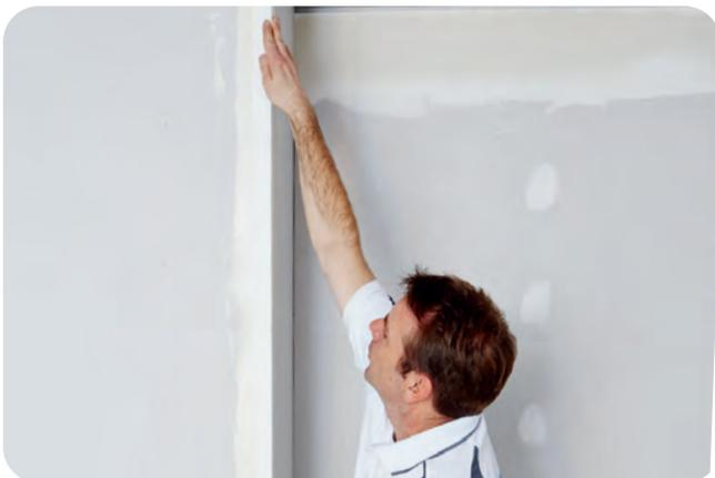
Ausrichten des Rigips Levelline.
