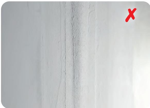
Überzieht man den Rigips Glasfaserbewehrungsstreifen nach dem Einlegen sofort mit weiterem Material kommt es zum Effekt des „Durchwalgens“, d.h., der Glasfaserbewehrungsstreifen fällt in der Mitte der Fuge nach außen aus und steht nach vorne vor.
