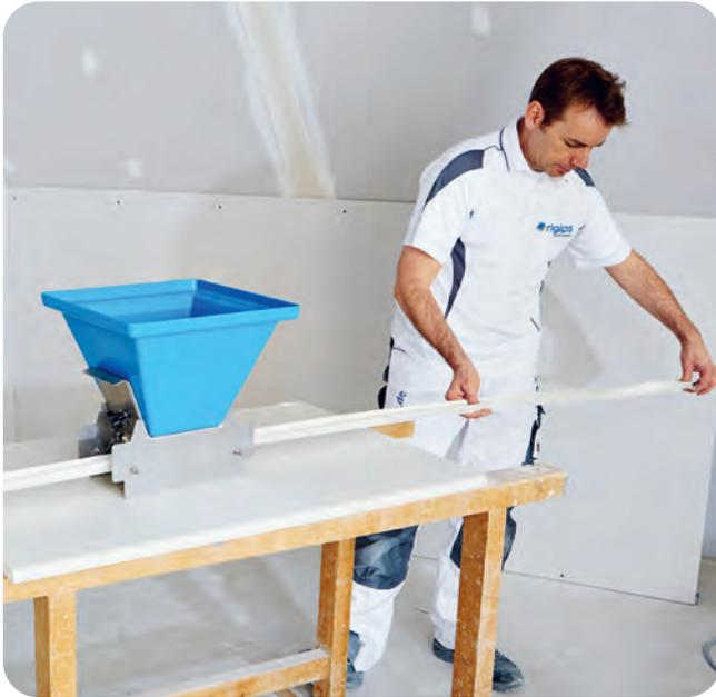
Die zugeschnittenen Rigips Levelline Profile werden zügig durch den Auftragsbehälter gezogen ...
