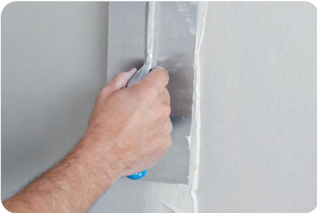
Die Längsfugen werden mit Spachtelmaterial ausgedrückt.
