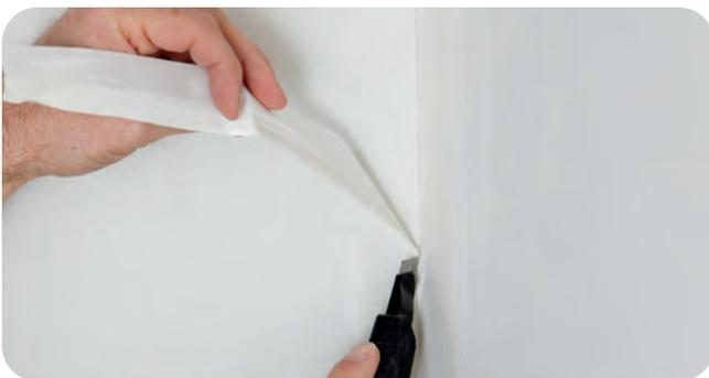
Der Überstand des Rigips TrennFix wird flächenbündig abgetrennt, womit eine kontrollierte Bauteiltrennung erfolgt.
