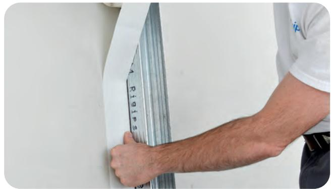
Alternativ: Rigips TrennFix direkt neben das an die Wand angebrachte CW-Profil auf die Wand aufkleben bzw. auf das anzuschließende Bauteil kleben. Der Klebestreifen ist hierbei parallel zum Profil aufzubringen.
