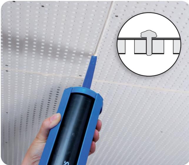
Die Fugen satt und vollständig ausfüllen, sodass sich ein Wulst auf der Rückseite der Platte bildet.
