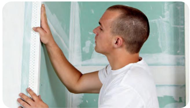
Rigips AquaBead mittig ansetzen und ausrichten.
