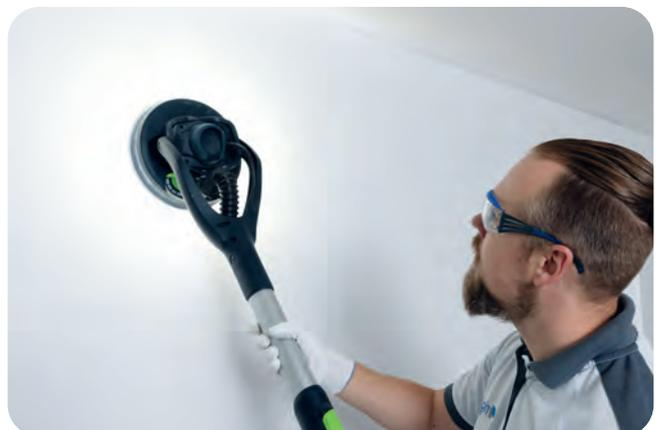
Falls erforderlich, maschinell mit einem 240er- bis 280er Schleifpapier oder manuell mit einem 240er-Schleifpapier abschleifen.
