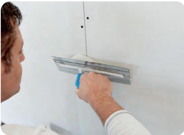
Die Längskante mit SUPER Fugenfüller ausspachteln.
