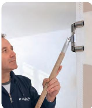
...oder bei einer Innenkante mit dem Rigips Innenkantenroller. Die Verarbeitungsabläufe sind gleich einer Außenecke. Lediglich die Verformung des Rigips AquaBead Flex PRO erfolgt mit der Klebeseite dann gemäß der Innenkante nach innen.
