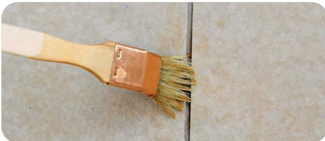
Der Abstand der montierten Platten beträgt ca. 5 bis 7 mm. Wichtig: Die Plattenkanten müssen entstaubt und vorgehässt werden.
