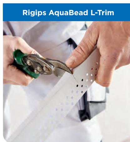
Der Zuschnitt der Rigips AquaBead Produkte erfolgt mit einer handelsüblichen Schere (Rigips AquaBead Flex PRO) oder auch mit einer Blechschere (Rigips AquaBead/Rigips AquaBead L-Trim).
