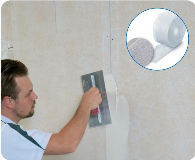
Die Verspachtelung kann sowohl mit dem Rigips Glasfaserbewehrungsstreifen als auch dem Rigips Papierbewehrungsstreifen erfolgen. Hierbei die Längs- und Querfugen mit VARIO Fugenspachtel füllen und quer zur Fuge und flächenbündig abziehen.
