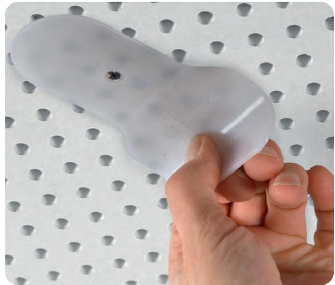
Schraubenköpfe leicht erhöht mithilfe einer Rigips Schraubenkopfschablone überspachteln.
