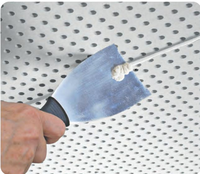
Im Nachgang den leicht angezogenen Rigitone Mix vorsichtig mit dem Rigips Stielspachtel abstoßen und die Fugen anschließend in entgegengesetzter Richtung mit dem Spachtel glattstreichen.
