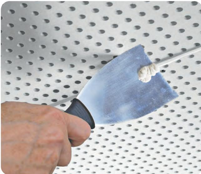
Nach ca. 30 Minuten den leicht angezogenen Fugenspachtel vorsichtig mit dem Rigips Stielspachtel abstoßen und die Fugen anschließend in entgegengesetzter Richtung mit dem Spachtel glattstreichen.
