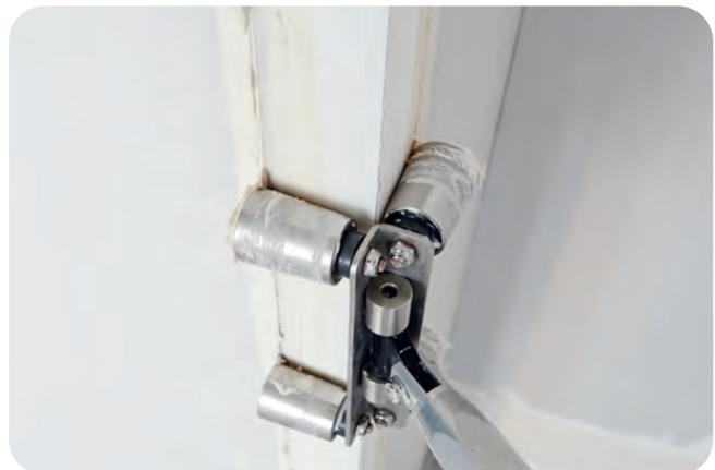
Antippressen mit dem Rigips Außenkantenroller.
