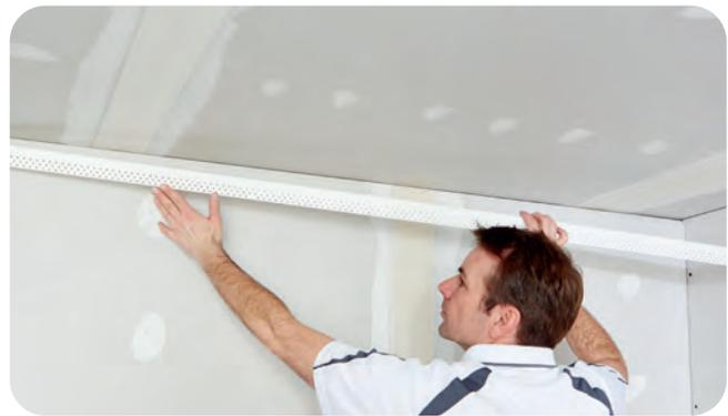
Die angefeuchtete, klebende Seite des Rigips AquaBead L-Trims auf die gewünschte Abschlusskante setzen. Gerade bzw. lotrecht ausrichten.
