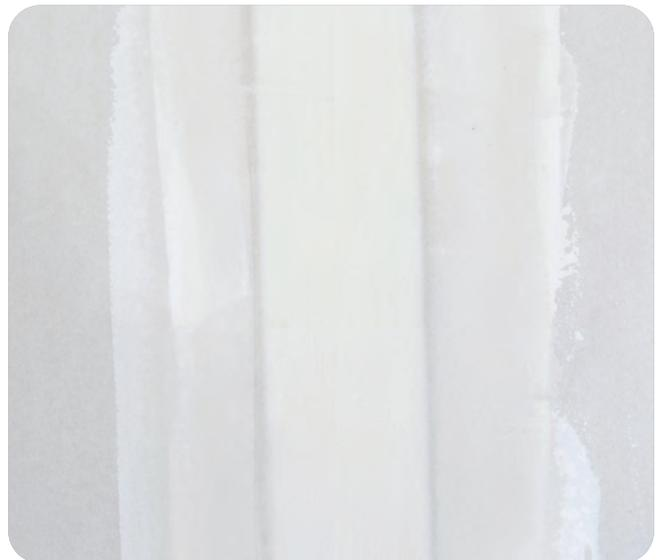
Die fertige Längsfuge nach dem Abziehen.
