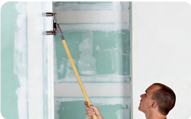
Rigips AquaBead mit dem Rigips Außenkantenroller andrücken. Achten Sie auf einen gleichmäßigen und ausreichenden Anpressdruck.
