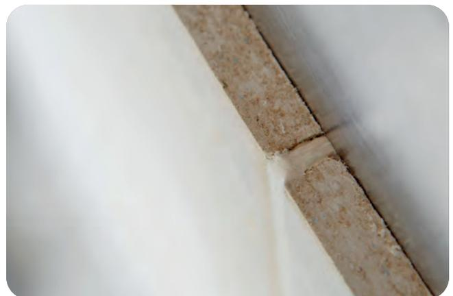
Komplett ausgefüllte Spachtelfuge (von oben) mit planebenem Ergebnis.
