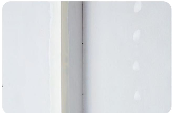
Fertige Außenkante mit Rigips Levelline.
