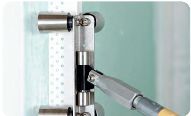
Stellen Sie sicher, dass die seitlichen Schenkel flach aufliegen und komplett die Oberflächen berühren.
