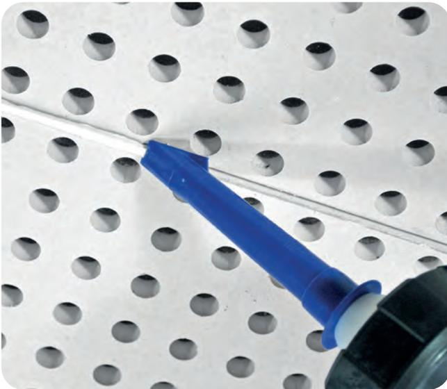
Der Rigitone Mix Fugenspachtel wird so eingebracht, dass die Fuge von unten an gefüllt wird und der Fugenspachtel eine leichte Wulst auf der Sichtseite der Platte bildet.
