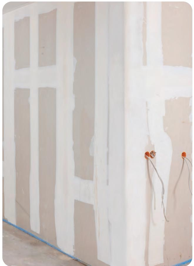
Fertige Außenkante mit dem flexiblen Kantenschutz Rigips AquaBead Flex PRO.
