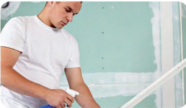
Die Klebefläche des Rigips AquaBeads wird durch Besprühen mit Leitungswasser aktiviert.
