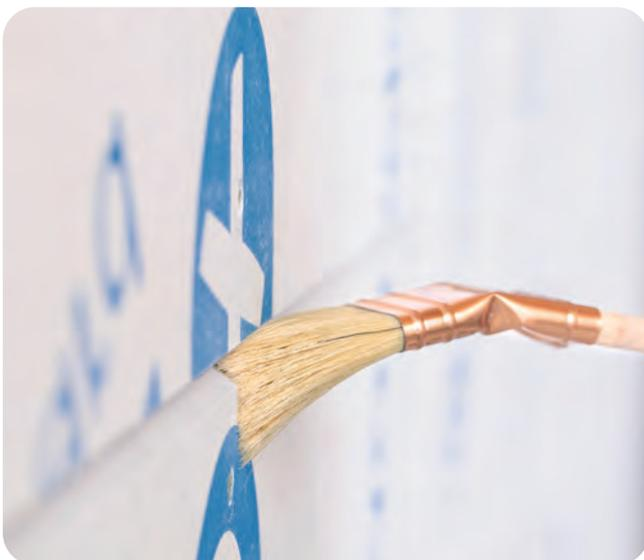
Angefaste Plattenkanten entstauben ...
