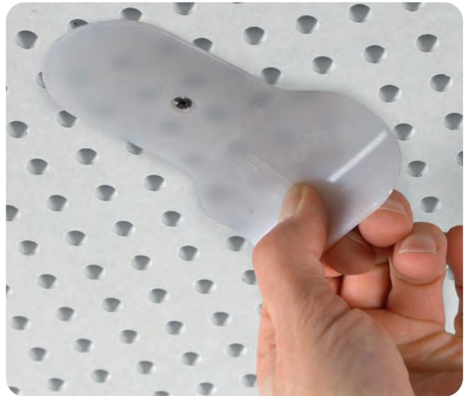
Schraubköpfe leicht erhöht mithilfe einer Rigips Schraubkopfschablone überspachteln.
