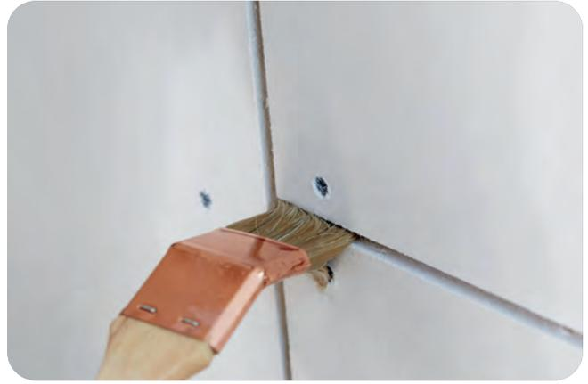
Die Plattenkanten müssen entstaubt und vorgehäst werden.
