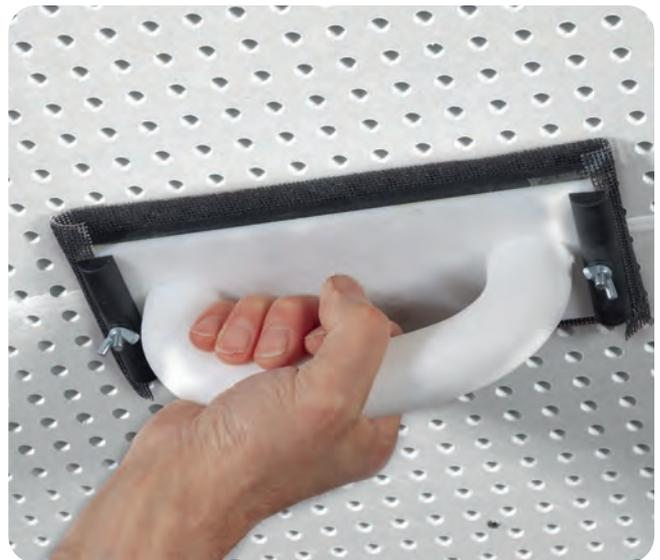
Nach mindestens 12-24 Stunden die Fugenbereiche und überspachtelten Schraubköpfe abschließend schleifen und für die gewünschte weitere Oberflächenbehandlung nach vollständiger Trocknung fortsetzen.
