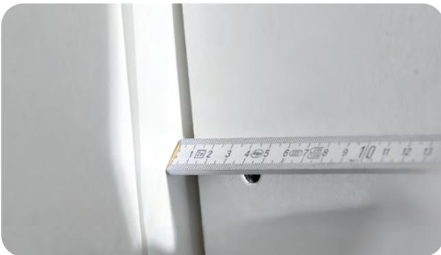
Gipsplatten mit ca. 5 mm Fugenabstand zur Wand montieren.
