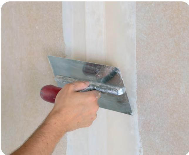
... und anschließendes Überziehen ohne zusätzlichen Materialauftrag.
