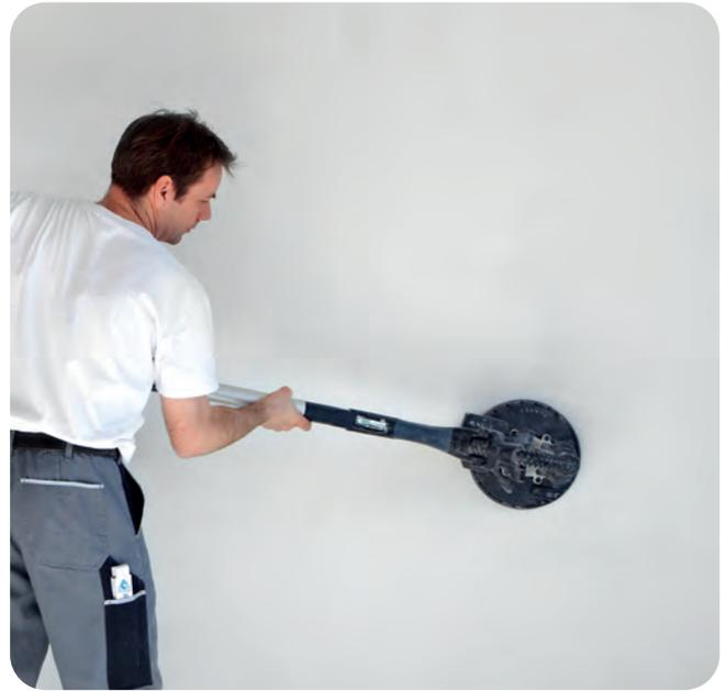
Ein eventuelles Nachschleifen erfolgt nach der kompletten Austrocknung der Nachspachtelung. Dies kann sowohl manuell als auch maschinell erfolgen.
