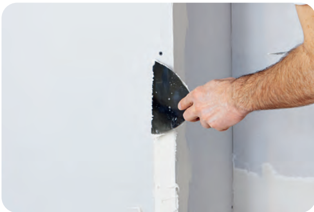
Vorlegen eines dünnen Spachtelbettes.
