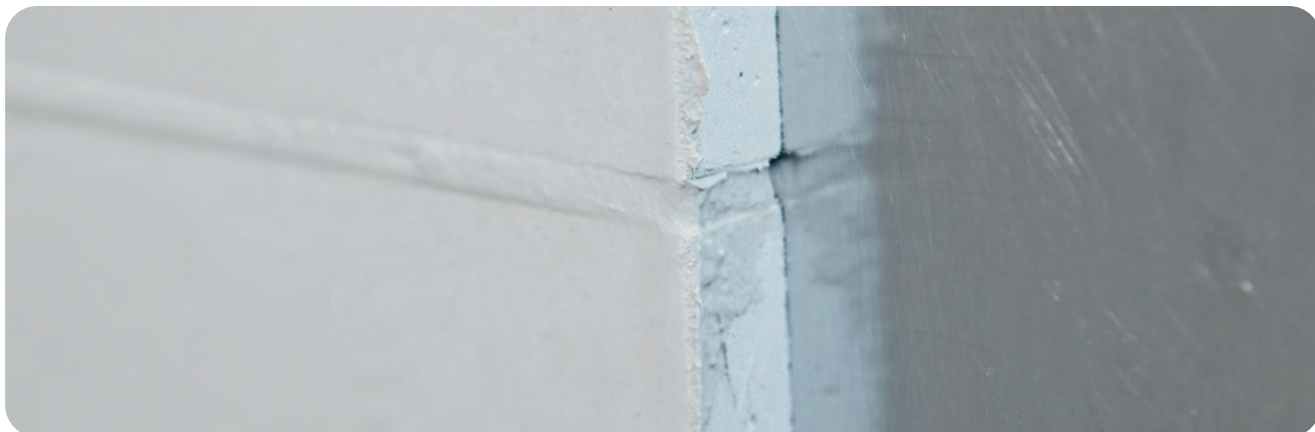
Auf das vollständige Füllen der Fugen ist zu achten!
