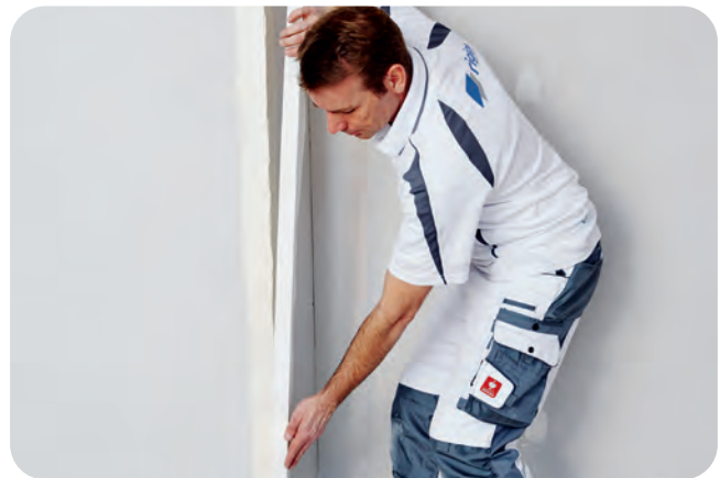
Ansetzen des Rigips Levelline.
