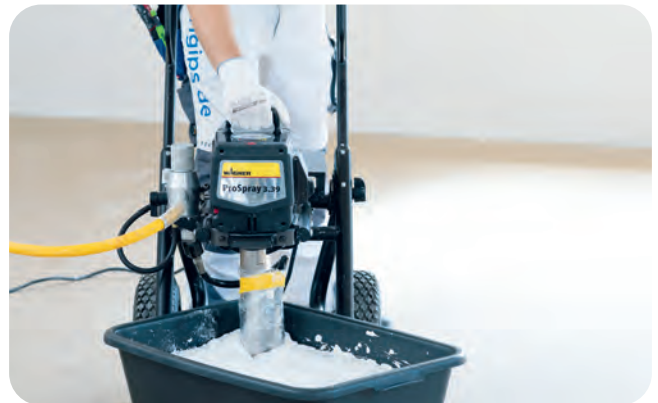
Airless Ansaugrohr in die Masse tauchen
