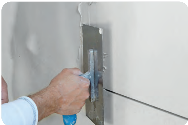
Ausdrücken der Querfugen mit VARIO Fugenspachtel, ...
