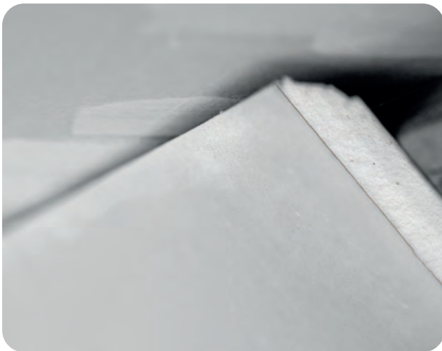
Ausgangssituation im Anschlussbereich zur Kehl balkendecken.
