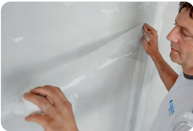
... und unmittelbares Einlegen des Rigips Glasfaserbewehrungsstreifens.
