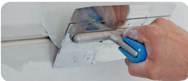
Ausdrücken der Querfugen mit SUPER Fugenfüller.
