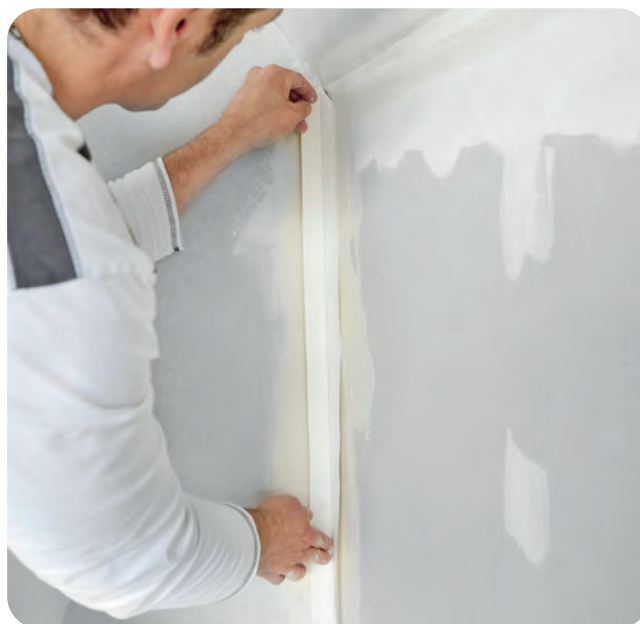
Einlegen des Rigips Levelline im Eckbereich.
