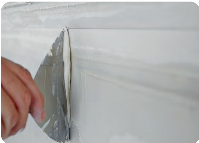
Abziehen des überschüssigen Fugenspachtels.
