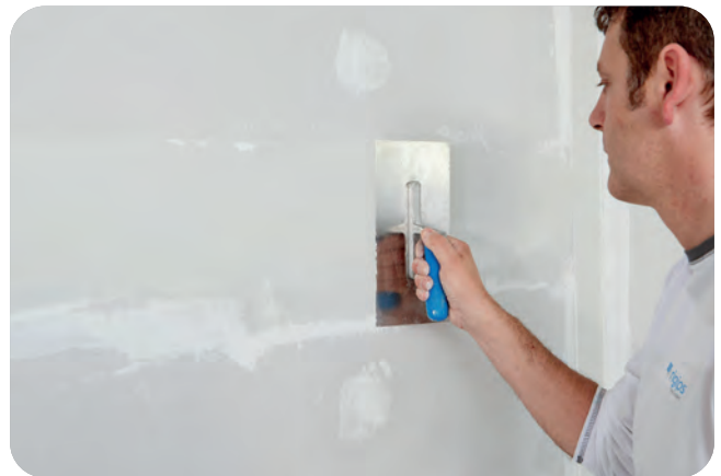
Überziehen des Rigips Glasfaserbewehrungsstreifens ohne zusätzlichen Materialauftrag.
