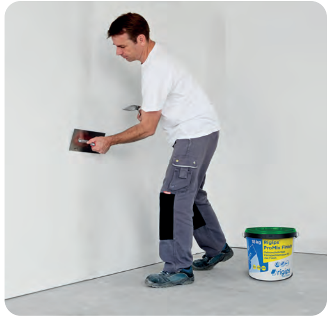
Danach das Fugenfinish mit ProMix Finish durchführen.
