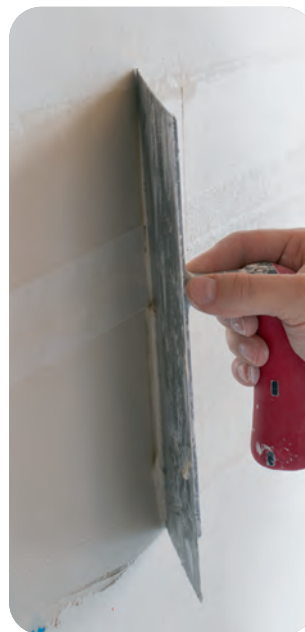
Überziehen des Rigips Glasfaserbewehrungsstreifens ohne zusätzlichen Materialauftrag.
