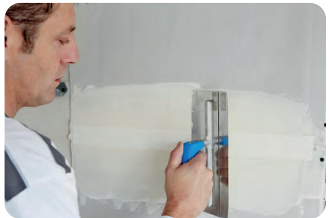
Einbetten des Rigips Papierbewehrungsstreifens ohne zusätzlichen Materialauftrag.
