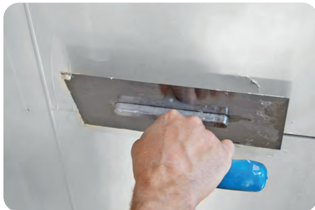
... wobei auf eine ausreichende Flankenhaftung an den Plattenkanten zu achten ist.
