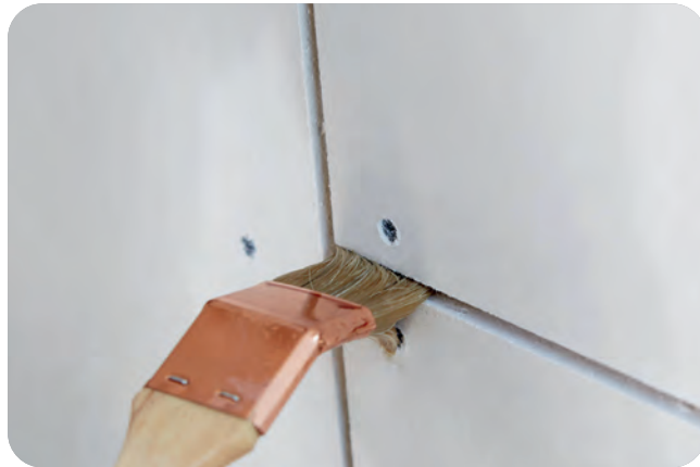
Die Plattenkanten müssen entstaubt und vorgehäst werden.
