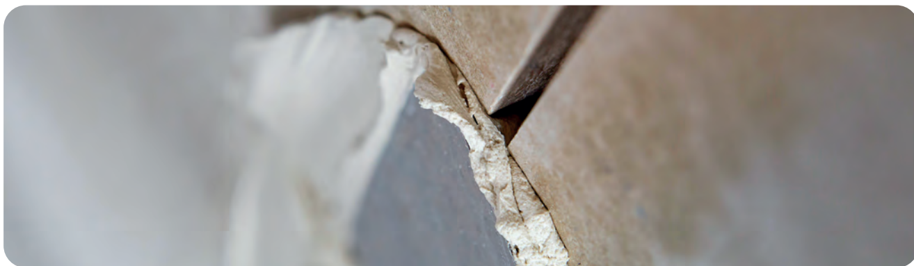
Spachtelfugentechnik 5–7 mm
