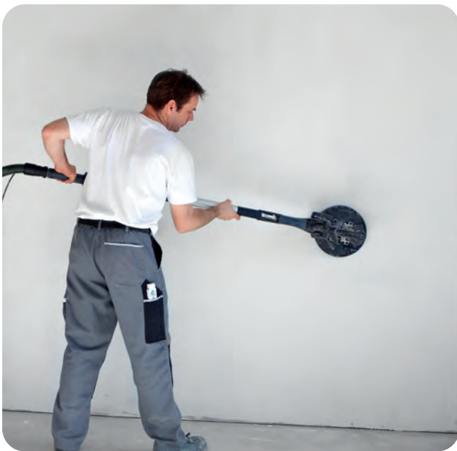
Eventuell Spachtelgrate manuell oder maschinell nachschleifen.
