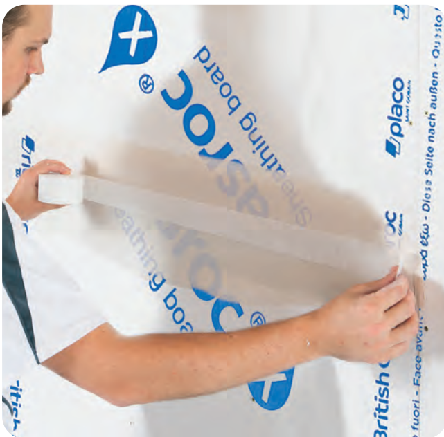
... und unmittelbares Einlegen des Rigips Glasfaserbewehrungsstreifens.
