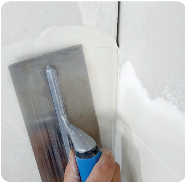
Fugenspalt ausdrücken mit Fugenspachtel.
