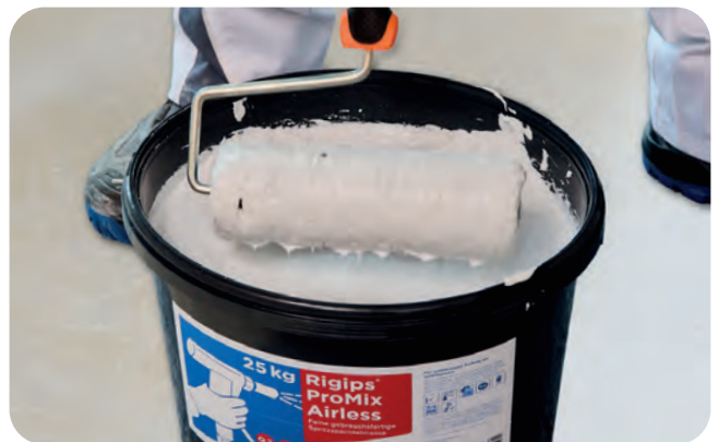
... und Spachtelmasse aufnehmen
