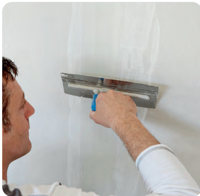
Überziehen des Glasfaserbewehrungsstreifens ohne zusätzlichen Materialauftrag.
