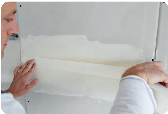
Vorsichtiges Einlegen des Rigips Papierbewehrungsstreifens.
