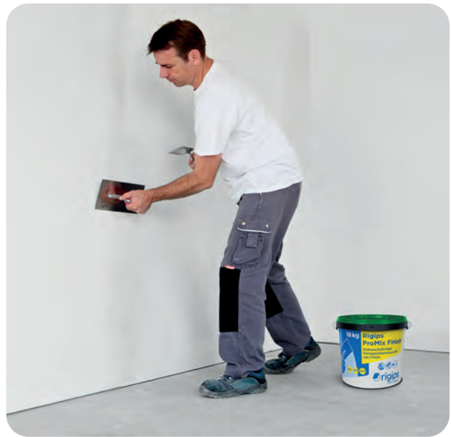
Danach das Fugenfinish mit ProMix Finish durchführen.
