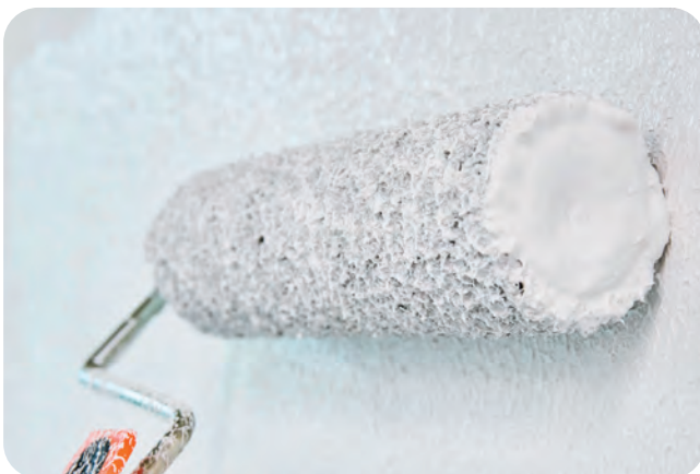
Auftrag mit Rollspachtelwalze
