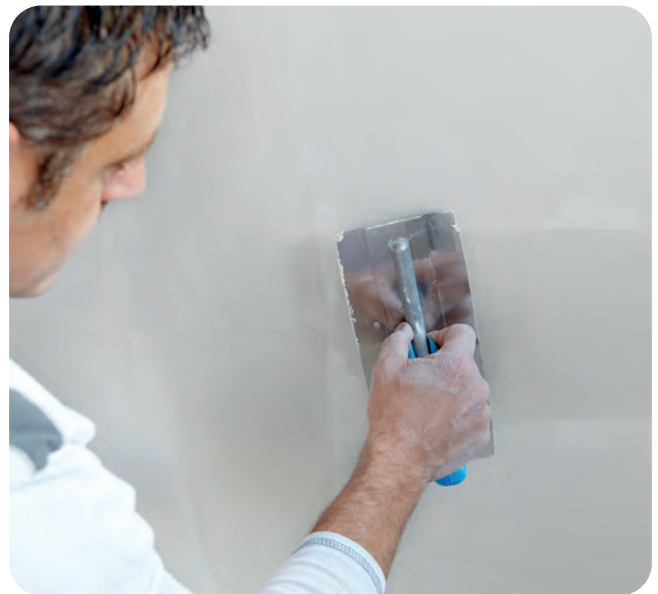
Das Spachtelmaterial wird in langen Zügen sowohl über die Querfugen ...
