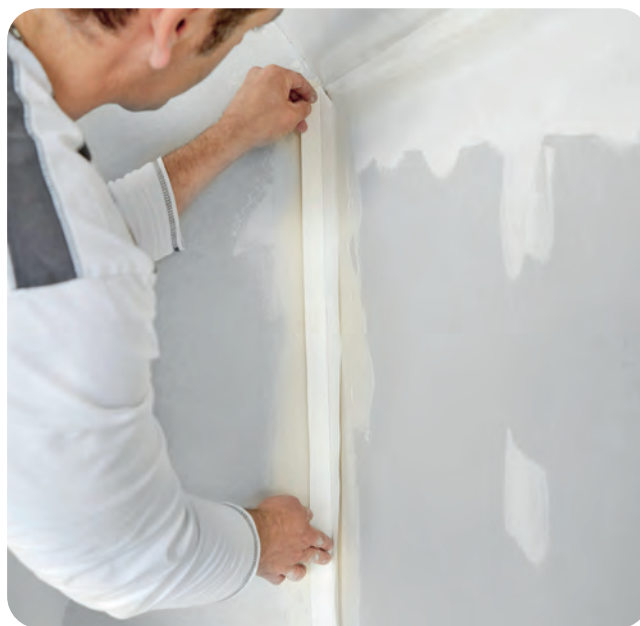
Einlegen des Rigips Levelline im Eckbereich.
