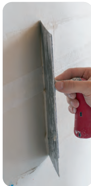
Überziehen des Rigips Glasfaserbewehrungsstreifens ohne zusätzlichen Materialauftrag.
