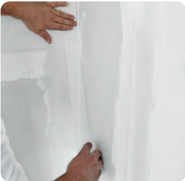
Einlegen des Rigips Glasfaserbewehrungsstreifens auf das vorgelegte Spachtelbett.
