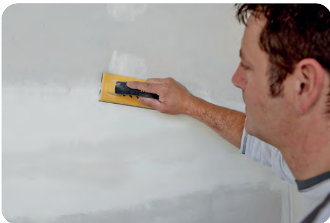
Nach kompletter Durchtrocknung des Spachtelmaterials kann die Oberfläche geschliffen werden.
