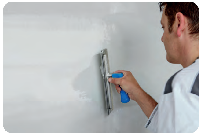
Mit der Nachspachtelung erreicht man den stufenlosen Übergang zur Plattenoberfläche.
