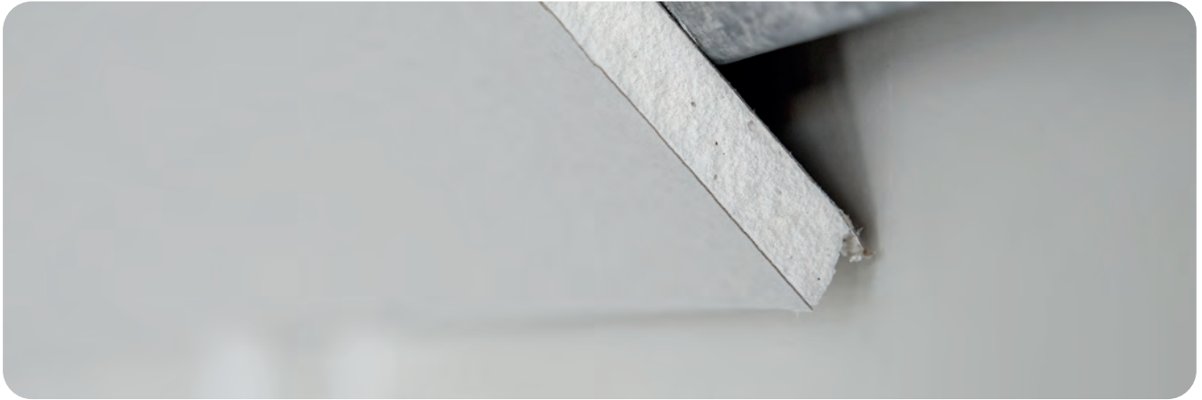
Ausgangssituation im Anschlussbereich zur Abseitenwand.
