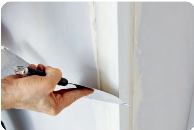
Überflüssige Spachtelmasse wegnehmen und den Rest ausziehen.
