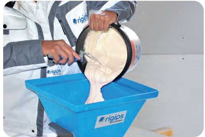
... und dann in den Rigips Auftragsbehälter eingefüllt.
