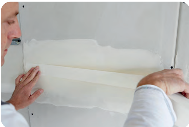
Vorsichtiges Einlegen des Rigips Papierbewehrungsstreifens.
