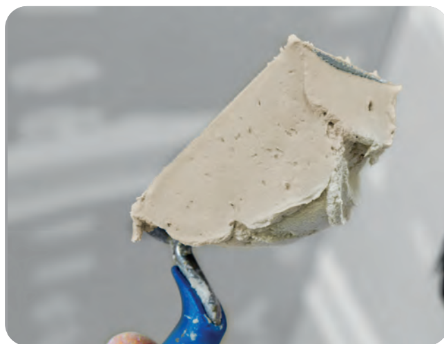
Die Konsistenz des angerührten Fugenspachtels sollte so sein, dass das Material von der umgedrehten Kelle nicht abrutscht (Kellentest).
