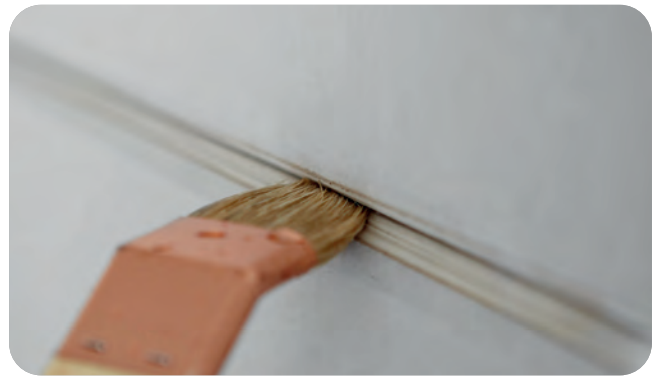
Das Vornässen der Querkante ist wichtig, damit der Spachtelmasse nicht zu schnell das Wasser entzogen wird.
