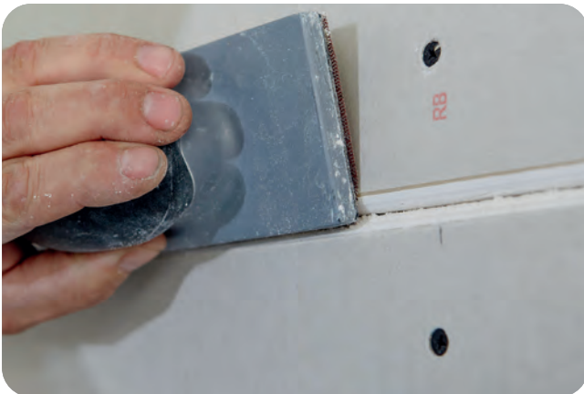
Brechen des Kartons am oberen und unteren Übergang von der Kartonoberfläche zum Gipskern.
