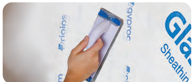
Nach ausreichender Trocknung erfolgt die Nachspachtelung mit dem VARIO H Fugen- und Flächenspachtel. Abhängig von der Anforderung der Oberflächenqualität kann noch ein Schleifen bzw. ein weiterer Überzug mit Spachtelmaterail bis zur Erreichung der geforder-ten Qualitätsstufe notwendig sein.
