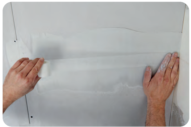
Einlegen des Rigips Glasfaserbewehrungsstreifens.
