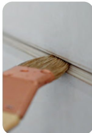
Gipsstaubentfernung für eine gute Haftung zwischen Spachtelmasse und Plattenquerkante. Vornässen der Querkante, damit der Spachtelmasse nicht zu schnell das Wasser entzogen wird.
