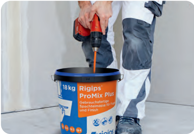
Unter Zugabe von ca. 100 ml Wasser pro 5 kg Spachtelmasse wird der ProMix Plus gut durchgerührt ...
