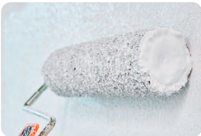
Auftrag mit Rollspachtelwalze
