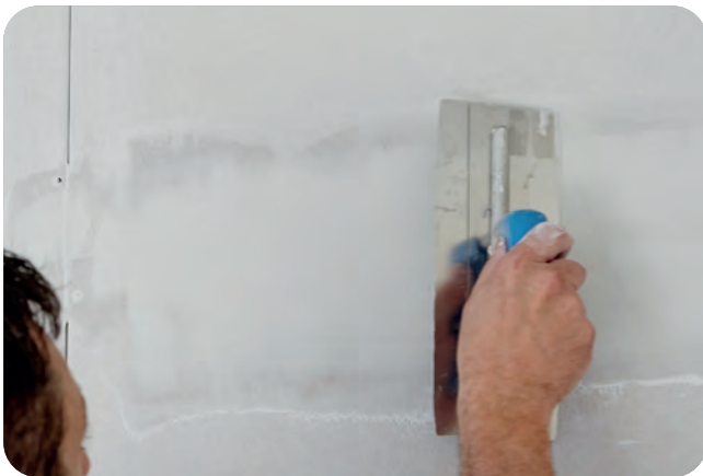
Überziehen des Glasfaserbewehrungsstreifens ohne zusätzlichen Materialauftrag.
