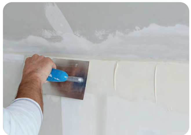
... und Vorlegen des Fugenspachtels.
