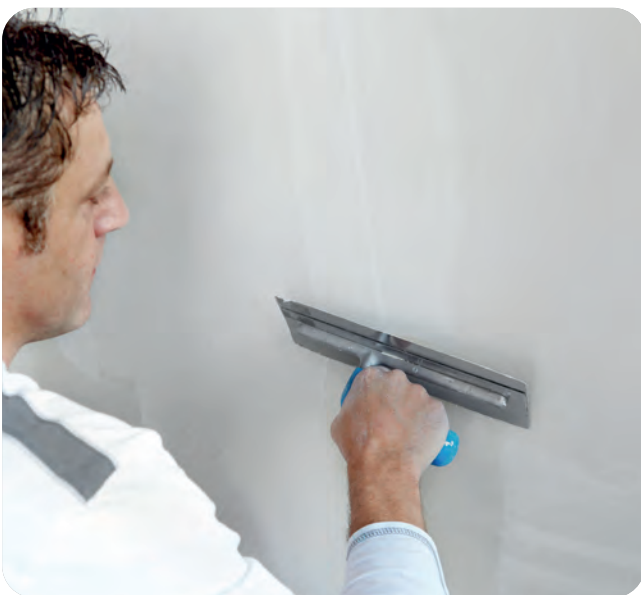
... als auch über die Längsfugen aufgetragen.
