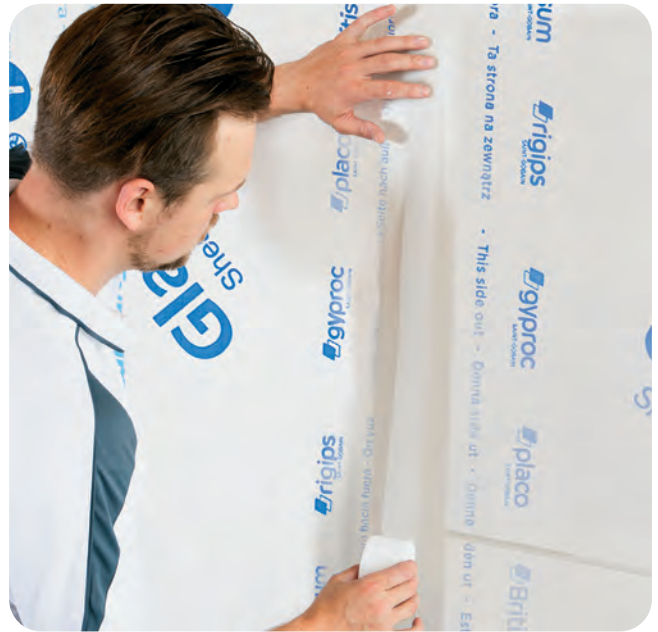
Rigips Glasfaserbewehrungsstreifen einlegen und entsprechend ablängen.
