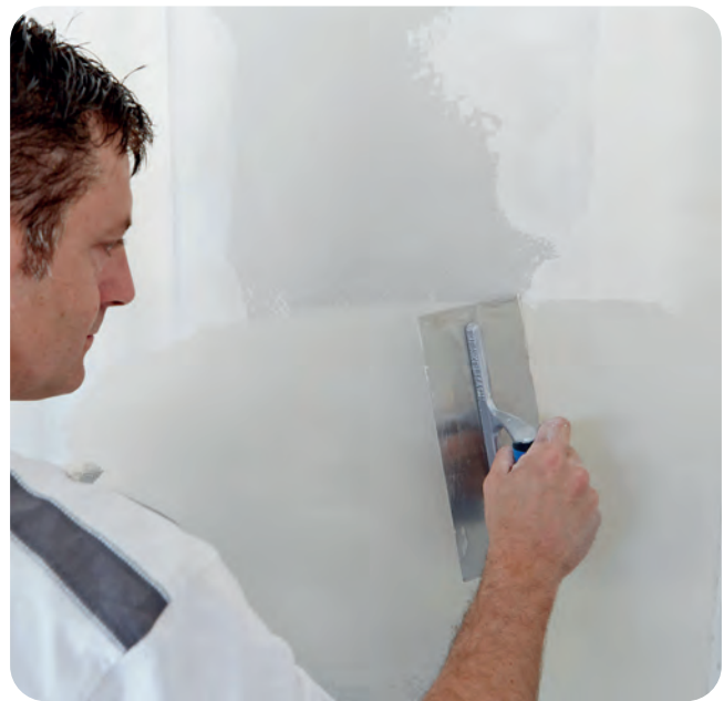
Ist das Material der Vorspachtelung abgebunden, kann die Nachspachtelung ebenfalls mit VARIO Fugenspachtel erfolgen.
