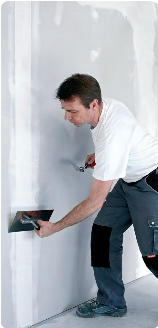
Der ProMix Finish wird auf den Untergrund mithilfe eines Glättspachtels aufgetragen.
