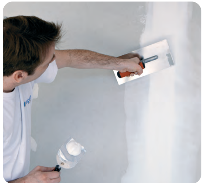
Der ProMix Finish lässt sich problemlos bis auf „null“ ausziehen und schon während dieses Vorgangs ist die hervorragende Oberflächenqualität erkennbar.
