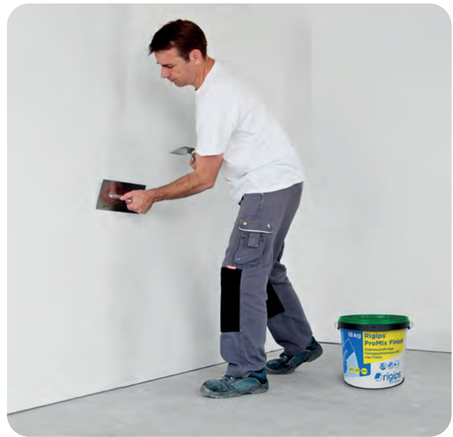
Danach das Fugenfinish mit ProMix Finish durchführen.
