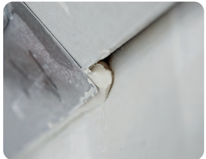
Ausdrücken der Anschlussbereiche mit Fugenspachtel.
