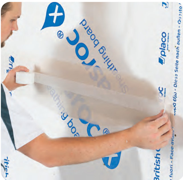
... und unmittelbares Einlegen des Rigips Glasfaserbewehrungsstreifens.
