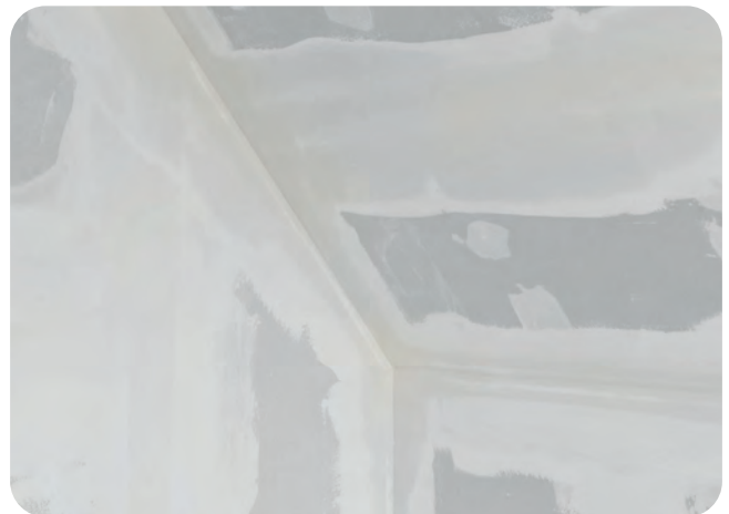
Fertige Dachgeschossituation mit Rigips Level- line mit unterschiedlichen Winkelstellungen.
