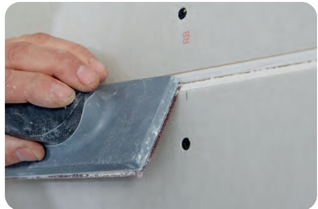
Brechen des Kartons am oberen und unteren Übergang von der Kartonoberfläche zum Gipskern.
