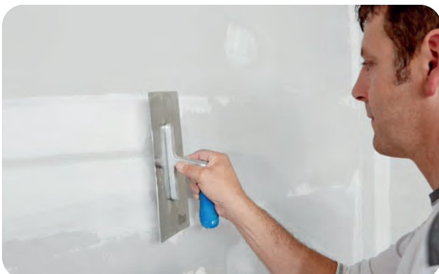
Vorlegen des 1 mm dicken Spachtelbettes ...
