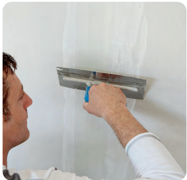
Überziehen des Glasfaserbewehrungsstreifens ohne zusätzlichen Materialauftrag.
