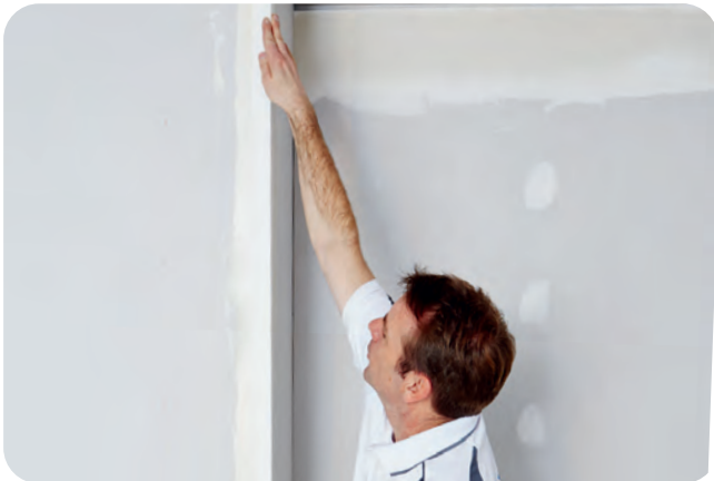
Ausrichten des Rigips Levelline.
