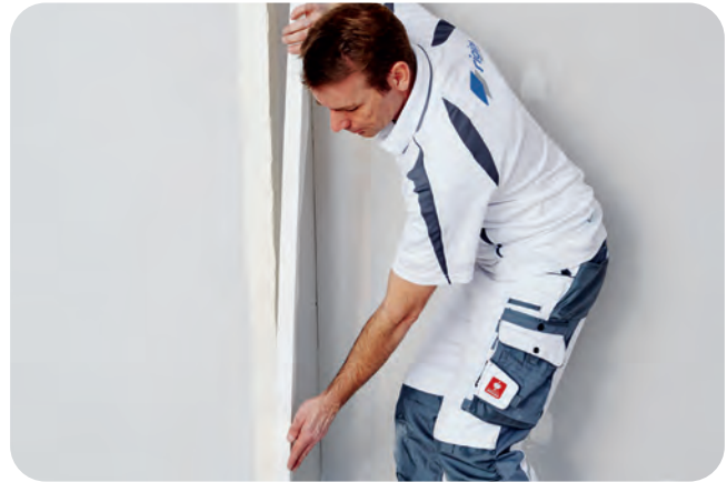
Ansetzen des Rigips Levelline.
