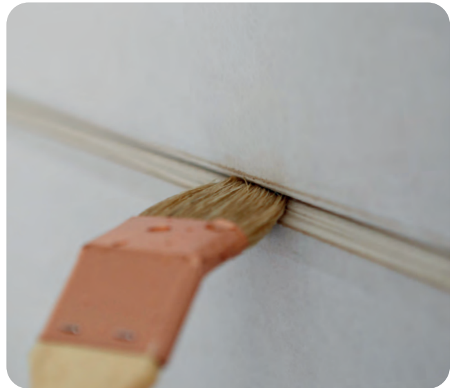
Das Vornässen der Querkanten ist wichtig, damit der Spachtelmasse nicht zu schnell das Wasser entzogen wird.
