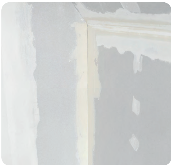
Ausdrücken der Ecken und Vorlegen des Spachtelmaterials.
