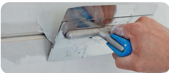
Ausdrücken der Querfugen mit SUPER Fugenfüller.
