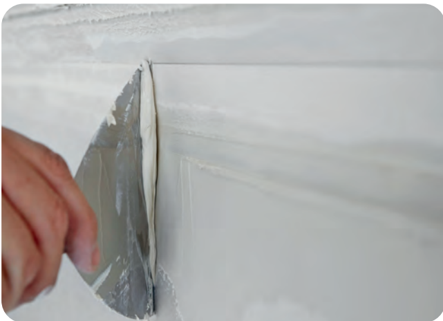
Abziehen des überschüssigen Fugenspachtels.
