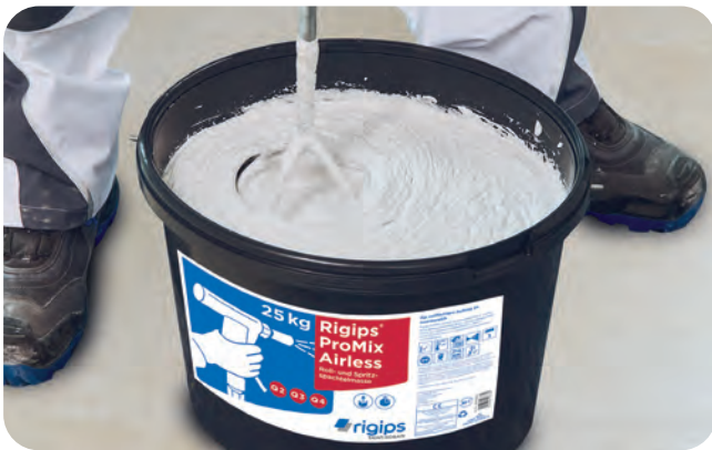
Rigips ProMix Airless Spachtelmasse mit dem Quirl aufrühren
