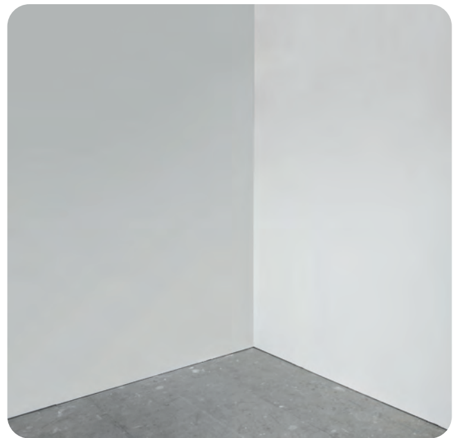
Überzeugendes Resultat: eine makellose weiße Oberfläche. Die technische Fugenverspachtelung wurde komplett mit VARIO Fugenspachtel vorgenommen und die Q3-Qualität dann mit dem ProMix Finish vollendet.
