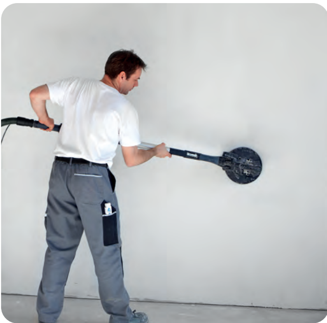
Eventuell Spachtelgrate manuell oder maschinell nachschleifen.
