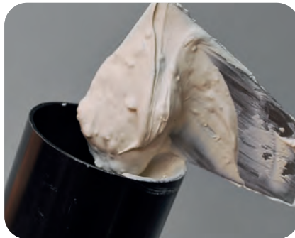
Den angerührten VARIO Fugenspachtel zügig in die leicht schräg gestellte Kartusche einfüllen.
