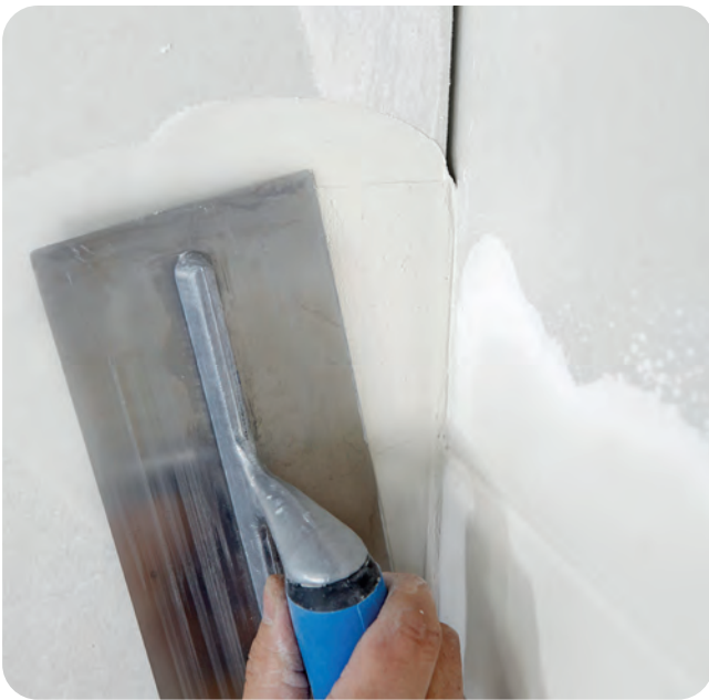
Fugenspalt ausdrücken mit Fugenspachtel.
