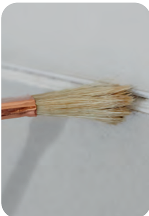
Gipsstaubentfernung für eine gute Haftung zwischen Spachtelmasse und Plattenquerkante. Vornässen der Querkante, damit der Spachtelmasse nicht zu schnell das Wasser entzogen wird.
