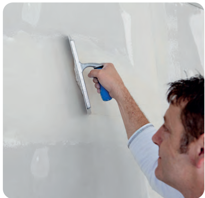
Zum Schluss wird mit nahezu anliegender Kelle mit einem geraden und schnellen Zug die Nachspachtelung mit den Quer- und Längsfugen geglättet. Mit dieser Nachspachtelung ist dann die Qualitätsstufe Q2 erreicht.
