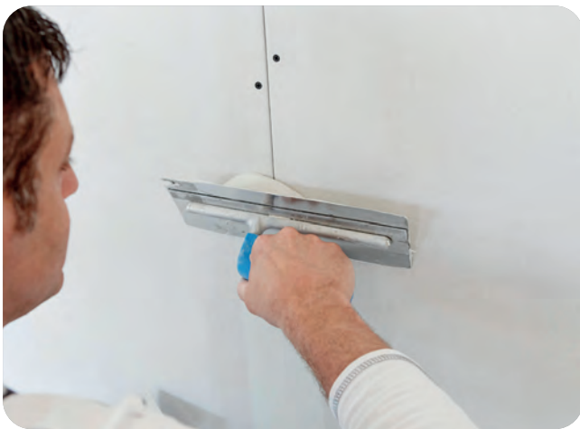
Die Längskante mit SUPER Fugenfüller ausspachteln.
