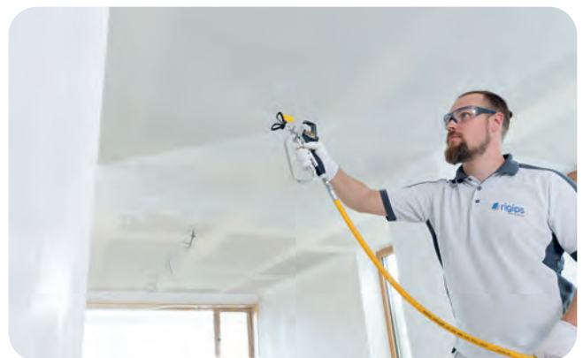
Rigips ProMix Airless in gleichmäßigen Bewegungen vollflächig auf die Wandoberfläche aufbringen
