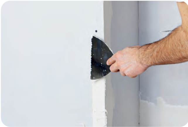
Vorlegen eines dünnen Spachtelbettes.
