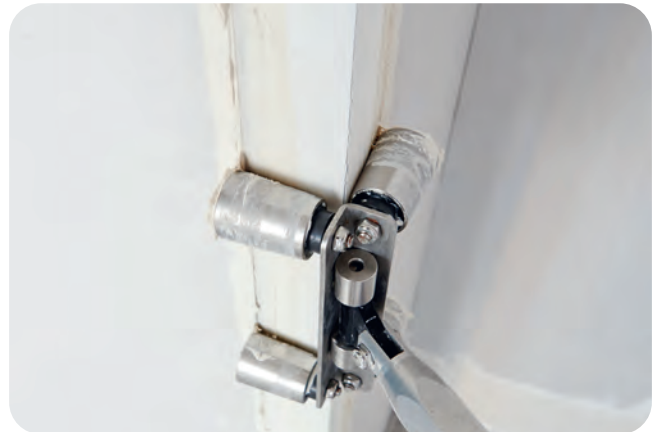
Anpressen mit dem Rigips Außenkantenroller.
