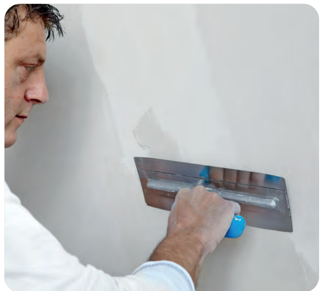
Spachtelmaterial bis auf „null“ ausziehen.
