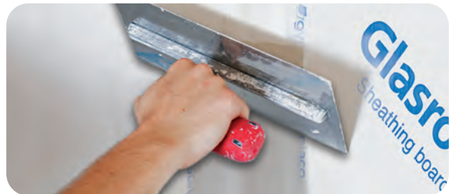
Rigips Glasfaserbewehrungsstreifen einlegen und entsprechend ablängen.
