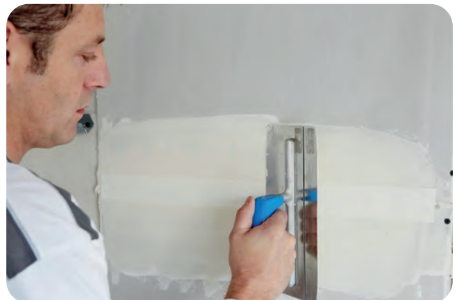
Einbetten des Rigips Papierbewehrungsstreifens ohne zusätzlichen Materialauftrag.
