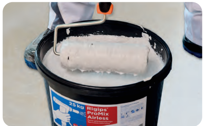
... und Spachtelmasse aufnehmen
