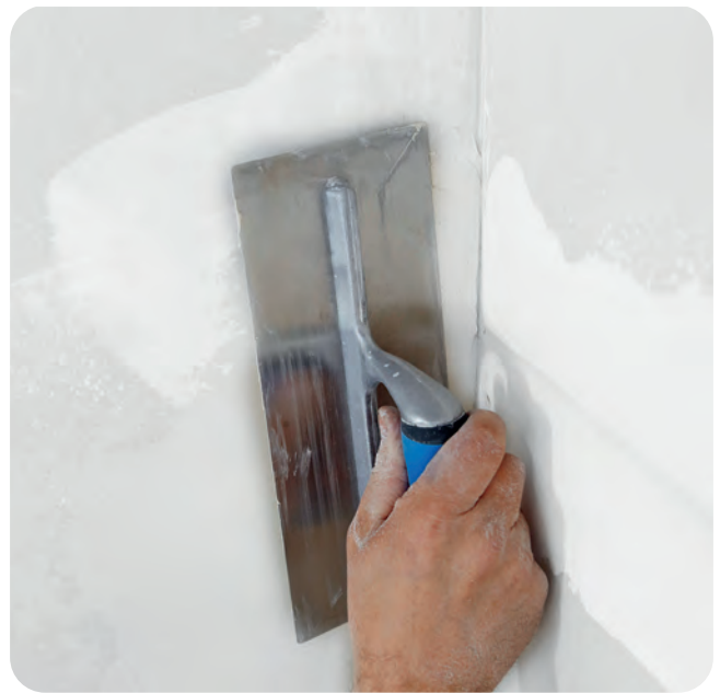
Vorlegen des Spachtelbettes.
