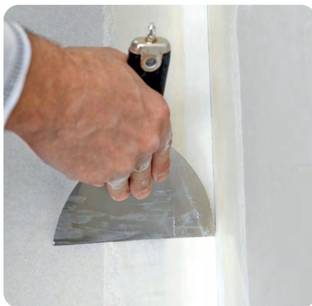
Abziehen des überschüssigen Spachtelmaterials.
