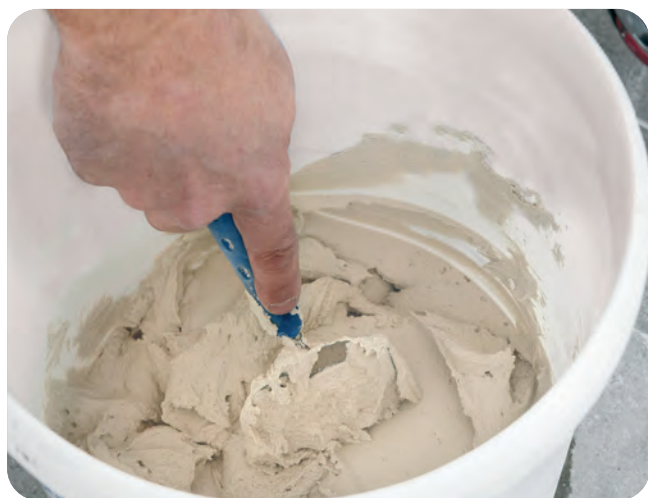
Ca. 3 Minuten Sumpfzeit beachten und das Material danach klumpenfrei verrühren.
