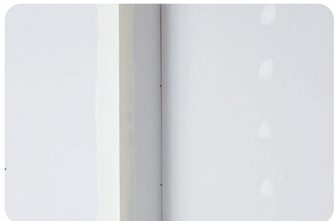
Fertige Außenkante mit Rigips Levelline.
