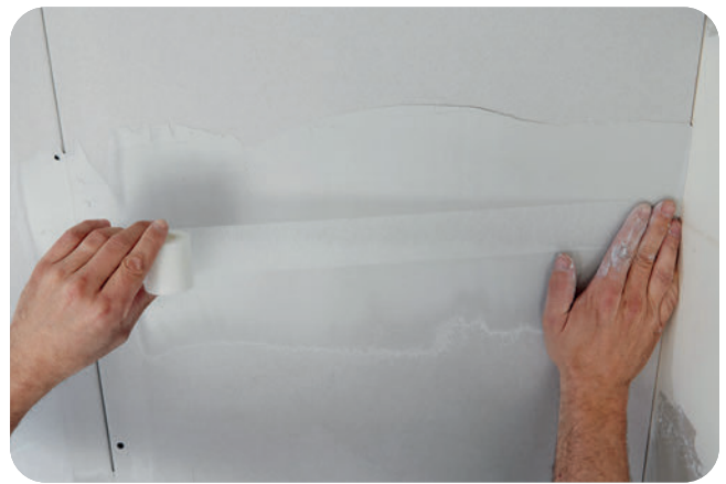
Einlegen des Rigips Glasfaserbewehrungsstreifens.
