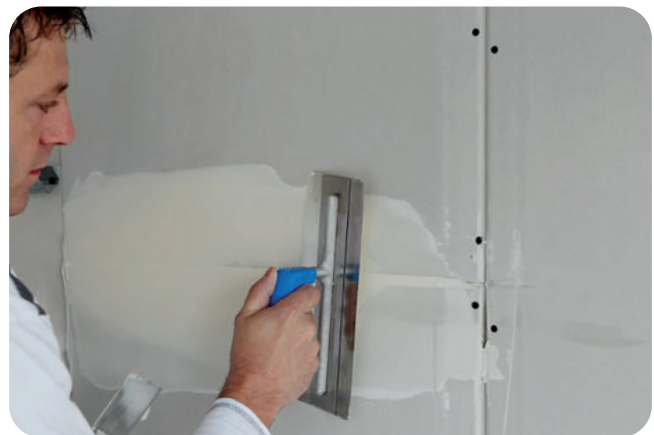
Vorlegen eines ca. 1 mm dicken Spachtelbettes.
