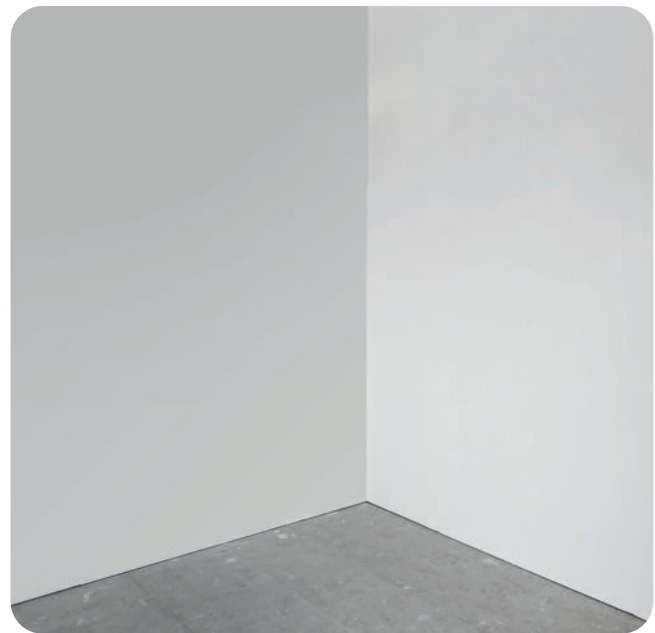
Überzeugendes Resultat: eine makellose weiße Oberfläche. Die technische Fugenverspachtelung wurde komplett mit VARIO Fugenspachtel vorgenommen und die Q3-Qualität dann mit dem ProMix Finish vollendet.
