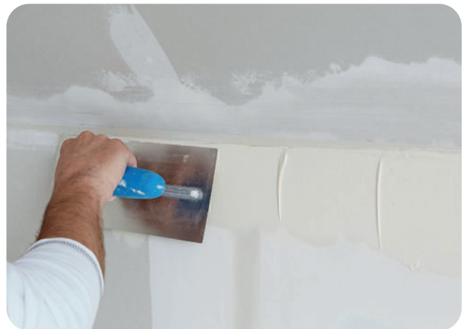
... und Vorlegen des Fugenspachtels.
