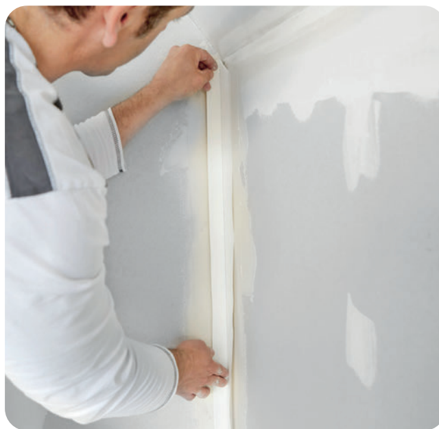
Einlegen des Rigips Levelline im Eckbereich.
