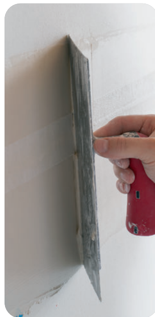
Überziehen des Rigips Glasfaserbewehrungsstreifens ohne zusätzlichen Materialauftrag.
