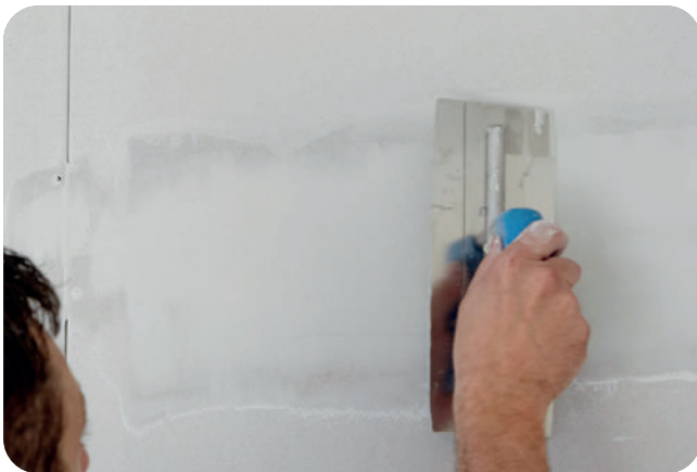
Überziehen des Glasfaserbewehrungsstreifens ohne zusätzlichen Materialauftrag.
