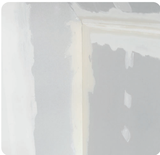
Ausdrücken der Ecken und Vorlegen des Spachtelmaterials.
