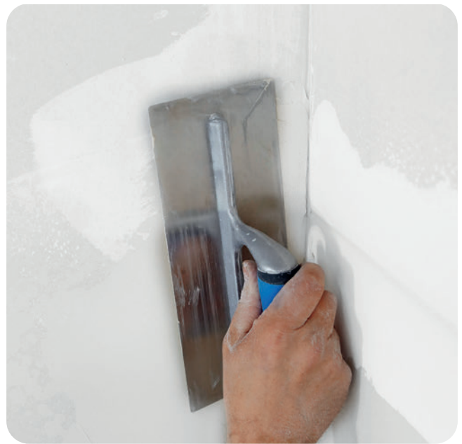
Vorlegen des Spachtelbettes.
