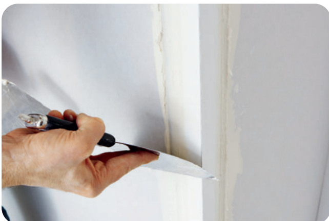
Überflüssige Spachtelmasse wegnehmen und den Rest ausziehen.
