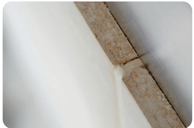
Komplett ausgefüllte Spachtelfuge (von oben) mit planebenem Ergebnis.
