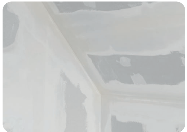
Fertige Dachgeschosssituation mit Rigips Level-line mit unterschiedlichen Winkelstellungen.
