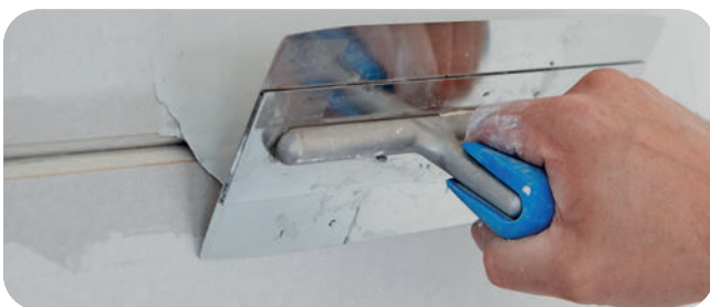
Ausdrücken der Querfugen mit SUPER Fugenfüller.
