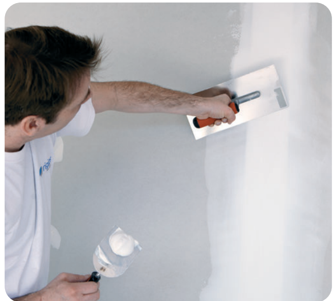
Der ProMix Finish lässt sich problemlos bis auf „null“ ausziehen und schon während dieses Vorgangs ist die hervorragende Oberflächenqualität erkennbar.
