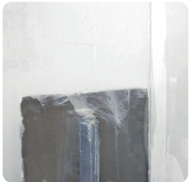
Vorsichtiges Überziehen des Rigips Glasfaserbewehrungsstreifens ohne zusätzlichen Materialauftrag. Nach dem Abbinden des Fugenspachtels erfolgt das anschließende Finish.
