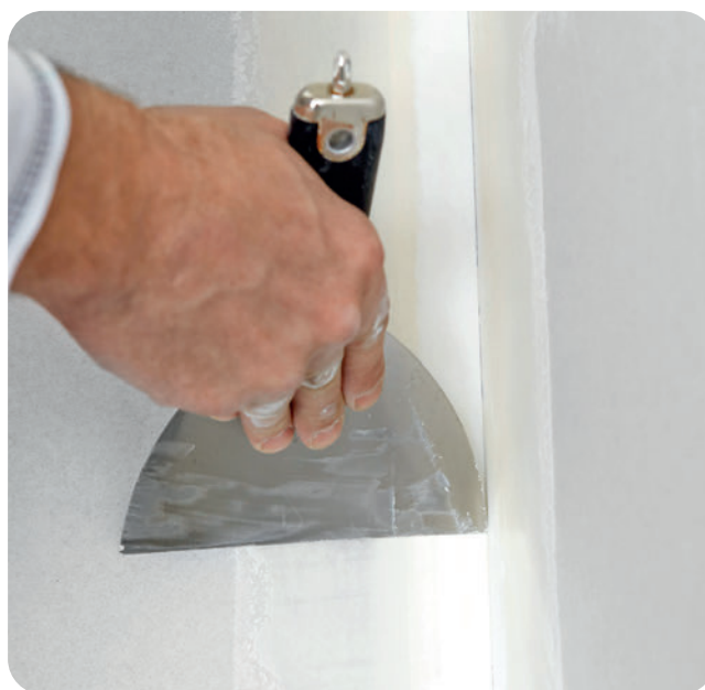
Abziehen des überschüssigen Spachtelmaterials.
