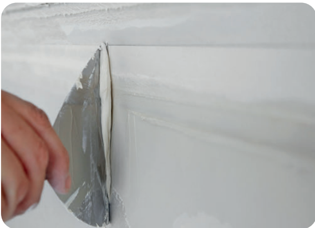
Abziehen des überschüssigen Fugenspachtels.
