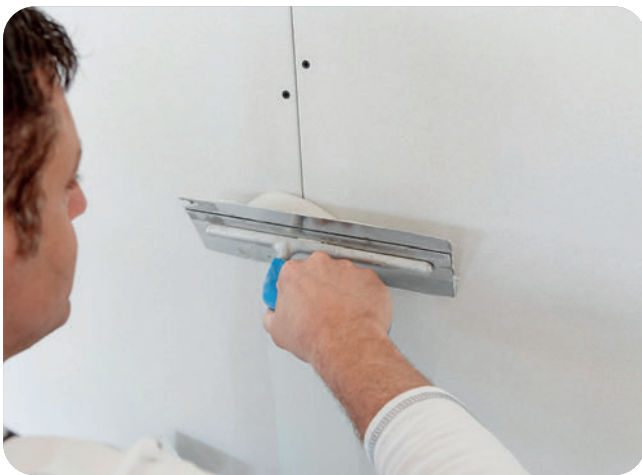
Die Längskante mit SUPER Fugenfüller ausspachteln.
