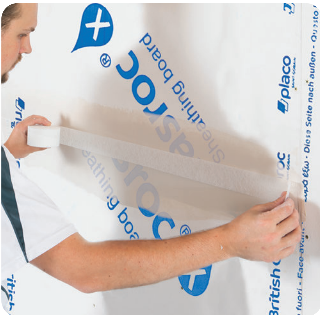
... und unmittelbares Einlegen des Rigips Glasfaserbewehrungsstreifens.
