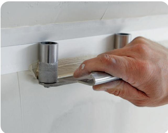
Anpressen des Rigips Levelline mit dem Rigips Einseitenroller sowohl auf der unteren Flanke des Rigips Levelline ...
