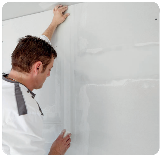
Rigips Glasfaserbewehrungsstreifen von oben einlegen und ...
