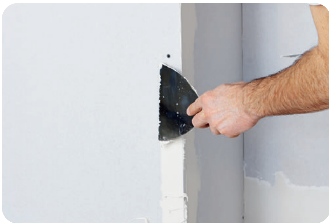
Vorlegen eines dünnen Spachtelbettes.
