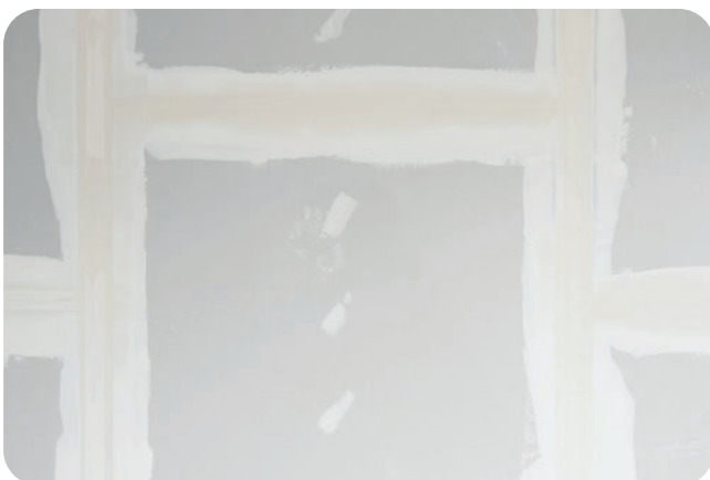
Ergebnis der Wandfläche nach Einlage des Rigips Papierbewehrungsstreifens.
