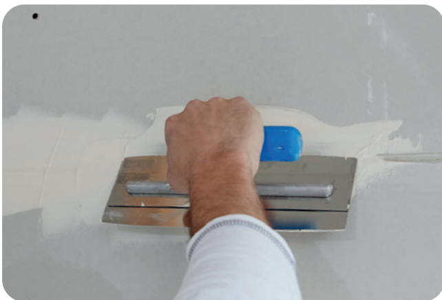
Ausdrücken der Querfugen.
