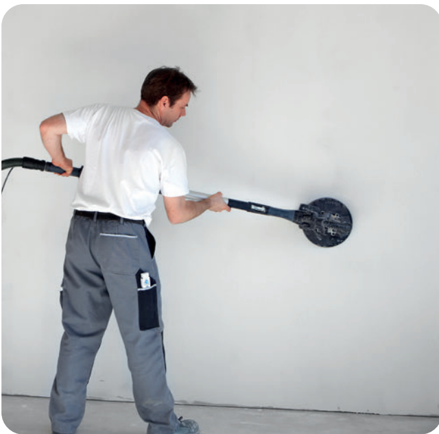
Eventuell Spachtelgrate manuell oder maschinell nachschleifen.
