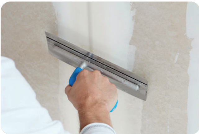
Zur Erzielung einer perfekten Wandoberfläche erfolgt die Nachspachtelung ebenfalls mit VARIO Fugenspachtel.
