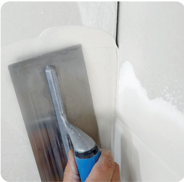
Fugenspalt ausdrücken mit Fugenspachtel.
