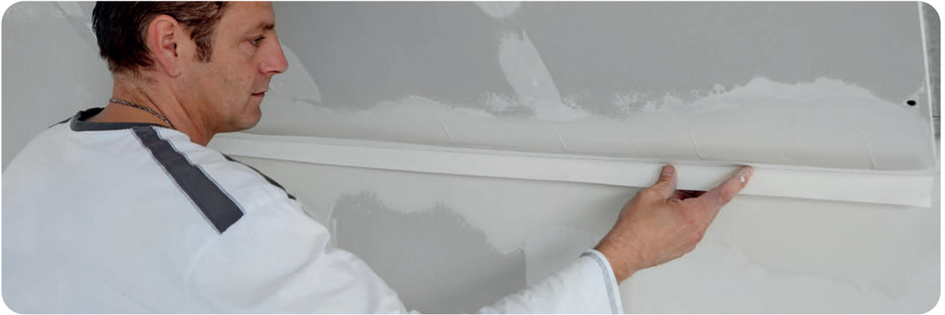
Einlegen des Rigips Levelline in das vorbereitete Spachtelmaterial.
