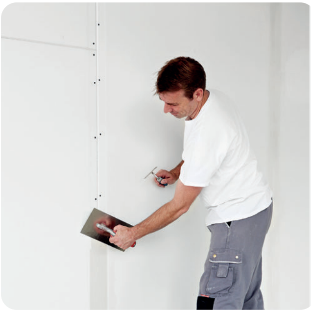
Zunächst die technische Verspachtelung im VARIO-System durchführen. (Siehe S. 32)
