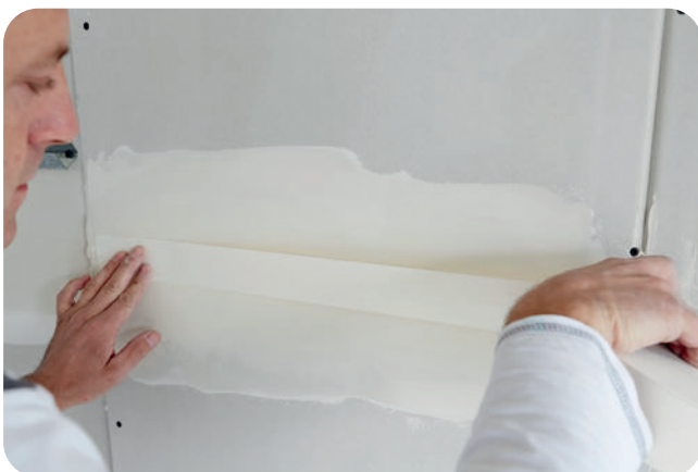
Vorsichtiges Einlegen des Rigips Papierbewehrungsstreifens.
