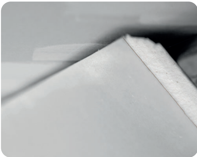
Ausgangssituation im Anschlussbereich zur Kehlbalckendecken.
