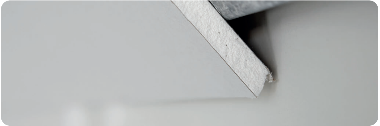
Ausgangssituation im Anschlussbereich zur Abseitenwand.
