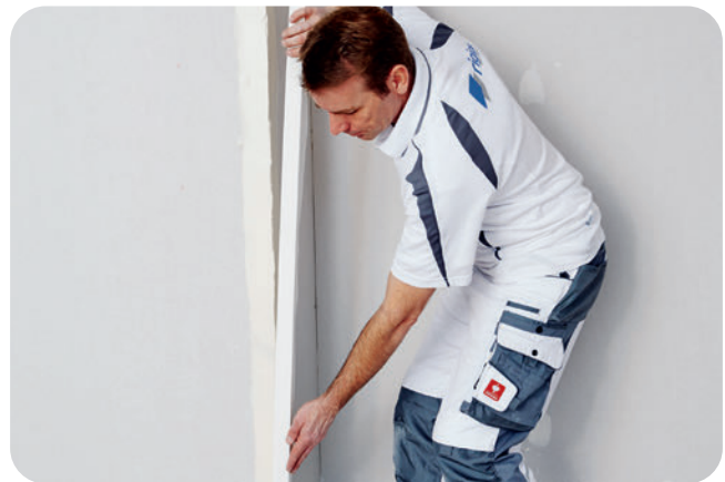
Ansetzen des Rigips Levelline.
