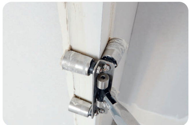
Anpressen mit dem Rigips Außenkantenroller.
