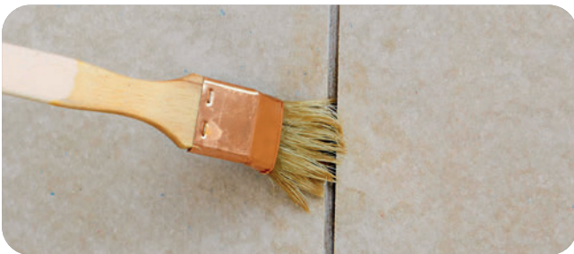
Der Abstand der montierten Platten beträgt ca. 5 bis 7 mm. Wichtig: Die Plattenkanten müssen entstaubt und vorgehässt werden.
