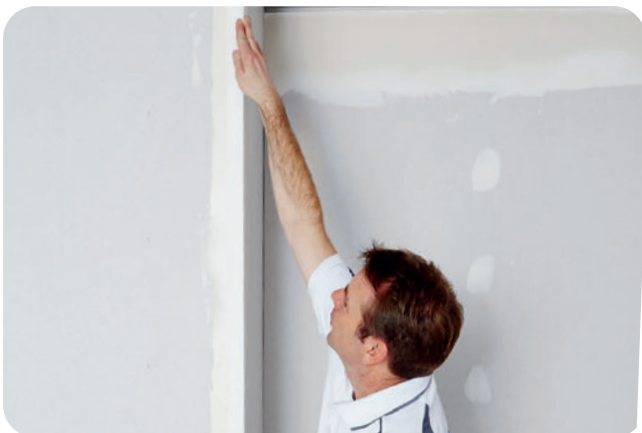
Ausrichten des Rigips Levelline.
