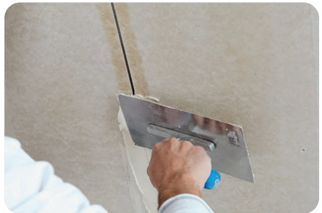
Ausfüllen der Fuge mit VARIO Fugenspachtel. Auf ausreichende Haftung an den Plattenkanten achten.
