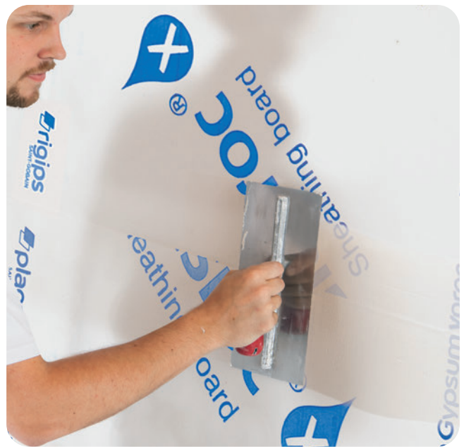
Vorlegen eines ca. 1 mm dicken Spachtelbettes...
