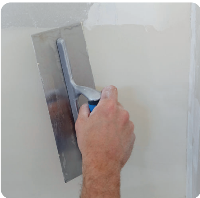
Das Spachtelmaterial wird in langen Zügen auf der Plattenoberfläche bis zum Nullpunkt ausgezogen.
