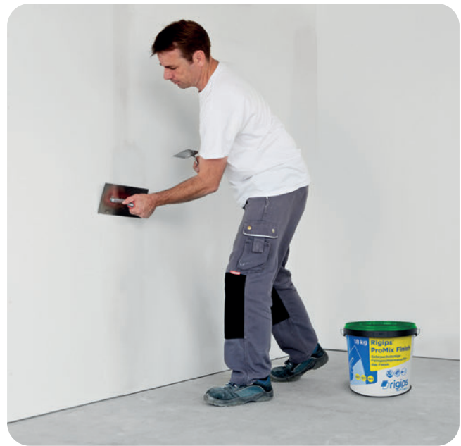
Danach das Fugenfinish mit ProMix Finish durchführen.
