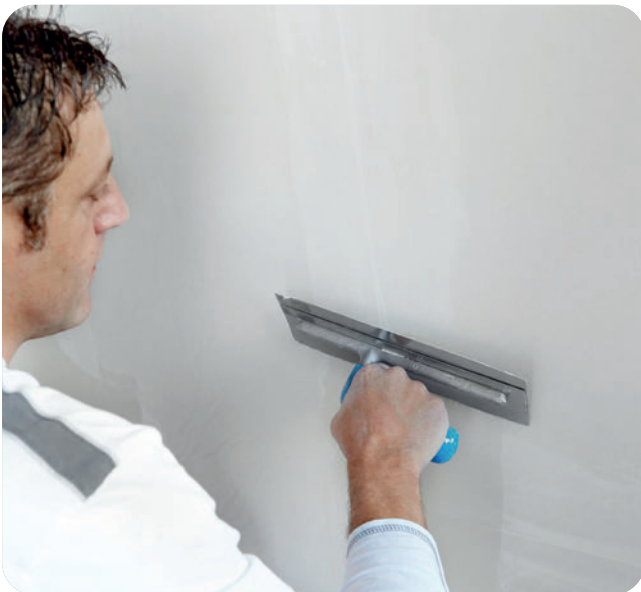
... als auch über die Längsfugen aufgetragen.
