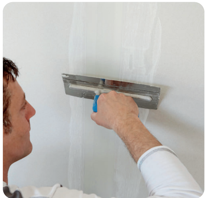
Überziehen des Glasfaserbewehrungsstreifens ohne zusätzlichen Materialauftrag.
