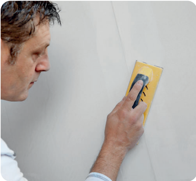
Sobald das Spachtelmaterial der Vorspachtelung abgebunden ist, können evtl. Spachtelgrate abgeschliffen werden, damit der nächste Spachtelvorgang erfolgen kann.
