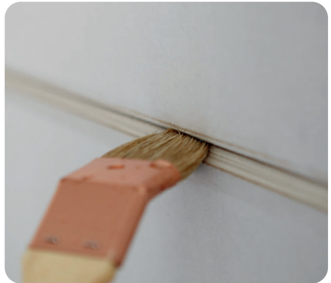
Das Vornässen der Querkanten ist wichtig, damit der Spachtelmasse nicht zu schnell das Wasser entzogen wird.
