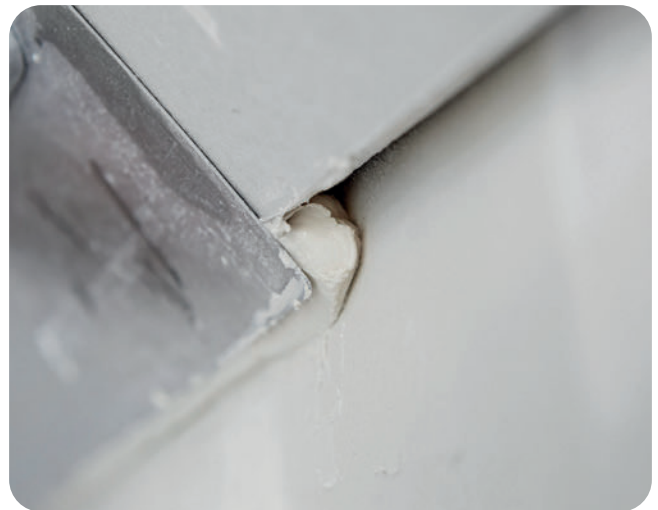
Ausdrücken der Anschlussbereiche mit Fugenspachtel.
