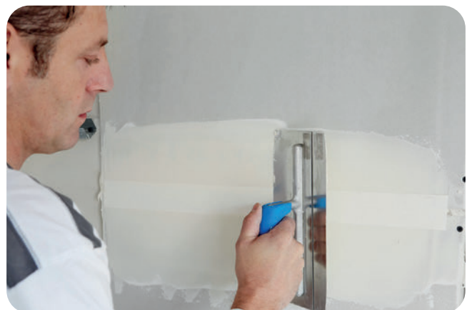
Einbetten des Rigips Papierbewehrungsstreifens ohne zusätzlichen Materialauftrag.
