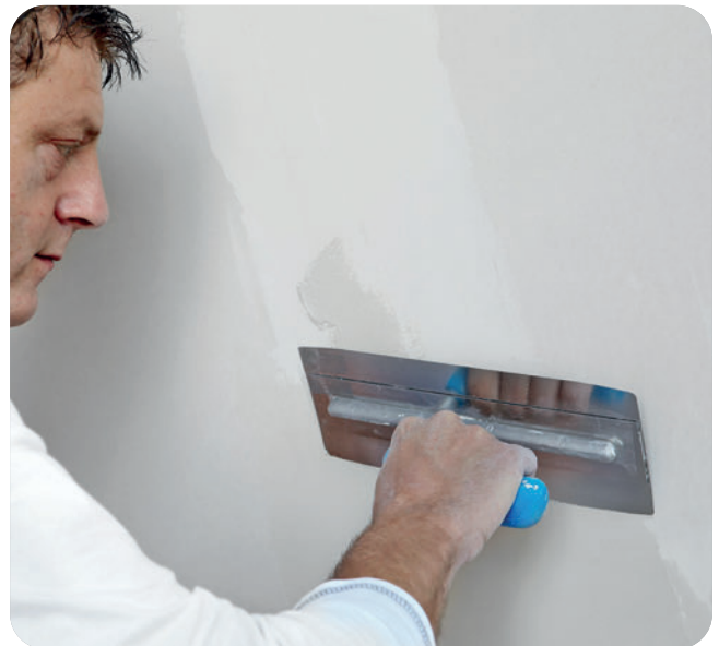
Spachtelmaterial bis auf „null“ ausziehen.
