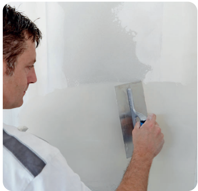
Ist das Material der Vorspachtelung abgebunden, kann die Nachspachtelung ebenfalls mit VARIO Fugenspachtel erfolgen.
