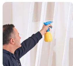
Die Aktivierungszeit des stärkebasierten Klebers beträgt 15 bis 30 Sekunden. zieht der Kleber beim Anheben des Fingers Fäden, ist er verarbeitungsfertig. Falls die Leiste vor dem Anbringen angetrocknet ist, kann der Rigips AquaBead erneut eingesprühnt und der Kleber aktiviert werden.
