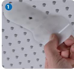
Im Nachgang den leicht angezogenen Rigitone Mix vorsichtig mit dem Rigips Stielspachtel abstoßen **2** und die Fugen anschließend in entgegengesetzter Richtung mit dem Spachtel glattstreichen.
