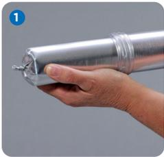
Den Schlauchbeutel mit dem Rigitone Mix in die Pistole einlegen und den Verschluss abschneiden.
