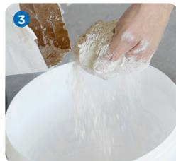
Es empfiehlt sich den Wasseranteil etwas zu erhöhen (ca. 2,8 l Wasser auf 5 kg VARIO Spachtelmaterial). Die dadurch entstehende geschmeidigere Konsistenz des Materials erleichtert die Handhabung mit der Rigitone Fix Pistole.
