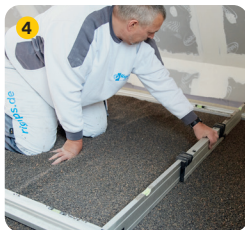
Planebene Schüttungs- oberfläche
