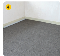
Planebene Oberfläche der gebundenen Schüttung
