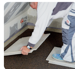
Verlegung der Estrichelemente auf Rigidur Ausgleichschüttung mit Hilfe von Laufinseln
