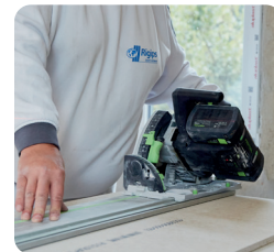
Für den Wandanschluss ist der Stufenfalz abzutrennen
