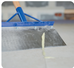
Überschüssigen erhärteten Kleber abstoßen
