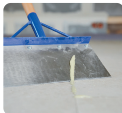
Überschüssigen erhärteten Kleber abstoßen
