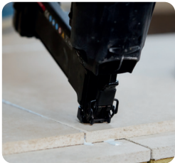
Schnelle Installation bei der Verwendung von Klammern
