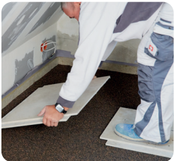
Verlegung der Estrichelemente auf Rigidur Ausgleichsschüttung mit Hilfe von Laufinseln
