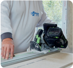
Für den Wandanschluss ist der Stufenfalz abzutrennen
