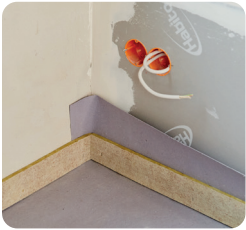
Randdämmstreifen dicht bis in die Wandecke anschließen
