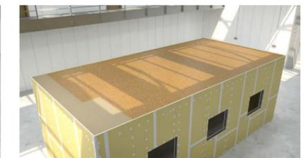
Verlegung der Rigidur Estrichelemente
