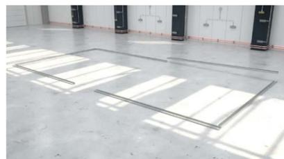
Einbau der UW-Profile für den Bodenanschluss
