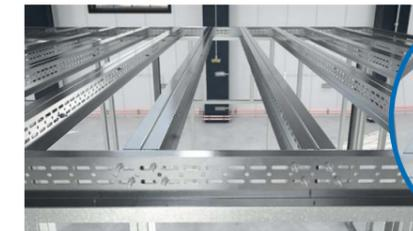
Einbau der UA-Tragprofile in der Decke (Decke ist begehbar) mit Anschluss an Rähm
