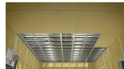
Montage der Tragprofile und der unterseitigen Deckenbekleidung
