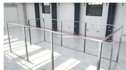
Einbau der UW-Profile am oberen Anschluss
