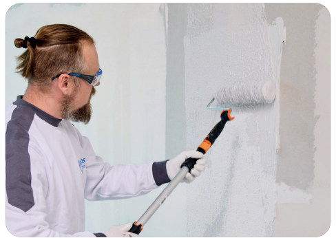
Rigips ProMix Airless gleichmäßig auf die Fläche aufrollen
