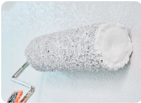
Auftrag mit Rollspachtelwalze
