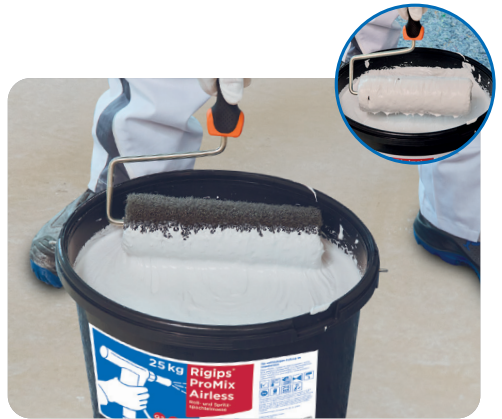
Rollspachtelwalze eintauchen und Spachtelmasse aufnehmen
