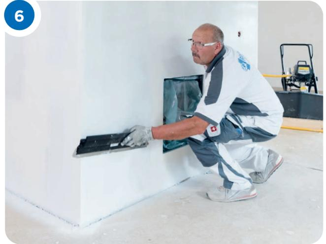
Die frisch aufgetragene Spachtelmasse mit einem Flächenspachtel glatt abziehen und vollständig trocknen lassen
