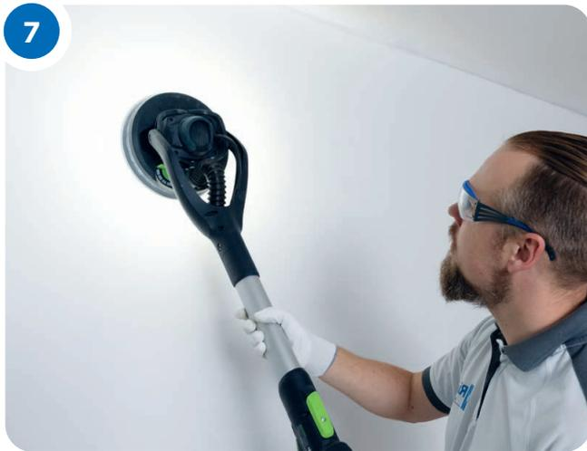
Falls erforderlich, maschinell mit einem 240er- bis 280er-Schleifpapier oder manuell mit einem 240er-Schleifpapier abschleifen
