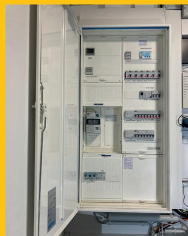
Der Blick in einen typischen Hausanschlusskasten: Wichtig ist die Installation auf einer lichtbogenfesten Wandfläche.
