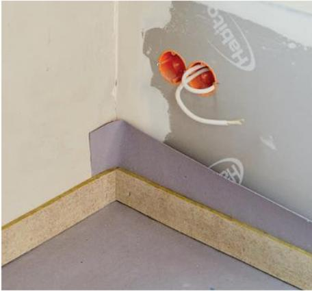
Um Trittschallübertragungen zwischen Boden und Wand (flankierende Bauteile) zu verringern, ist ein Randdämmstreifen vorzusehen und bis auf den Rohboden zu führen. Bei Brandschutzkonstruktionen ist gemäß Zulassung der Rigips Mineralwolle-Randdämmstreifen zu verwenden
