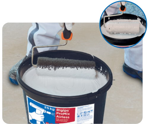
Rollspachtelwalze eintauchen und Spachtelmasse aufnehmen
