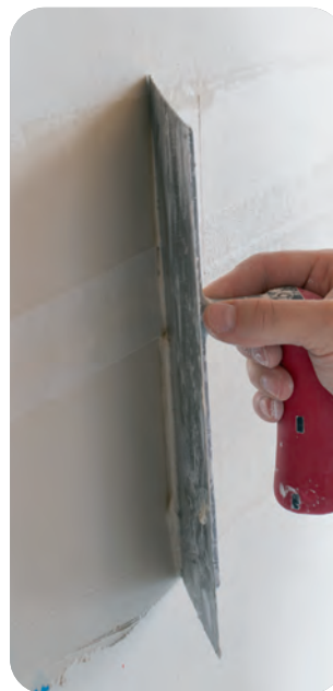
Überziehen des Rigips Glasfaserbewehrungsstreifens ohne zusätzlichen Materialauftrag.
