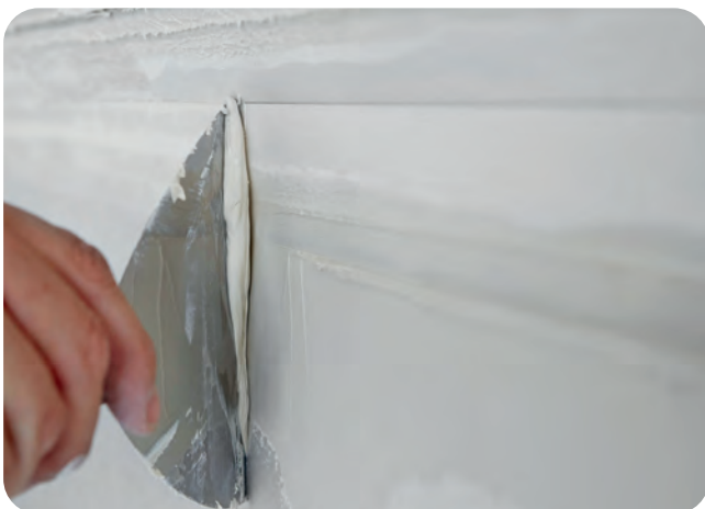
Abziehen des überschüssigen Fugenspachtels.
