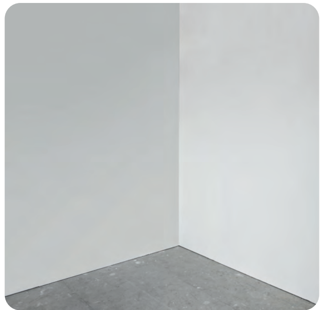
Überzeugendes Resultat: eine makellose weiße Oberfläche. Die technische Fugenerspachtelung wurde komplett mit VARIO Fugenspachtel vorgenommen und die Q3-Qualität dann mit dem ProMix Finish vollendet.
