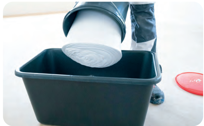
... und die teigartige Rigips ProMix Airless Spachtelmasse in eine Mörtelwanne kippen
