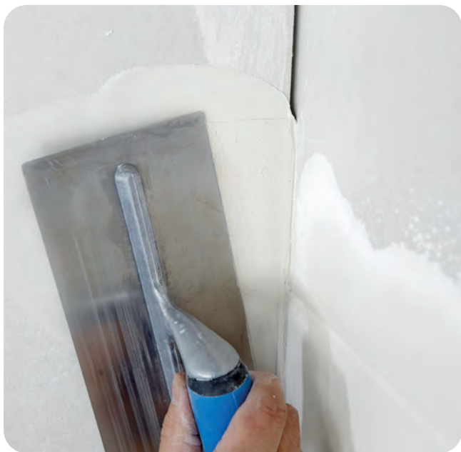
Fugenspalt ausdrücken mit Fugenspachtel.
