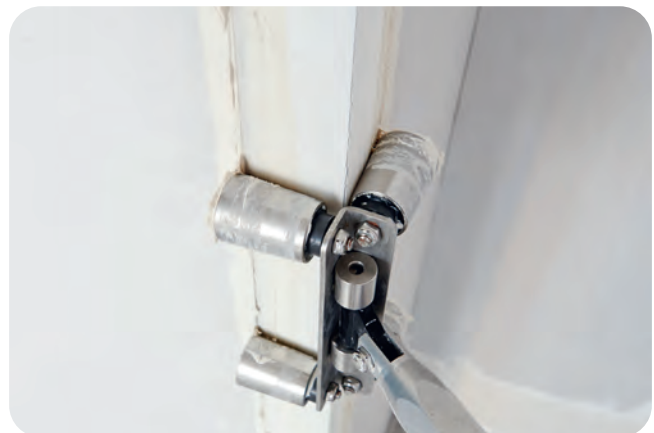
Anpressen mit dem Rigips Außenkantenroller.
