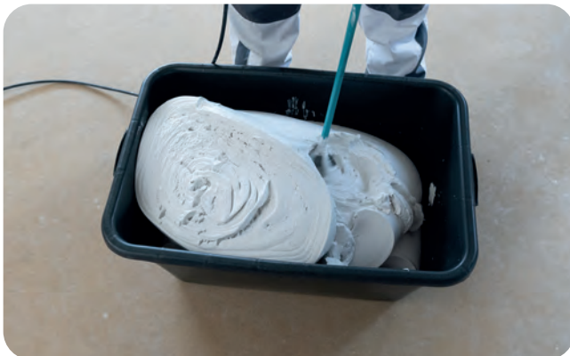
Rigips ProMix Airless mit dem Quirl in der Mörtelwanne aufrühren
