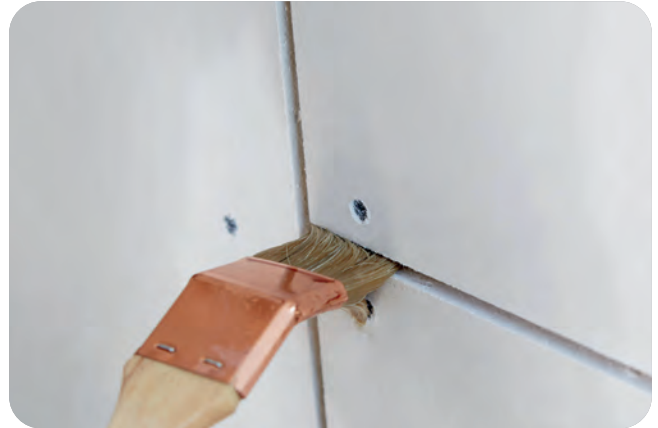
Die Plattenkanten müssen entstaubt und vorgesenst werden.
