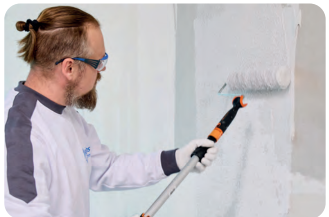
Rigips ProMix Airless gleichmäßig auf die Fläche aufrollen
