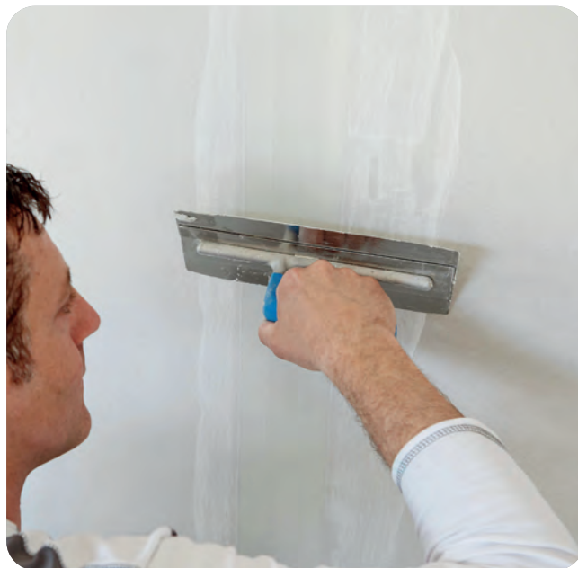
Überziehen des Glasfaserbewehrungsstreifens ohne zusätzlichen Materialauftrag.
