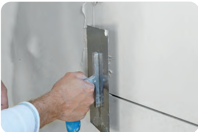
Ausdrücken der Querfugen mit VARIO Fugenspachtel, ...
