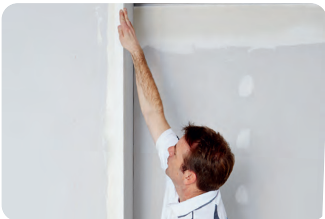
Ausrichten des Rigips Levelline.
