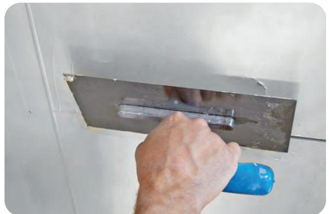
... wobei auf eine ausreichende Flankenhaftung an den Plattenkanten zu achten ist.
