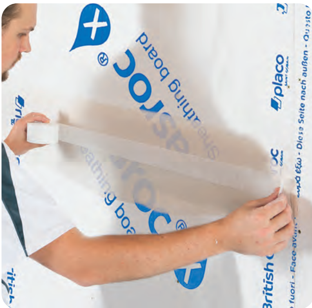
... und unmittelbares Einlegen des Rigips Glasfaserbewehrungsstreifens.
