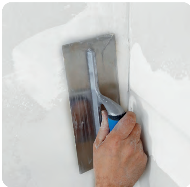
Vorlegen des Spachtelbettes.
