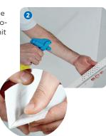
Die AquaBead Leiste wird auf die Kante aufgesetzt und angedrückt. Die Lochseiten der Schenkel können mit Fugenspachtel leicht überspachelt werden und nach dem Antrocknen ist die Anbringung der Wanddekore möglich.
