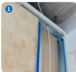
Die Kabel für die benötigten Anschlüsse werden durch die vorgesehenen Kabelöffnungen der RigiMove I- oder C-Modulprofile geführt und vorbereitet. ①
