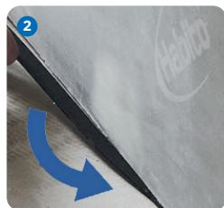
Das vorkomprimierte RigiMove Dichtungsband ist aus den umlaufen den Fugen zu entfernen. **2**
