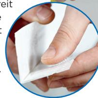
Die AquaBead Leiste wird auf die Kante aufgesetzt und angedrückt. **3** Die Lochseiten der Schenkel können mit Fugenspachtel leicht überspachtelt werden und nach dem Antrocknen ist die Anbringung der Wanddekore möglich.
