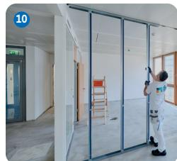
Der Aufbau der I-Modulprofile ist mit dem Aufstellen des letzten RigiMove I-Modulprofils abgeschlossen. **11**
