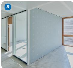
Die letzte Anschlussplatte muss meist ebenfalls auf Breite zugeschnitten und dem Oberflächenverlauf des angrenzenden Bauteils angepasst werden.
