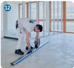
Die noch fehlenden Wandanschlüsse erfolgen mit den RigiMove C-Modulprofilen.
