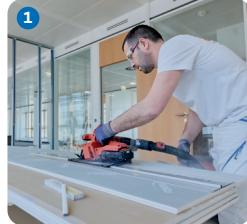
Übertragung der Maße auf die erste RigiMove Systemplatte 12,5 Start- platte. Der Zuschnitt der Startplatte erfolgt an der „Federseite“. ①
