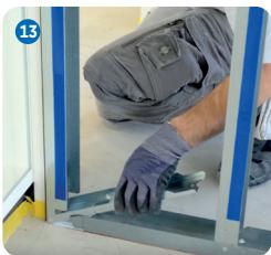
Das untere horizontale Profil wird ausgeklappt und in das untere U-Profil des ersten I-Modulprofils eingefügt. **13**
