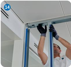
Das vertikale C-Profil wird dann gegen das anzuschließende Bau- teil gedrückt und das obere Modul- teil hochgeschoben. Danach wird das obere horizontale Profilteil des RigiMove C-Modulprofils in das I-Modulprofil eingeklappt und dann mit dem Schnellspanner fixiert. **14**
