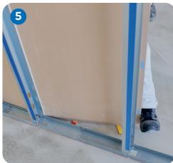
Die Anbringung der Folgeplatte erfolgt, indem die Feder der 2. Platte in die Nut der ersten Platte eingeführt wird. Die Einstellung erfolgt in einem Winkel von ca. 30°. Durch leichtes seitliches Hin- und Herbewegen der 2. Platte bei Druck in Richtung der 1. Platte wird die Fuge ganz geschlossen. **5**
