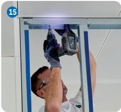
Die Anbringung des C-Modulprofils erfolgt an beiden Wandanschlüssen und wird wie die I-Modulprofile ggf. noch zusätzlich mit geeigneten lösbaren Schrauben an der Decke **15**, ggf. am Boden und am Wandanschluss **16** fixiert.
