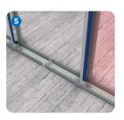
Nach dieser Methode werden nun alle weiteren RigiMove I-Module zusammengeklickt und in einer Linie gemäß dem Laser ausgerichtet.
