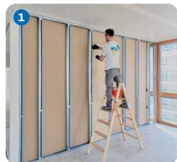
Die ISOVER Akustic TP 1 Lanaé Trennwandplatten, in 60 mm Stärke und 600 mm Breite, passen perfekt zwischen die vertikalen Profile.
