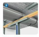
Das Holz wird mit selbstbohrenden Schrauben befestigt.
