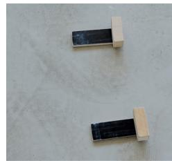
Die Anbringung der ersten Platte erfolgt in exakter vertikaler Aus- richtung. Es empfiehlt sich die Kon- trolle mit der Wasserwaage. Sobald die Platte mit dem Hakenklettband verklebt wird, ist die Startplatte fixiert. ③
