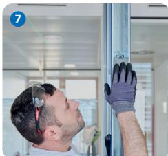
Nach exakter Ausrichtung wird das Modul dann mit dem Schnellspanner fixiert. **7**
