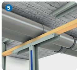
Das Holz wird mit selbstbohrenden Schrauben befestigt.
