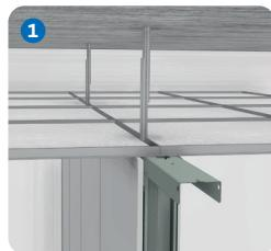
**Variante 1: Verschraubung direkt am Rasterprofil.**
