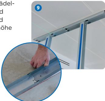
Die Ausrichtung erfolgt wie zuvor in einer Laserlinie oder alternativ mit einer Schlagschnur. Nach dieser Methode werden nun alle weiteren RigiMove I-Modulprofile zusammengeklickt und in einer Linie gemäß vorgegebenen Wandverlauf ausgerichtet. **10**
