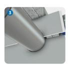
Der entstehende Spalt um das Rohr kann z.B. mit vorkomprimiertem Dichtungsband geschlossen werden.
