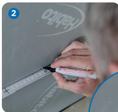
Nach der Plattenbefestigung werden die Öffnungen gemäß Elektroplan ausgemessen und markiert. Die entsprechenden Bohrungen werden vorgenommen um die Öffnungen für Dosen und Schalter zu erstellen. ②
