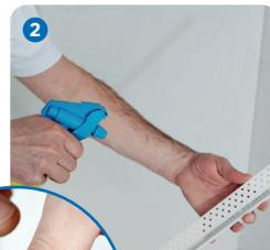
Ob der Kleber einsatzbereit ist, kann per Fingerprobe festgestellt werden. Zieht der Kleber beim Anheben des Fingers Fäden, ist er verarbeitungsfertig.
