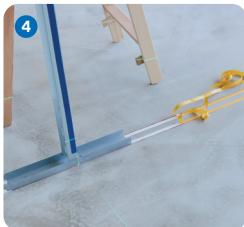
Es erfolgt nun die Platzierung und Aufstellung des ersten RigiMove I-Modulprofils **4**, in dem die horizontalen Ober- und Unterseiten ausgeklappt werden und die Ausrichtung beginnt. **5**
