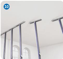
Die gesamte Modul-Wandkonstruktion wird nun zurückgebaut, 10 in dem Schraubenbefestigungen aus den angeschlossenen Bauteilen und die Schnellspanner gelöst werden.
