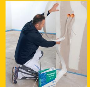
Der Rigips AquaBead Flex PRO wird passend für die gewünschte Eck- oder Kantenausbildung geformt, d. h. auch für schiefwinklige Kanten und Ecken.
