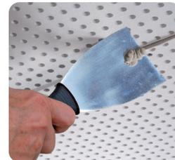
Nach mindestens 24 Stunden Trocknung sind die Fugenbereiche und überspachtelten Schraubenköpfe schleifbar und für die gewünschte weitere Oberflächenbehandlung vorbereitet.
