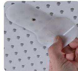
Im Nachgang den leicht angezogenen Rigitone Mix vorsichtig mit dem Rigips Stielspachtel abstoßen und die Fugen anschließend in entgegengesetzter Richtung mit dem Spachtel glattstreichen.
