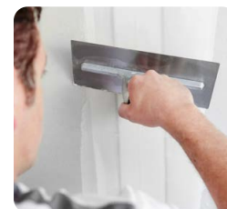
Spachteln ohne Rigips Bewehrungsstreifen
