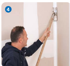
Innenkante mit dem Rigips Innenkantenroller
