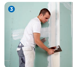
Verspachtelung / Fertigstellung
