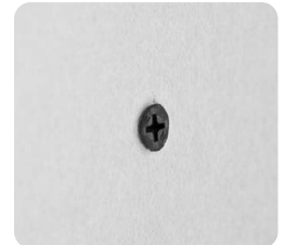
Korrekt eingedrehte Schraube
