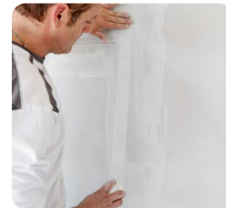
Spachteln mit Rigips Bewehrungsstreifen
