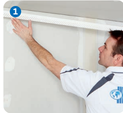
Abschlusskante ausrichten
