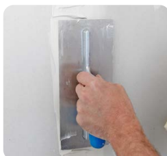
Ausdrücken und blasenfreies Verfüllen
