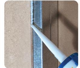
Die nächste Platte mit max. 1 mm Fugenspalt an die erste andrücken. Beim Zusammenpressen muss der Fugenkleber die gesamte Fuge ausfüllen.
