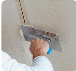
**Nachspachteln:** Erst nach Aushärtung der Vorspachtelung darf weiter gearbeitet werden. Die Nachspachtelung mit dem gleichen Fugenmaterial der Vorspachtelung aufbringen oder Rigips Fertigsachtel (ProMix Finish) verwenden.
