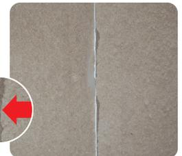
Überschüssiger Fugenkleber quillt aus der Fuge heraus und wird nach Aushärtung mit einem Spachtel abgestoßen.
