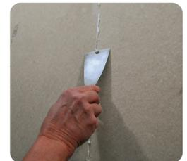
Für ein optisch perfektes Ergebnis werden die Schraubenköpfe und Schadstellen verspachtelt und die Klebefuge nach kompletter Aushärtung noch mit VARIO Fugenspachtel oder ProMix Finish Fertigspachtelmasse abgezogen.
