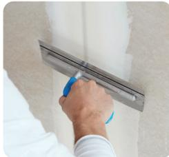
Komplett ausgefüllte Spachtelfuge (von oben) mit planebenem Ergebnis.
