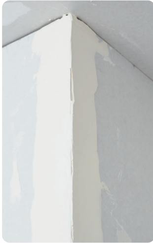
Vorlegen eines dünnen Spachtelbetts an einer Außenecke.
