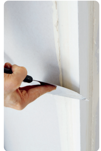
Überschüssige Spachtelmasse wegnehmen und Rest ausziehen.
