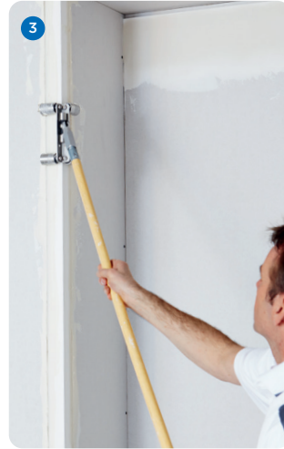
Anpressen mit dem Rigips Außenkantenroller 90°. Durch die leicht konische Rollenstellung wird die überflüssige Spachtelmasse nach außen gedrückt.
