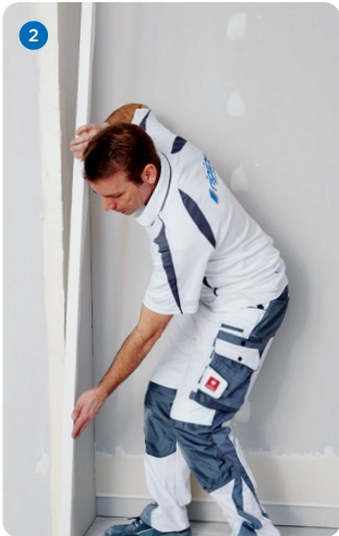
Ansetzen und Ausrichten des Rigips Levelline.
