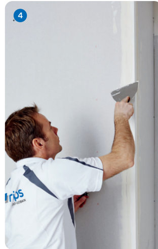
Überschüssige Spachtelmasse wegnehmen und Rest ausziehen.
