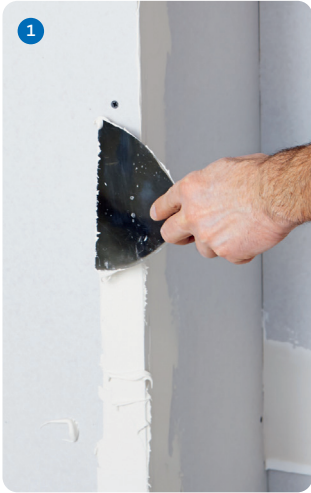
Vorlegen eines dünnen Spachtelbetts an einer Außenecke.
