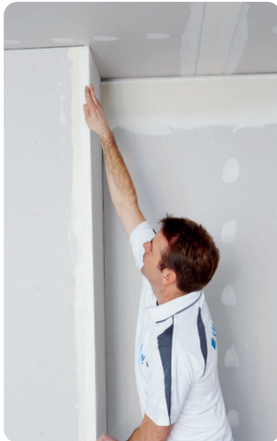
Ansetzen und Ausrichten des Rigips Levelline.
