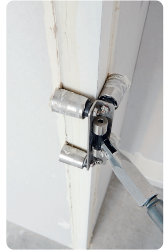
Anpressen mit dem Rigips Außenkantenroller 90°. Durch die leicht konische Rollenstellung wird die überflüssige Spachtelmasse nach außen gedrückt.
