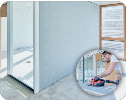
Die letzte Platte mit ca. 5 mm Abstand zum angrenzenden Bauteil montieren, anschließend das Fugendichtband anbringen.
