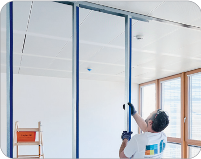
Positionierung und Ausrichtung der RigiMove Profile, am besten per Laser.
