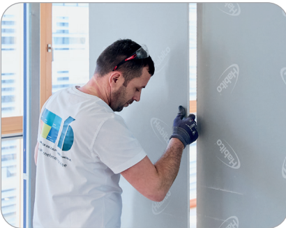
Danach folgt die Demontage aller Systemplatten.
