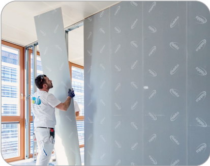
Alle RigiMove Systemplatten mit 5 mm Randabstand positionieren und ankletten.
