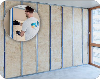
Nach der Beplankung der ersten Wandseite die Dämmung ISOVER Akustic TP 1 Lanaé einbringen. Dann die andere Seite beplanken.
