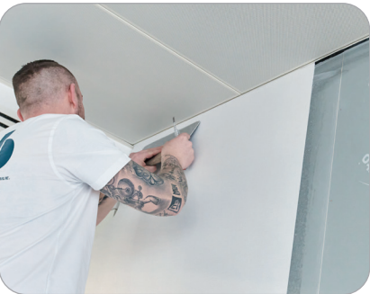
Die Adfors Novelio Nature Tapete senkrecht anbringen und mit einem Kunststoffspachtel glatt streichen.
