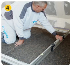
Flat pouring surface
