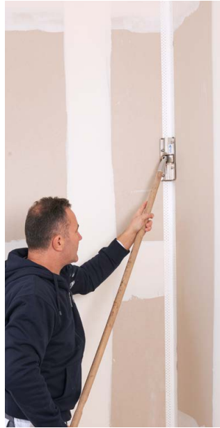
... oder bei einer Innenkante mit dem Rigips Innenkantenroller.
