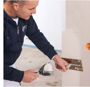
Nach ca. 20 Minuten kann die Ecke mit VARIO Fugenspachtel vorgespachtelt werden.
