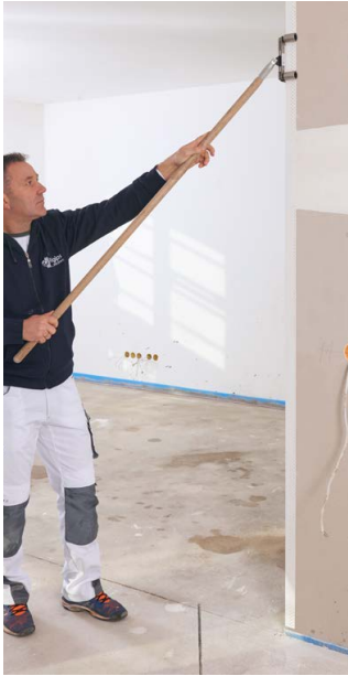
Anpressen mit dem Kantenroller. Für Außenecken mit dem Rigips Außenkantenroller für 90°-Winkel ...
