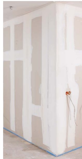
Fertige Außenkante mit dem flexiblen Kantenschutz Rigips AquaBead Flex PRO.
