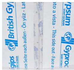
Rigips Glasroc X-Platten, Stoß mit Fugenband abgeklebt
