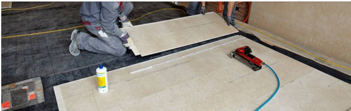
Abbildung 12: Verlegung von Rigidur Estrichelementen
