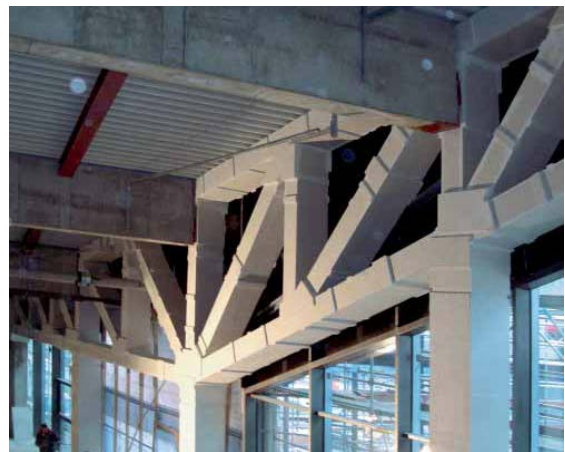
Abbildung 11: Stützen- und Trägerbekleidung
