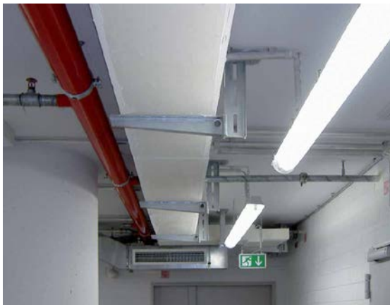
Abbildung 10: Kabelkanal
