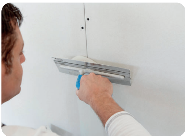
Die Längskante mit SUPER Fugenfüller ausspachteln.
