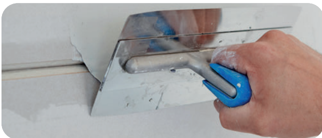
Ausdrücken der Querfugen mit SUPER Fugenfüller.
