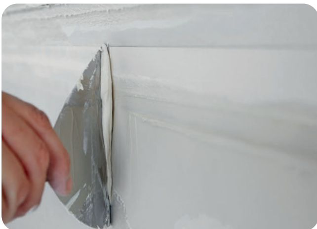
Abziehen des überschüssigen Fugenspachtels.
