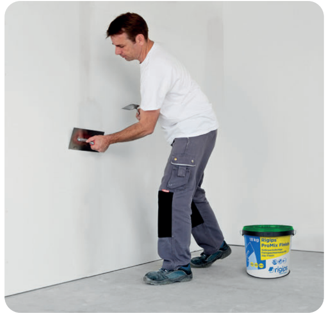
Danach das Fugenfinish mit ProMix Finish durchführen.
