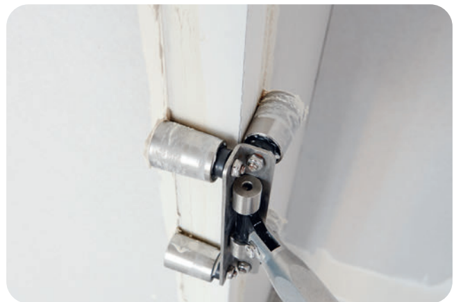
Anpressen mit dem Rigips Außenkantenroller.
