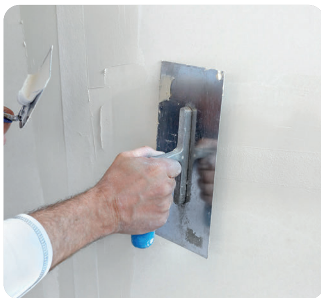
Nach dem Abbinden des Fugenspachtels kann die Nachspachtelung erfolgen.
