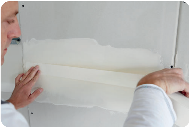
Vorsichtiges Einlegen des Rigips Papierbewehrungsstreifens.
