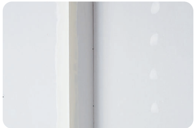
Fertige Außenkante mit Rigips Levelline.
