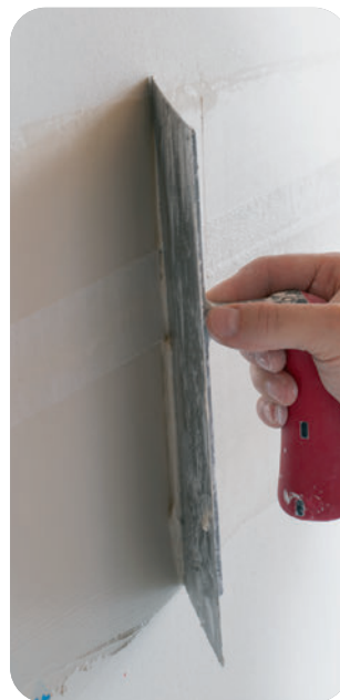
Überziehen des Rigips Glasfaserbewehrungsstreifens ohne zusätzlichen Materialauftrag.
