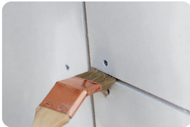
Die Plattenkanten müssen entstaubt und vorgesenst werden.
