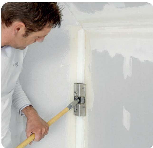
Anpressen des Rigips Levelline mit dem Rigips Innenkantenroller.
