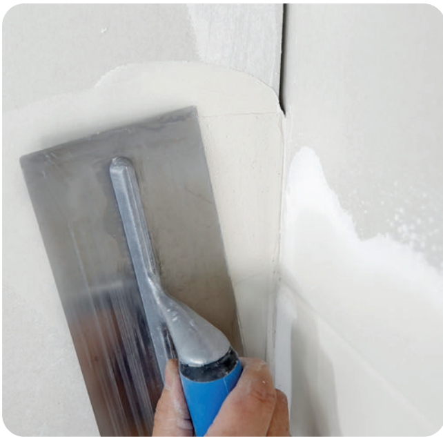
Fugenspalt ausdrücken mit Fugenspachtel.
