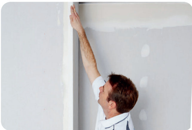
Ausrichten des Rigips Levelline.
