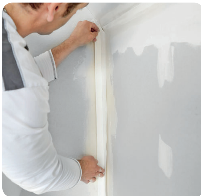
Einlegen des Rigips Levelline im Eckbereich.
