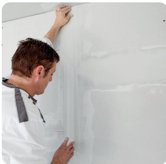
Rigips Glasfaserbewehrungsstreifen von oben einlegen und ...
