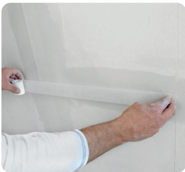
Der Rigips Glasfaserbewehrungsstreifen wird auf den VARIO Fugenspachtel aufgelegt. Im Anschlussbereich der Längs- und Querfugen darf es zu keiner Überlappung der Glasfaserbewehrungsstreifen kommen.
