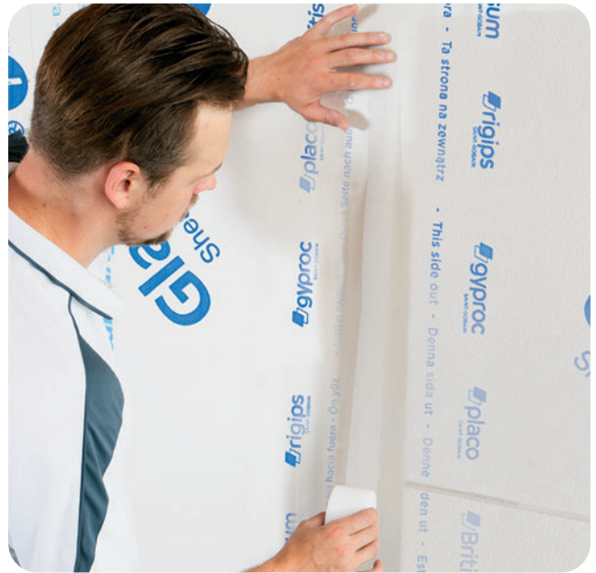
Rigips Glasfaserbewehrungsstreifen einlegen und entsprechend ablängen.
