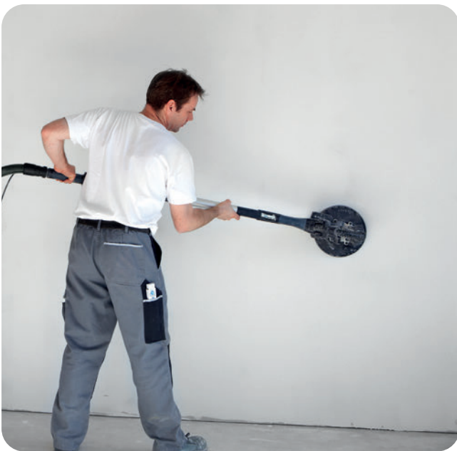
Eventuell Spachtelgrate manuell oder maschinell nachschleifen.
