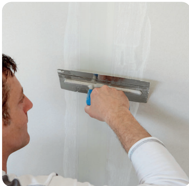
Überziehen des Glasfaserbewehrungsstreifens ohne zusätzlichen Materialauftrag.
