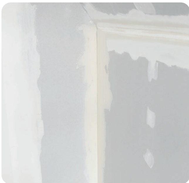
Ausdrücken der Ecken und Vorlegen des Spachtelmaterials.
