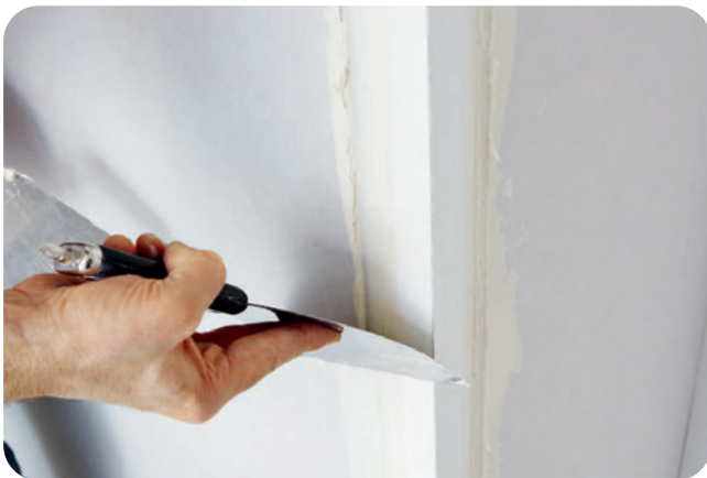
Überflüssige Spachtelmasse wegnehmen und den Rest ausziehen.
