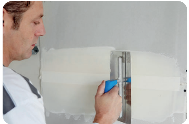
Einbetten des Rigips Papierbewehrungsstreifens ohne zusätzlichen Materialauftrag.
