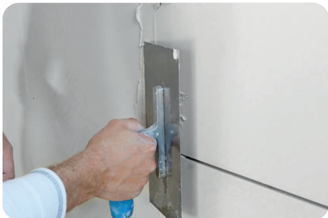
Ausdrücken der Querfugen mit VARIO Fugenspachtel, ...
