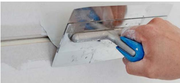
Ausdrücken der Querfugen mit SUPER Fugenfüller.
