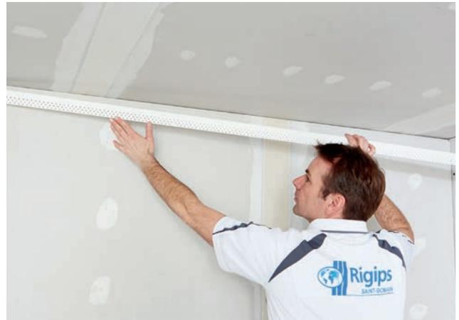
Die angefeuchtete, klebende Seite des Rigips AquaBead L-Trims auf die gewünschte Abschlusskante setzen. Gerade bzw. lotrecht ausrichten.
