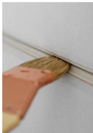
Gipsstaubentfernung für eine gute Haftung zwischen Spachtelmasse und Plattenquerkante.
