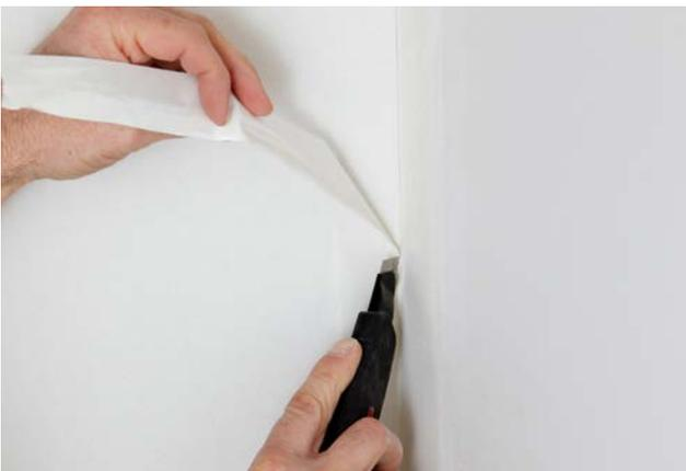
Der Überstand des Rigips TrennFix wird flächenbündig abgetrennt, womit eine kontrollierte Bauteiltrennung erfolgt.
