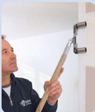
...oder bei einer Innenkante mit dem Rigips Innenkantenroller. Die Verarbeitungsabläufe sind gleich einer Außenkante. Lediglich die Verformung des Rigips AquaBead Flex PRO erfolgt mit der Klebeseite dann gemäß der Innenkante nach innen.
