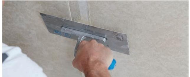
Der VARIO Fugenspachtel wird aufgebracht und flächenbündig abgezogen.
