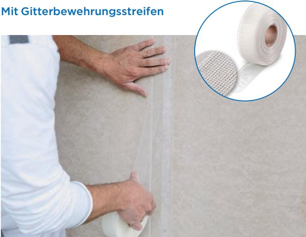
Die Platten werden an den abgeflachten Kanten stumpf gegeneinander gestoßen. Der selbstklebende Rigips Gitterbewehrungsstreifen wird direkt auf die abgeflachten Kanten aufgeklebt.
