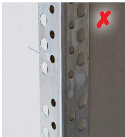
Baustellentypisch, aber falsch ist das Befestigen des Alu-Eckschutzes mit Klammern – das sogenannte Tackern. Durch das fehlende Spachtelbett fehlt die Bindung zum Untergrund und somit die Haftung. Die Gefahr von Rissbildung ist groß.
