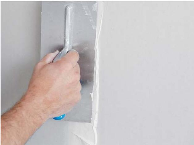
Die Längsfugen werden mit Spachtelmaterial ausgedrückt.
