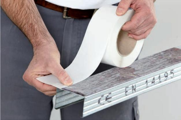
Aufbringung der Rigips Anschlussdichtung auf das zu verwendende Profil. Anschließend wird der Rigips TrennFix aufgeklebt. Der Überstand ragt über die Profilbreite hinaus. Der Rigips TrennFix kann auf beiden Seitenbereichen des Profils angebracht werden.
