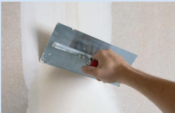
Überziehen des Rigidur Gewebebandes ohne zusätzlichen Materialauftrag. Alternativ kann Rigidur Nature Line Kleber oder Holzleim auf die fertige und zuvor grundierte Spachtelfuge aufgebracht werden.
