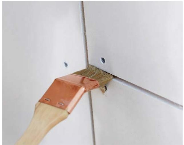
Die Plattenkanten müssen entstaubt und vorgespachtelt werden.
