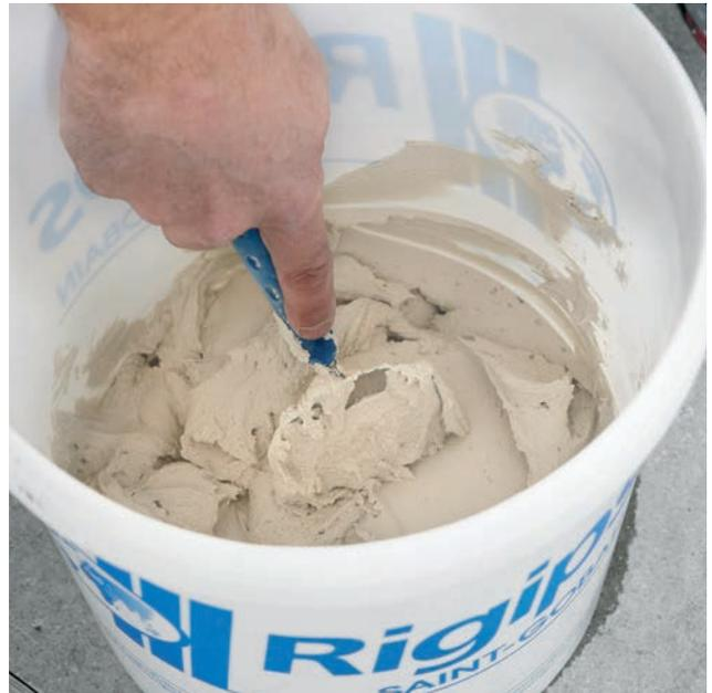
Das Anrühren des Fugen- und Flächenspachtels VARIO H erfolgt analog dem Anrühren des VARIO Fugenspachtels. Die fertig angerührte Spachtelmasse entspricht auch farblich der Rigips Glasroc X Plattenoberfläche. Die Produkte sind auf das Rigips Glasroc X System entsprechend abgestimmt.
