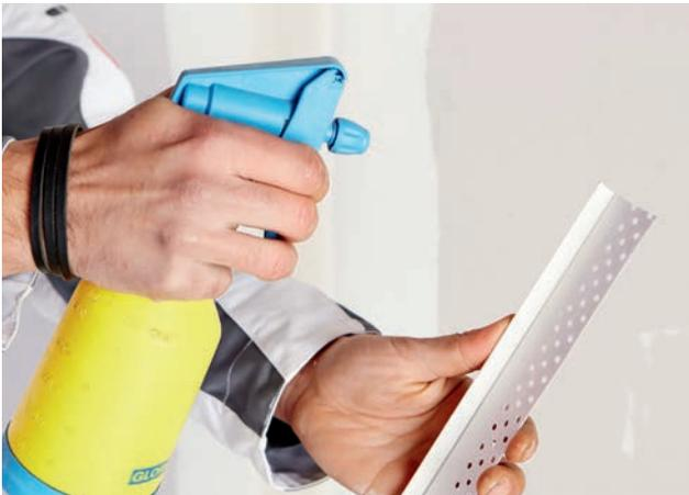
Aktivieren Sie den Kleber durch Besprühen des Rigips AquaBead L-Trims mit Leitungswasser.
