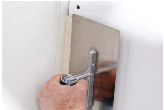
Ausdrücken der Fuge mit Spachtelmaterial und planeben abspachteln. Nach dem Aushärten des Fugenspachtels evtl. Spachtelgrate entfernen und Anschlussbereiche evtl. schleifen.
