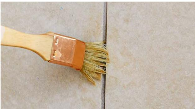
Der Abstand der montierten Platten beträgt ca. 5 bis 7 mm. Wichtig: Die Plattenkanten müssen entstaubt und vorgenässt werden.
