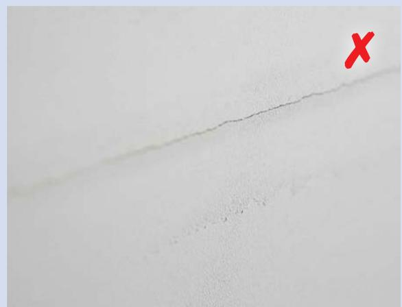
Fehler! Werden die Kanten nicht angefeuchtet, kommt es zum Aufbrennen der Spachtelmasse und zum Abriss in der Fuge.
