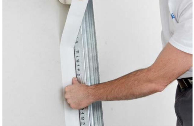
Alternativ: Rigips TrennFix direkt neben das an die Wand angebrachte CW-Profil auf die Wand aufkleben bzw. auf das anzuschließende Bauteil kleben. Der Klebestreifen ist hierbei parallel zum Profil aufzubringen.
