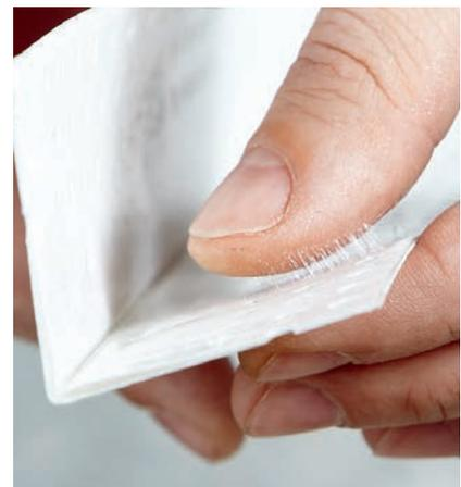
Ob der Kleber einsatzbereit ist, können Sie per Fingerprobe feststellen. Zieht der Kleber beim Anheben des Fingers Fäden, ist er verarbeitungsfertig. Sollten Sie bemerken, dass die Klebefläche vor dem Anbringen wieder angetrocknet ist, sprühen Sie sie einfach wieder ein und warten erneut, bis der Kleber aktiviert ist.
