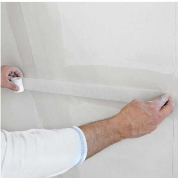
Der Rigips Glasfaserbewehrungsstreifen wird auf den VARIO Fugenspachtel aufgelegt. Im Anschlussbereich der Längs- und Querfugen darf es zu keiner Überlappung der Glasfaserbewehrungsstreifen kommen.
