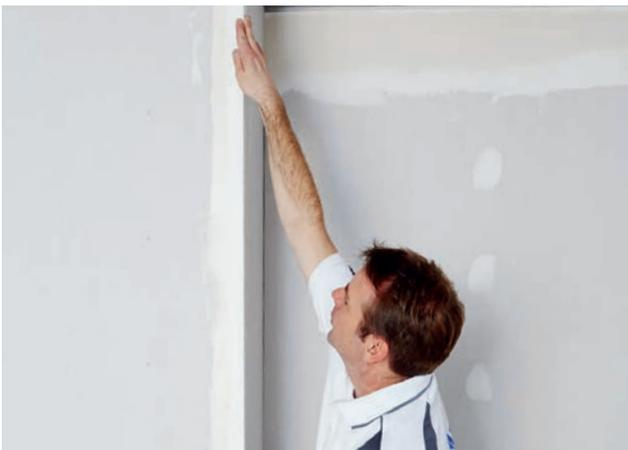
Ausrichten des Rigips Levelline.
