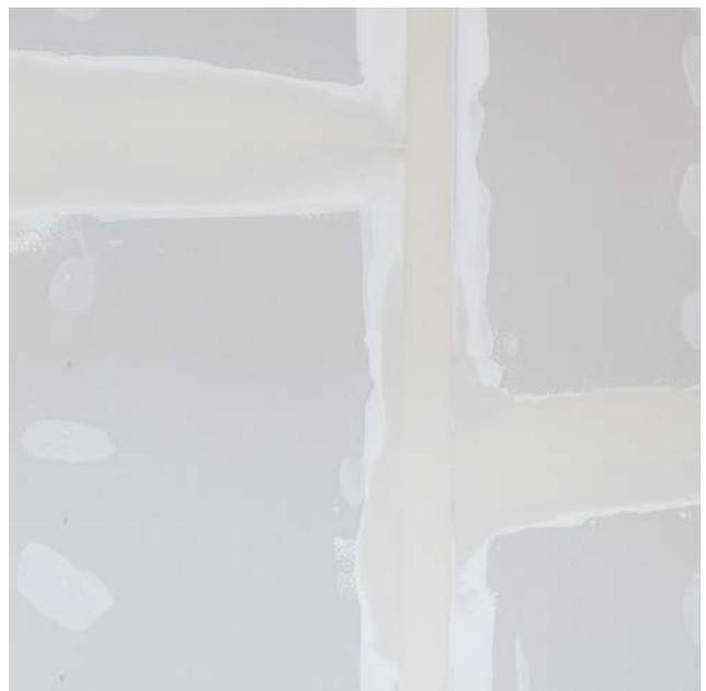
Ergebnis der Vorspachtelung (bei Quer- und Längsfugen)
