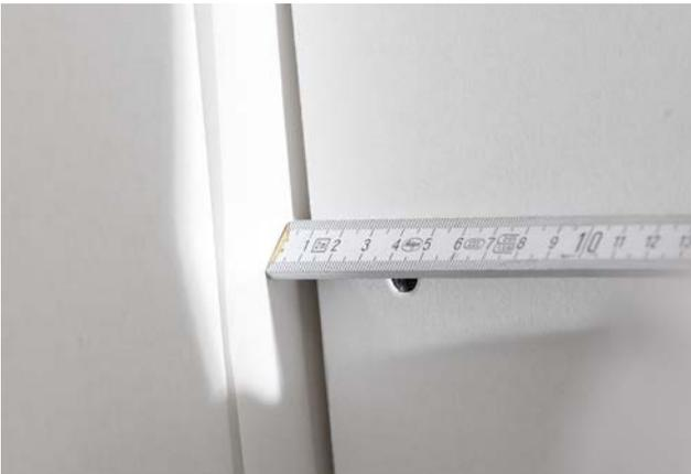
Gipsplatten mit ca. 5 mm Fugenabstand zur Wand montieren.
