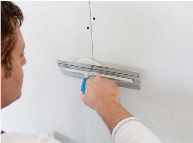
Die Längskante mit SUPER Fugenfüller ausspachteln.
