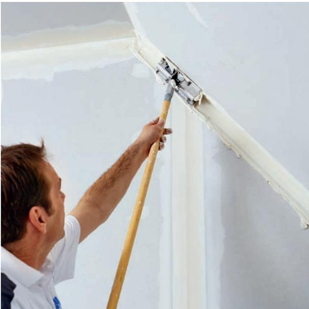
... anschließend mit dem entsprechenden Kantenroller anpressen.
