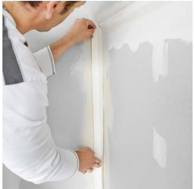
Einlegen des Rigips Levelline im Eckbereich.
