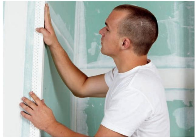
Rigips AquaBead mittig ansetzen und ausrichten.
