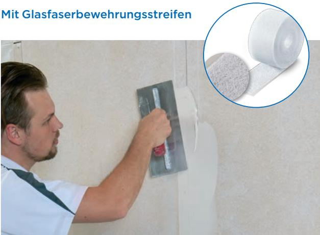
Die Verspachtelung kann sowohl mit dem Rigips Glasfaserbewehrungsstreifen als auch dem Rigips Papierbewehrungsstreifen erfolgen. Hierbei die Längs- und Quertugen mit VARIO Fugenspachtel füllen und quer zur Fuge und flächenbündig abziehen.
