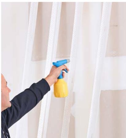
Aktivieren Sie den Kleber, indem Sie die Rückseite der Rigips AquaBead-Produkte mittels einer Sprühflasche mit Leitungswasser besprühen.
