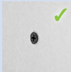
Korrekt eingedrehte Schraube.
