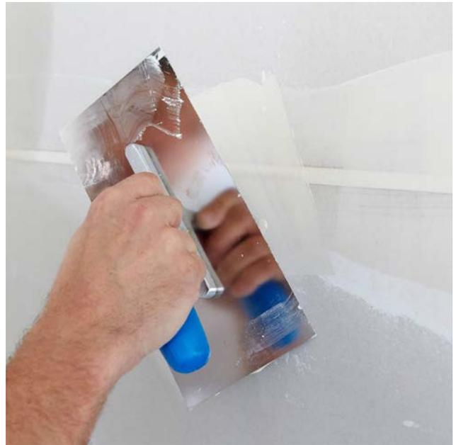
Beim Verfüllen der Queranten ist darauf zu achten, dass der Fugenspachtel vom Bewegungsablauf zunächst von unten nach oben in die Querfuge gedrückt und danach von oben nach unten abgezogen wird. Das gewährleistet ein gleichmäßiges Ausfüllen und sicheres Anhaften des Fugenspachtels an den Plattenqueranten.
