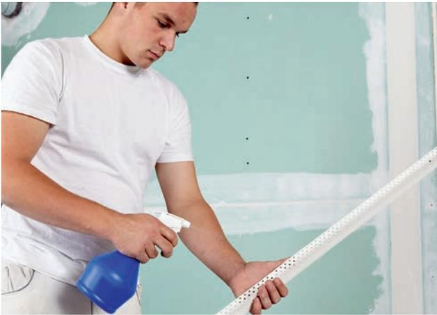
Die Klebefläche des Rigips AquaBeads wird durch Besprühen mit Leitungswasser aktiviert.
