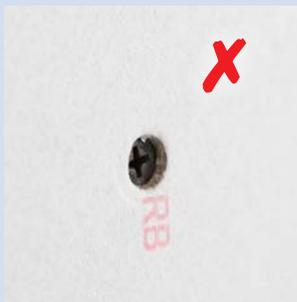
Schraube zu tief eingedreht – Karton wird zerstört.
