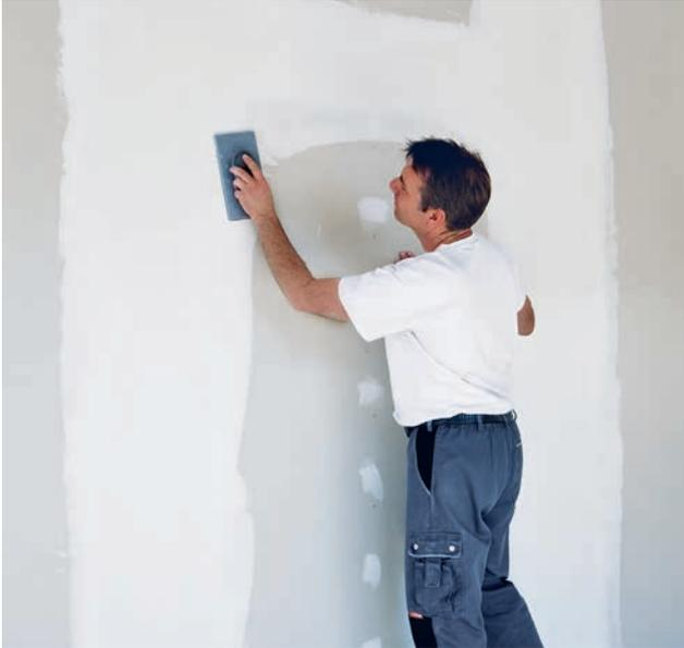
Ob ein Nachschleifen (manuell oder maschinell) der durchgetrockneten Feinspachtelmasse erforderlich ist, hängt von der vereinbarten Oberflächenqualität bzw. vorgegebenen Oberflächengüte ab.
