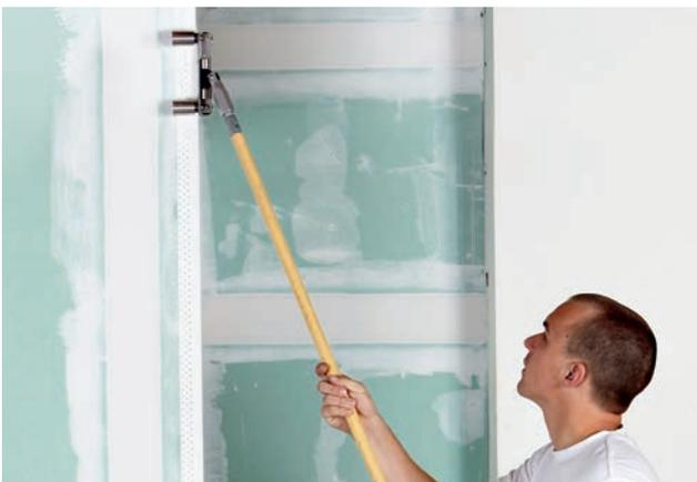
Rigips AquaBead mit dem Rigips Außenkantenroller andrücken. Achten Sie auf einen gleichmäßigen und ausreichenden Anpressdruck.
