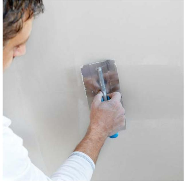
Das Spachtelmaterial wird in langen Zügen sowohl über die Querfugen ...
