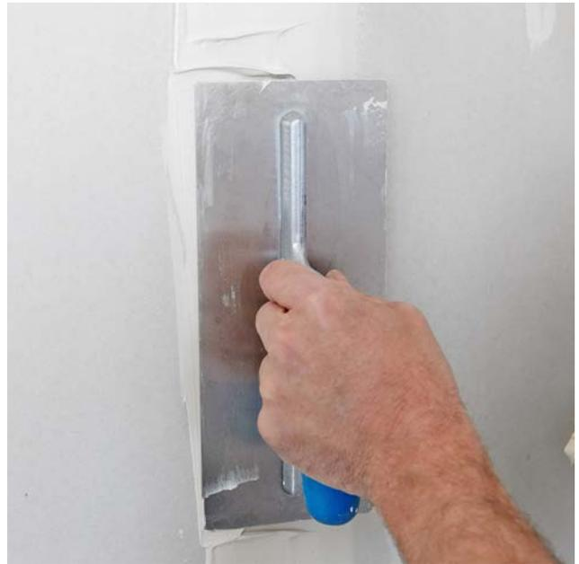
Es erfolgt danach das Abziehen der verfüllten Fugen.
