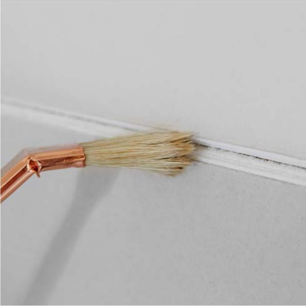
Gipsstaubentfernung für eine gute Haftung.
