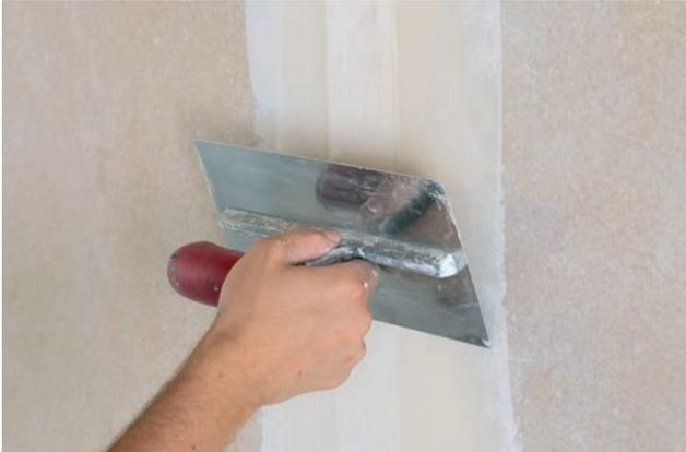
... und anschließendes Überziehen ohne zusätzlichen Materialauftrag.
