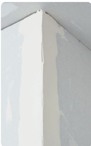
Vorlegen eines dünnen Spachtelbetts an einer Außenecke.
