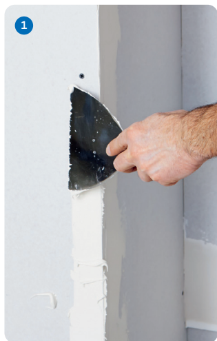
Vorlegen eines dünnen Spachtelbetts an einer Außenecke.
