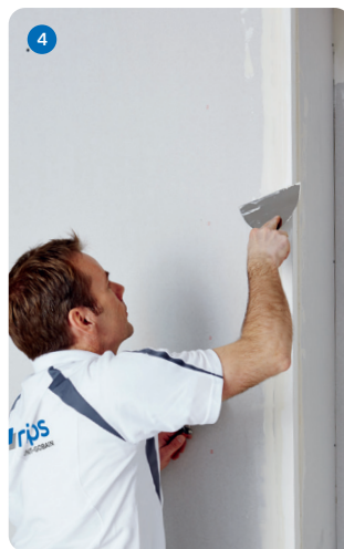
Überschüssige Spachtelmasse wegnehmen und Rest ausziehen.
