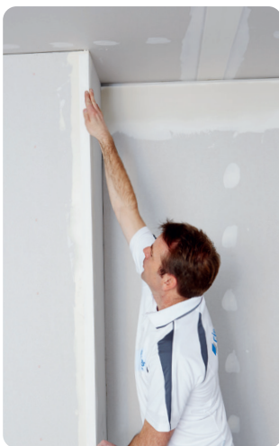
Ansetzen und Ausrichten des Rigips Levelline.
