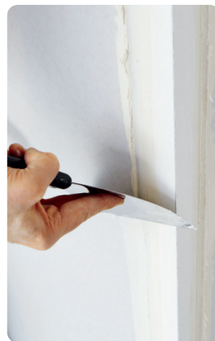
Überschüssige Spachtelmasse wegnehmen und Rest ausziehen.
