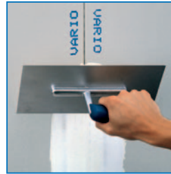
Spachteln ohne Rigips-Bewehrungsstreifen
