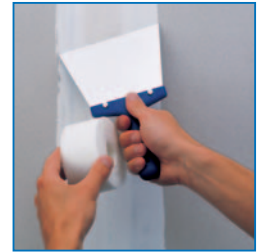
Spachteln mit Rigips-Bewehrungsstreifen
