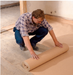
Ausrollen der Rieselschutzbahn
