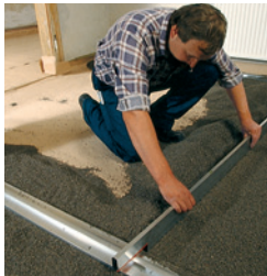
Abziehen der Rigidur Ausgleichsschüttung
