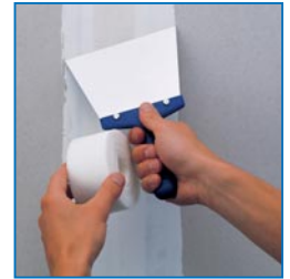
Spachteln mit Rigips-Bewehrungsstreifen
