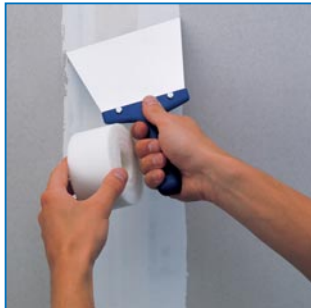
SUPER-System mit Glasfaserbewehrungsstreifen
