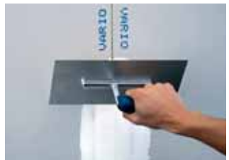
Spachteln ohne Rigips Bewehrungsstreifen
