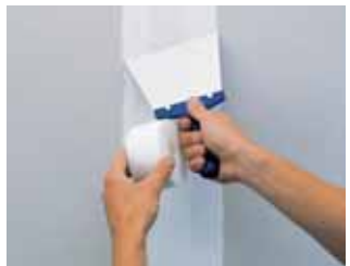
Spachteln mit Rigips Bewehrungsstreifen
