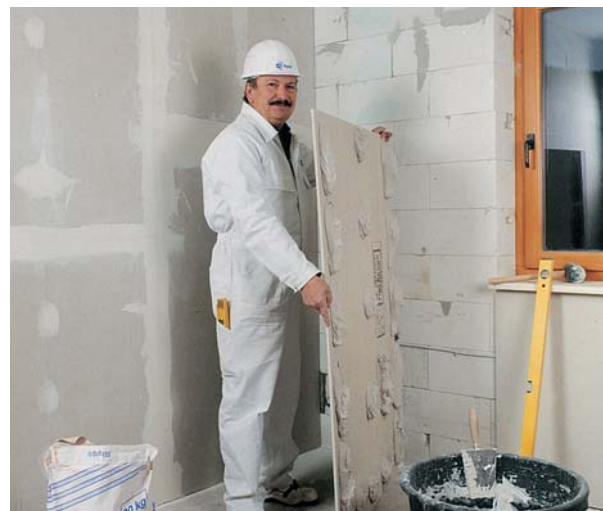
Anbringen der Rigidur-Ausbauplatte als Wandtrockenputz.
