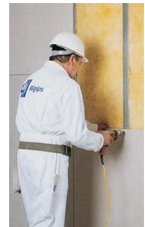
Beplankung der 2. Wandseite mit Rigidur-Ausbauplatte.
