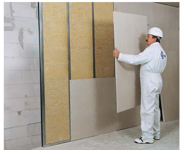
Anbringen der Rigidur-Ausbauplatte als Vorsatzschale.
