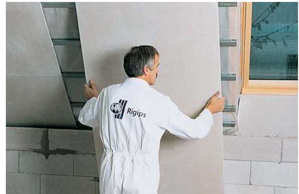
Rigidur Ausbauplatte in Dachschrägen
