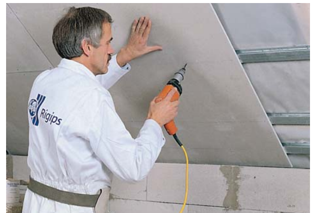
Befestigung der Rigidur-Ausbauplatte.
