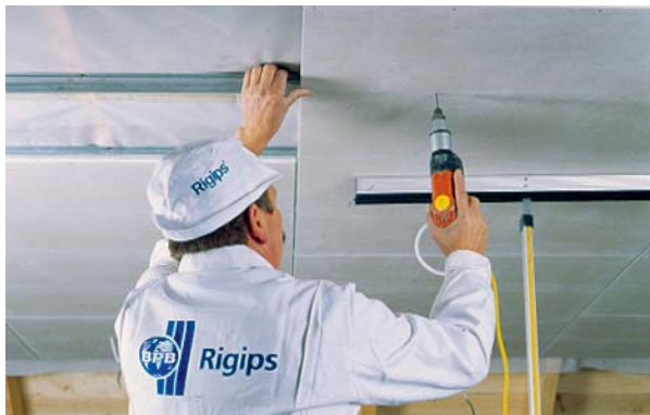
Befestigung der Rigidur-Ausbauplatte an den Hut-Deckenprofilen.
