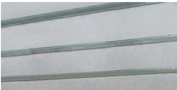
Unterkonstruktion mit Rigidur Hut-Deckenprofilen.
