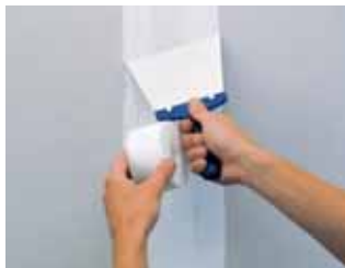
Spachteln mit Rigips Bewehrungsstreifen
