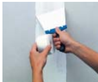
Spachteln mit Rigips Bewehrungsstreifen
