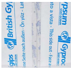
Rigips Glasroc X-Platten, Stoß mit Fugenband abgeklebt
