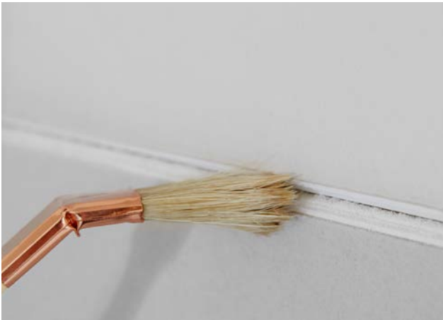
Gipsstaubentfernung für eine gute Haftung!
