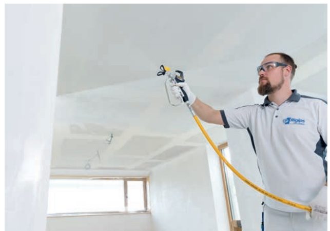
Rigips ProMix Airless in gleichmäßigen Bewegungen vollflächig auf die Wandoberfläche aufbringen.
