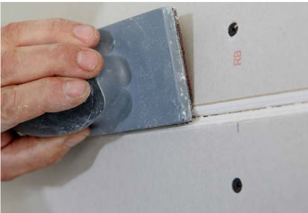
Brechen des Kartons am oberen und unteren Übergang von der Kartonoberfläche zum Gipskern.
