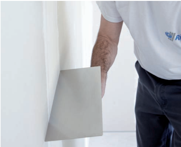
Optische Prüfung der Vorspachtelung sowie Entfernung evtl. vorstehender Spachtelgrate.
