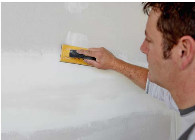
Nach kompletter Durchtrocknung des Spachtelmaterials kann die Oberfläche geschliffen werden.
