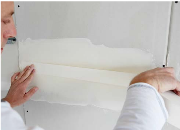
Vorsichtiges Einlegen des Rigips Papierbewehrungsstreifens.
