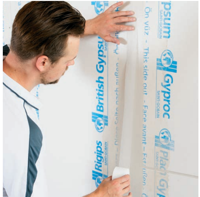
Rigips Glasfaserbewehrungsstreifen einlegen und entsprechend ablängen.
