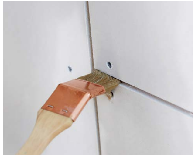
Die Plattenkanten müssen entstaubt und vorgespäst werden.
