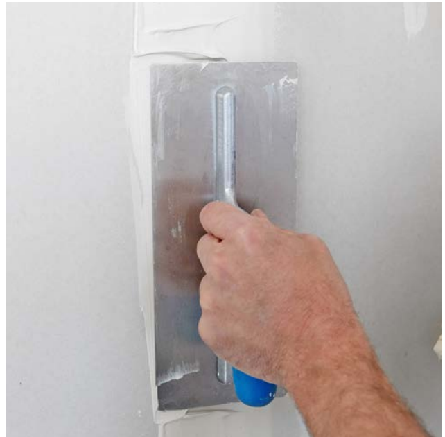
Es erfolgt danach das Abziehen der verfüllten Fugen.
