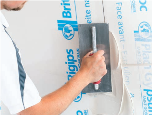
Die Längsfugen mit VARIO H Fugen- und Flächenspachtel quer zur Fuge verfüllen.
