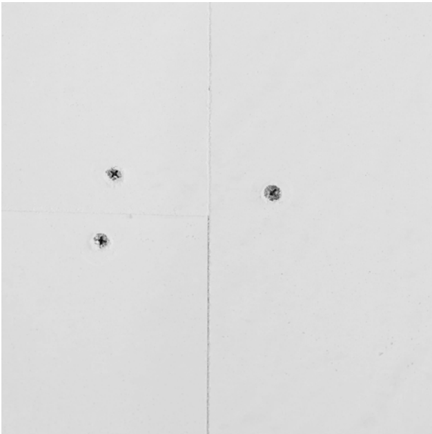
Die Platten werden stumpf gegeneinander gestoßen und befestigt.
