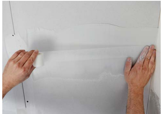
Einlegen des Rigips Glasfaserbewehrungsstreifens.
