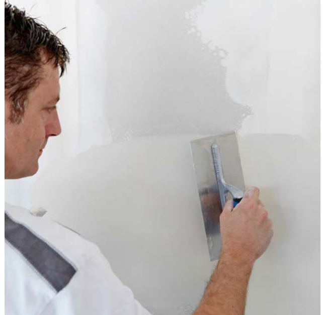
Ist das Material der Vorspachtelung abgebunden, kann die Nachspachtelung ebenfalls mit VARIO Fugenspachtel erfolgen.
