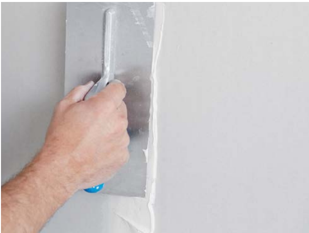
Die Längsfugen werden mit Spachtelmaterial ausgedrückt.
