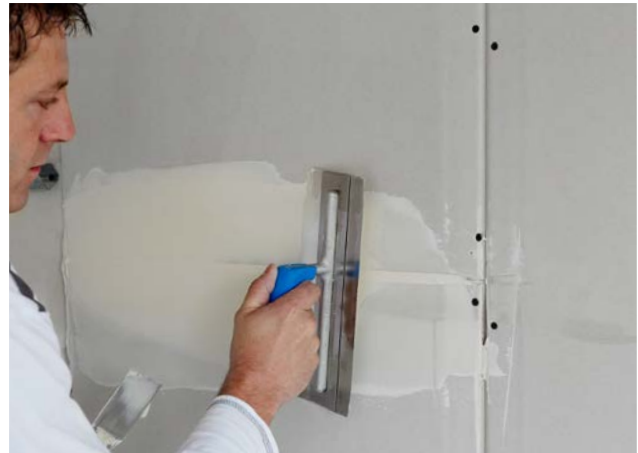
Vorlegen eines ca. 1 mm dicken Spachtelbettes.
