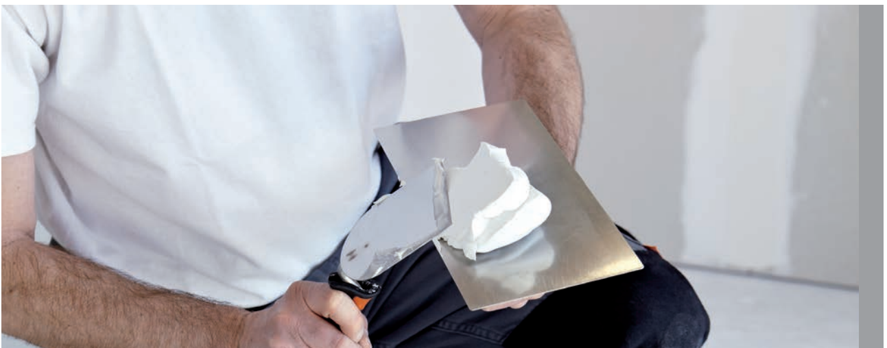
Die sofort gebrauchsfertige hochweiße Feinspachtelmasse wird direkt dem Eimer entnommen und verarbeitet.
