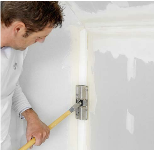
Anpressen des Rigips Levelline mit dem Rigips Innenkantenroller.
