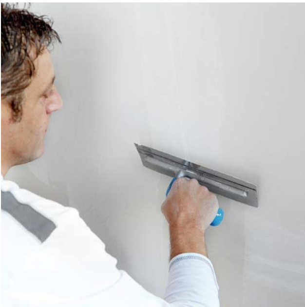
... als auch über die Längsfugen aufgetragen.
