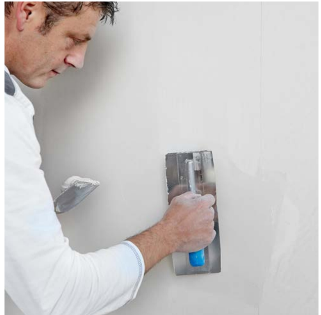
Der VARIO Fugenspachtel wird aufgebracht und flächenbündig abgezogen.
