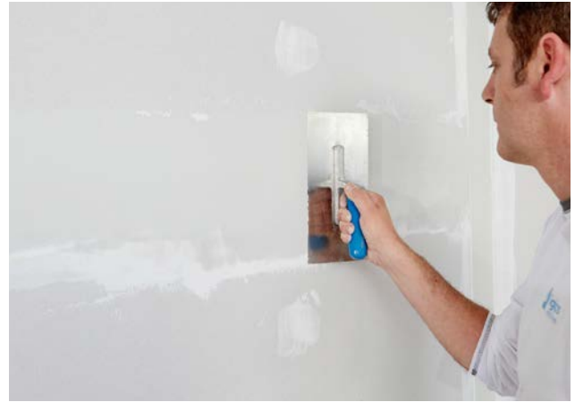
Überziehen des Rigips Glasfaserbewehrungsstreifens ohne zusätzlichen Materialauftrag.
