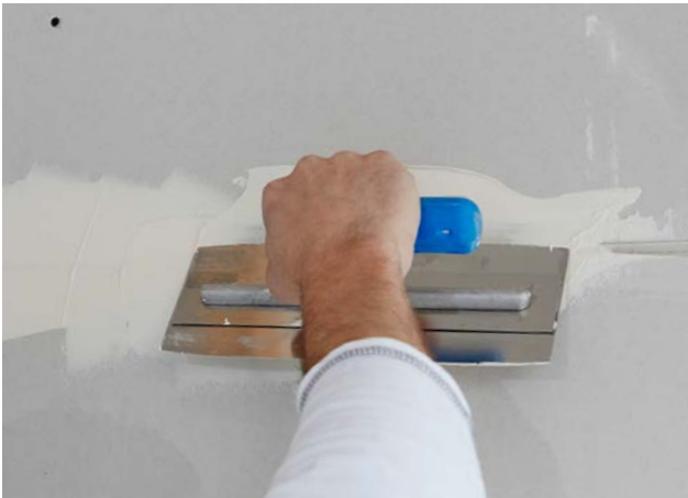
Ausdrücken der Querfugen.
