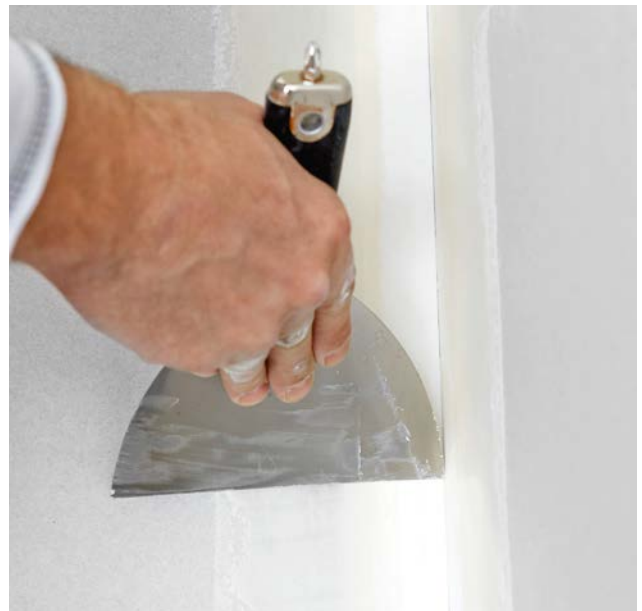
Abziehen des überschüssigen Spachtelmaterials.
