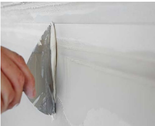
Abziehen des überschüssigen Fugenspachtels.
