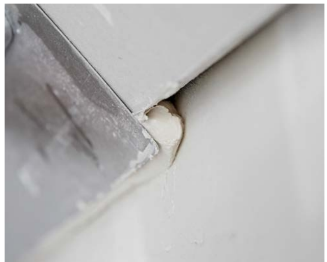
Ausdrücken der Anschlussbereiche mit Fugenspachtel.
