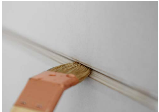
Das Vornässen der Querkante ist wichtig, damit der Spachtelmasse nicht zu schnell das Wasser entzogen wird.
