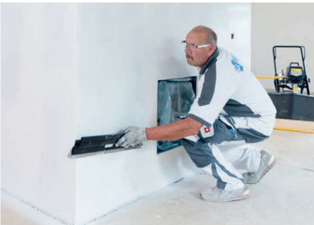
Die frisch aufgetragene Spachtelmasse mit einem Flächenspachtel glatt abziehen und vollständig trocknen lassen.
