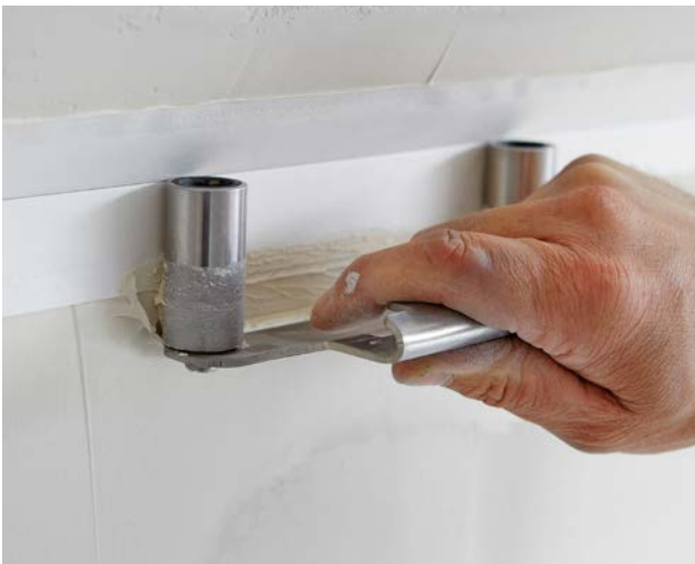
Anpressen des Rigips Levelline mit dem Rigips Einseitenroller sowohl auf der unteren Flanke des Rigips Levelline ...
