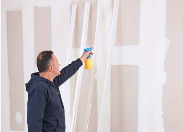
Rigips AquaBead Flex PRO ansprühen und Kleber aktivieren. Rationelles und wirtschaftliches Arbeiten durch die Vorbereitung mehrerer ECKleisten.
