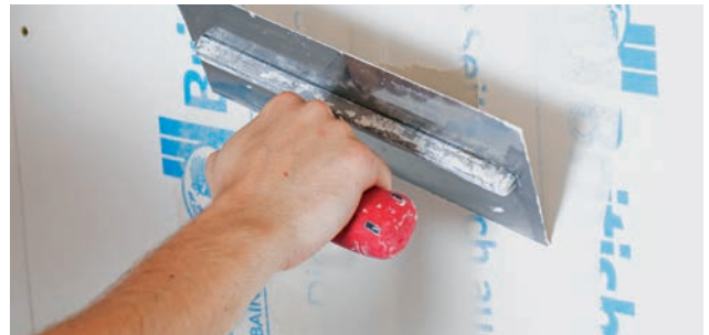
Rigips Glasfaserbewehrungsstreifen einlegen und entsprechend ablängen.
