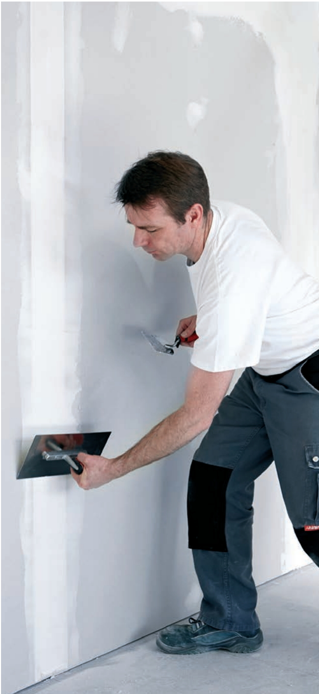
Der ProMix Finish wird auf den Untergrund mithilfe eines Glättspachtels aufgetragen.
