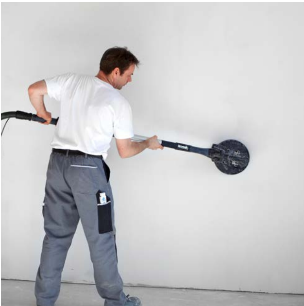
Eventuell Spachtelgrate manuell oder maschinell nachschleifen.
