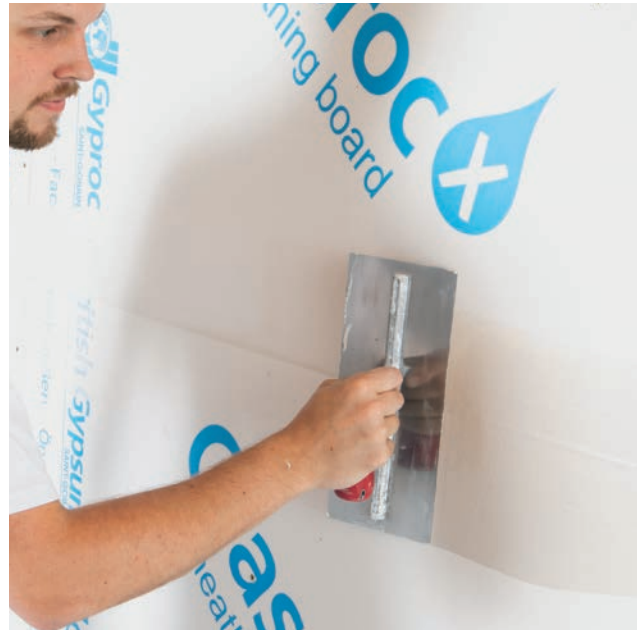
Vorlegen eines ca. 1 mm dicken Spachtelbettes...
