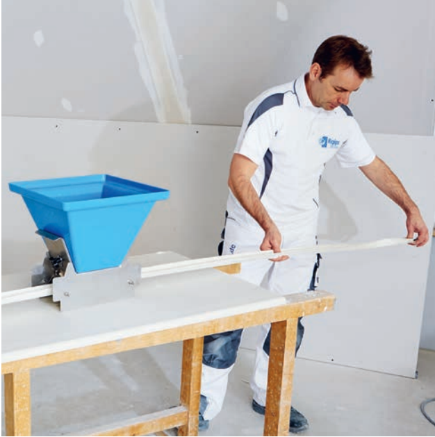
Die zugeschnittenen Rigips Levelline Profile werden zügig durch den Auftragsbehälter gezogen ...
