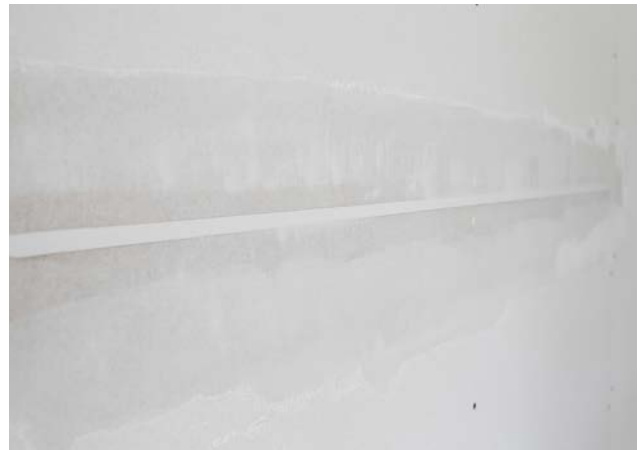
Spachtel abbinden lassen.
