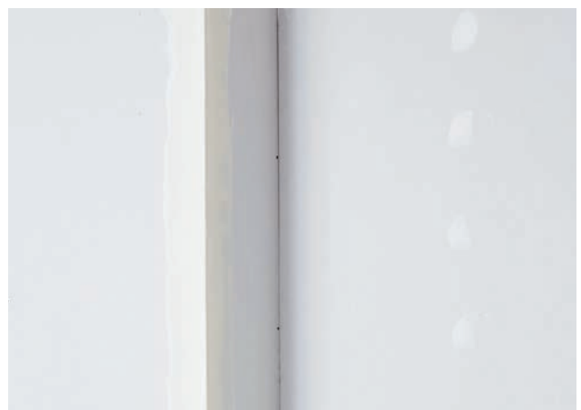
Fertige Außenkante mit Rigips Levelline .
