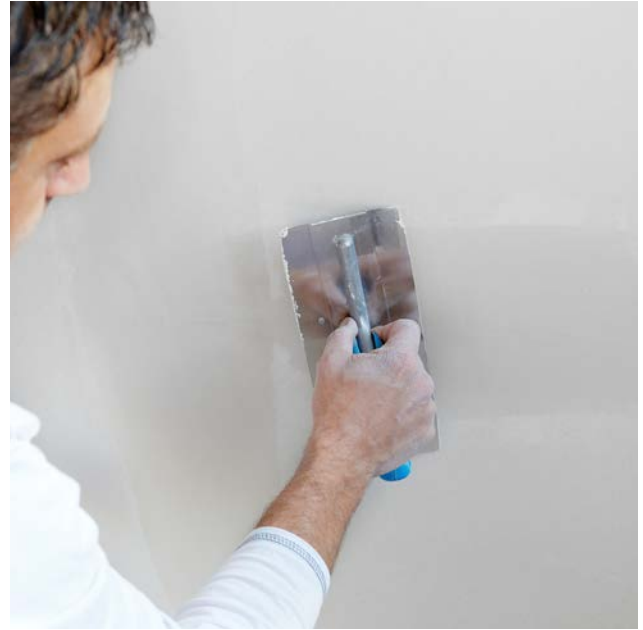
Das Spachtelmaterial wird in langen Zügen sowohl über die Querfugen ...
