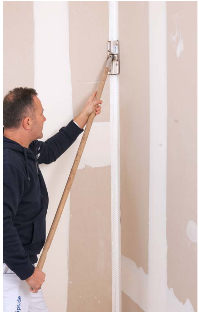
...oder bei einer Innenkante mit dem Rigips Innenkantenroller. Die Verarbeitungsabläufe sind gleich einer Außenkante. Lediglich die Verformung des Rigips AquaBead Flex PRO erfolgt mit der Klebeseite dann gemäß der Innenkante nach innen.
