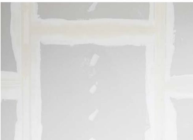
Ergebnis der Wandfläche nach Einlage des Rigips Papierbewehrungsstreifens.
