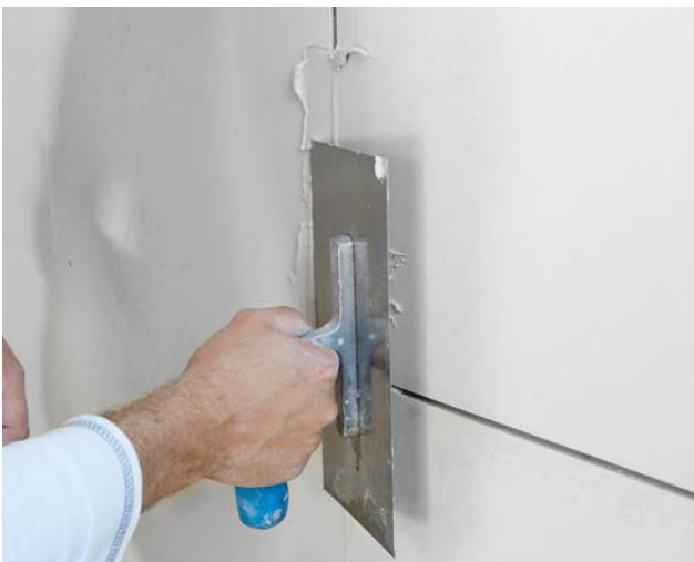
Ausdrücken der Querfugen mit VARIO Fugenspachtel, ...
