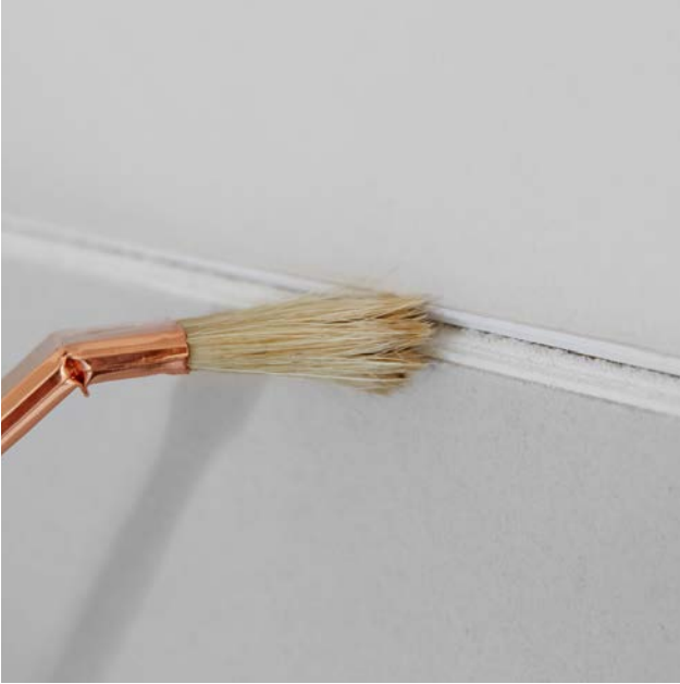
Gipsstaubentfernung für eine gute Haftung.
