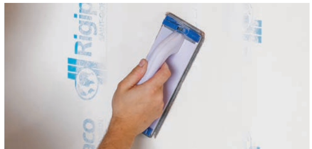
Nach ausreichender Trocknung erfolgt die Nachspachtelung mit dem VARIO H Fugen- und Flächenspachtel. Abhängig von der Anforderung der Oberflächenqualität kann noch ein Schleifen bzw. ein weiterer Überzug mit Spachtelmaterial bis zur Erreichung der geforderten Qualitätsstufe notwendig sein.
