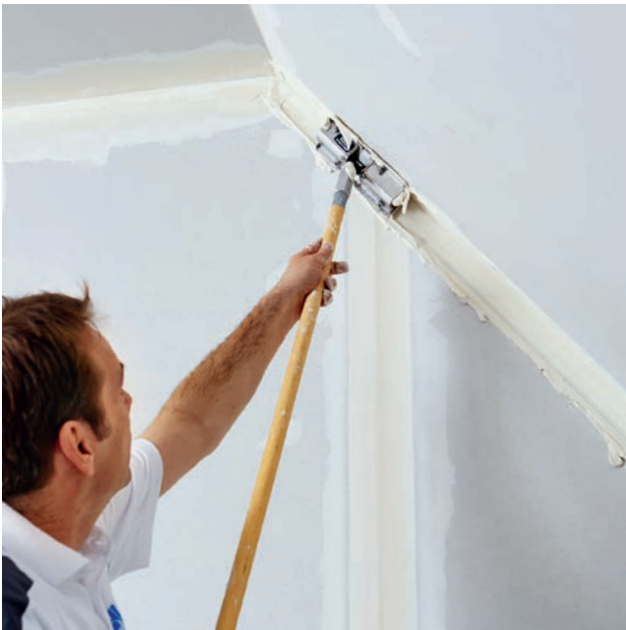
... anschließend mit dem entsprechenden Kantenroller anpressen.
