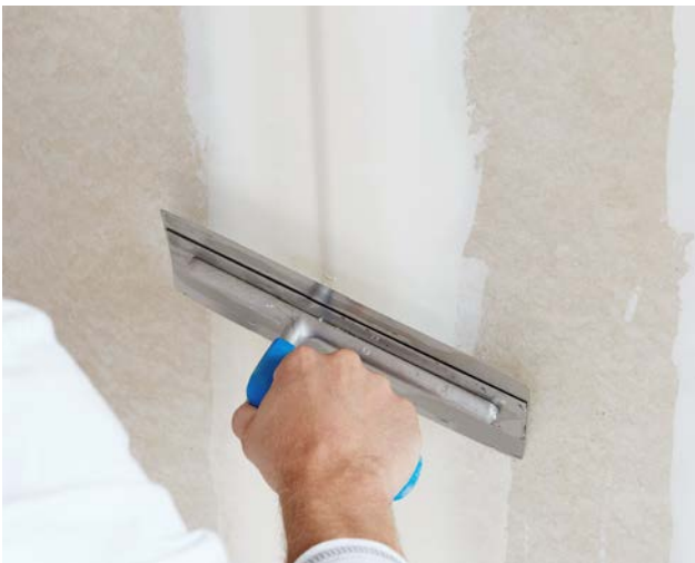
Zur Erzielung einer perfekten Wandoberfläche erfolgt die Nachspachtelung ebenfalls mit VARIO Fugenspachtel.
