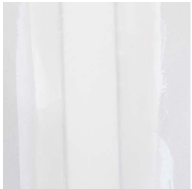
Die fertige Längsfuge nach dem Abziehen.
