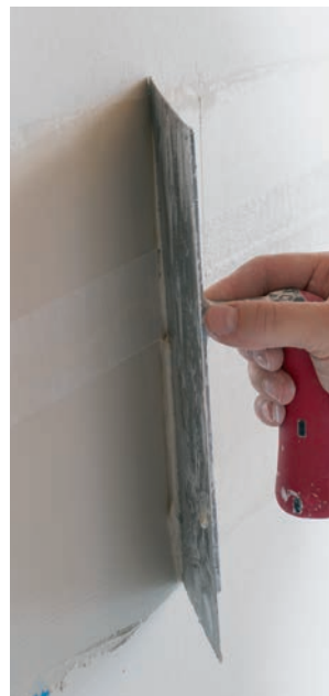
Überziehen des Rigips Glasfaserbewehrungsstreifens ohne zusätzlichen Materialauftrag.
