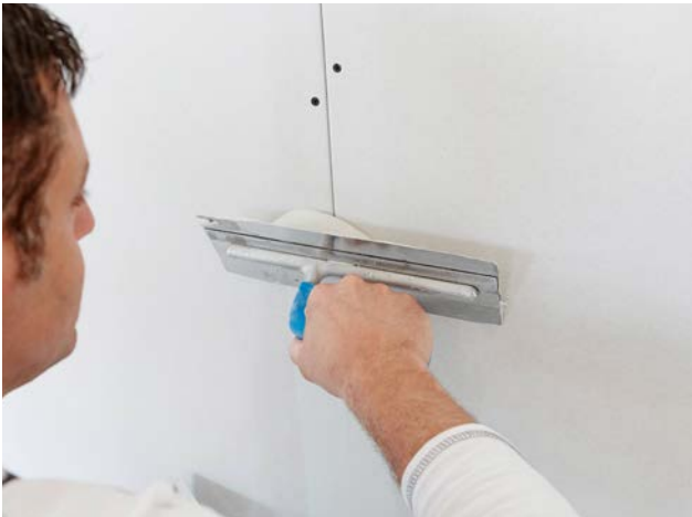
Die Längskante mit SUPER Fugenfüller ausspachteln.
