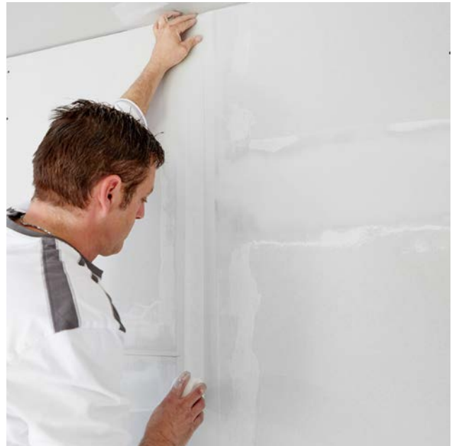
Rigips Glasfaserbewehrungsstreifen von oben einlegen und ...
