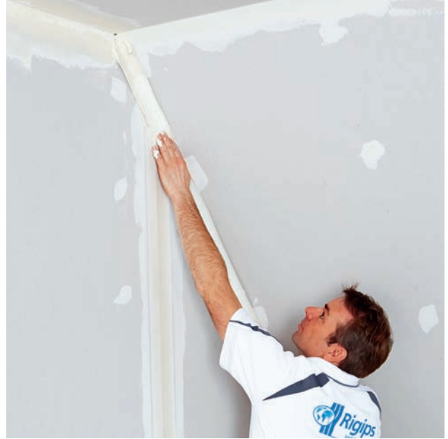
... und direkt auf die jeweilige Ecksituation aufgebracht. Von Hand leicht andrücken, ausrichten und ...
