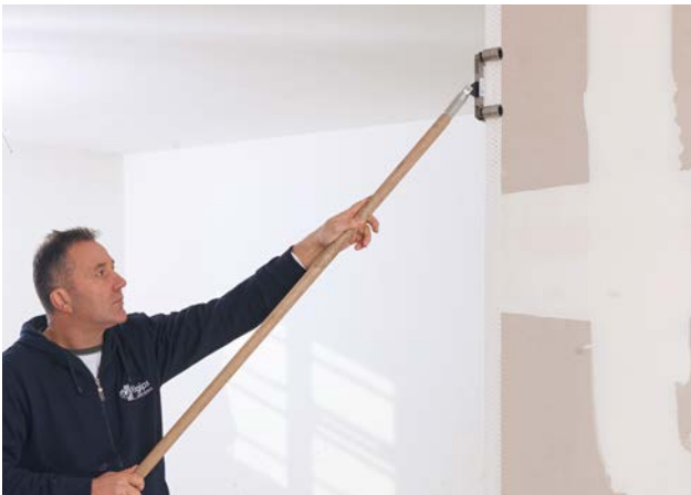
Anpressen mit dem Kantenroller, bei der Außenecke - wie hier gezeigt - mit dem Rigips Außenkantenroller für 90°- Winkel...
