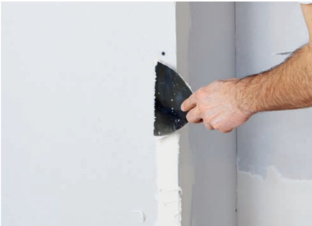
Vorlegen eines dünnen Spachtelbettes.
