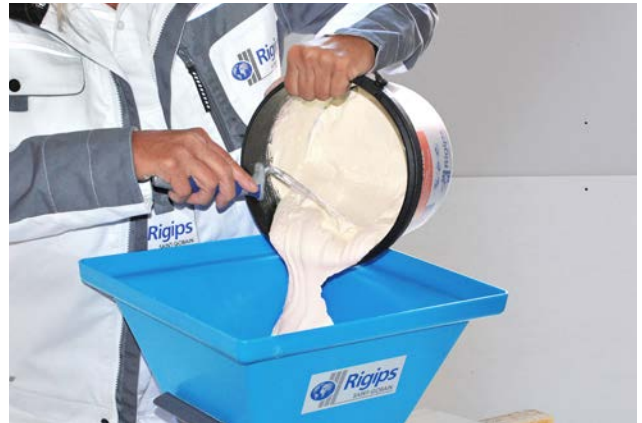
... und dann in den Rigips Auftragsbehälter eingefüllt.
