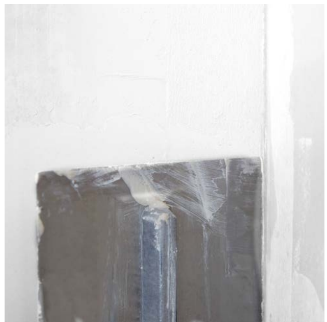
Vorsichtiges Überziehen des Rigips Glasfaserbewehrungsstreifens ohne zusätzlichen Materialauftrag. Nach dem Abbinden des Fugenspachtels erfolgt das anschließende Finish.
