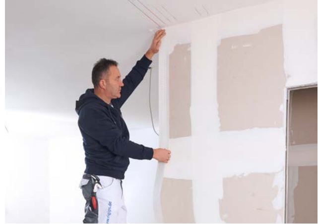
Ablängen des Rigips AquaBead Flex PRO direkt aus der Rollenverpackung heraus.
